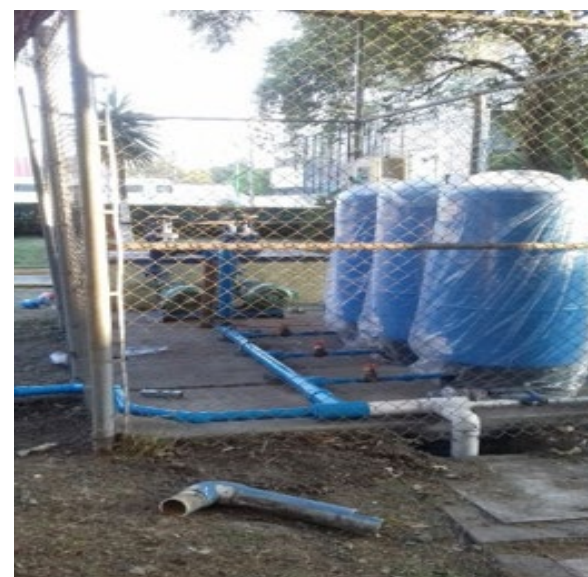
Mantenimiento a los sistemas hidroneumáticos del CECyT 2 "Miguel Bernard"
