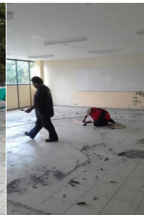
Adecuación del laboratorio de Química III a aula, en el edificio de Talleres del CECyT 2 "Miguel Bernard"
