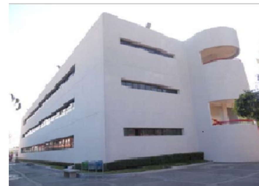
Reacondicionamiento de fachada edificio "C"
