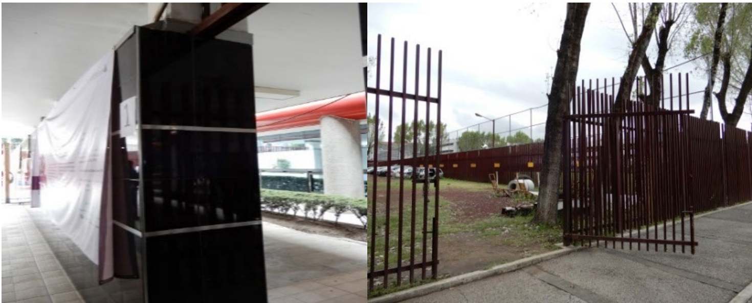
Reparación del muro de la fachada principal de la Unidad Académica
