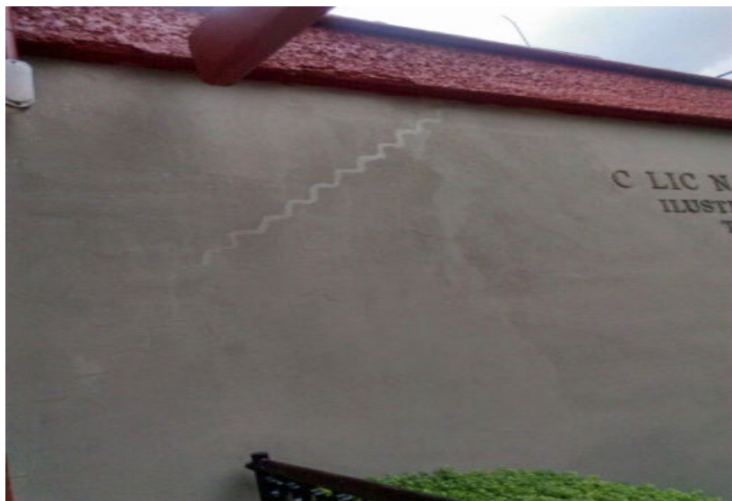
Reparación de grietas en Servicio Médico
