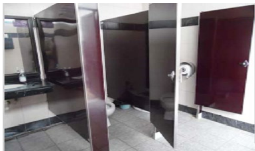
Sustitución de mamparas de sanitarios
