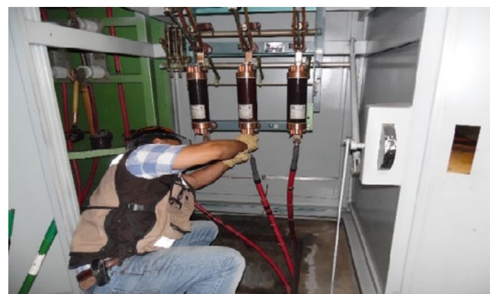
Mantenimiento preventivo y correctivo a subestación eléctrica
