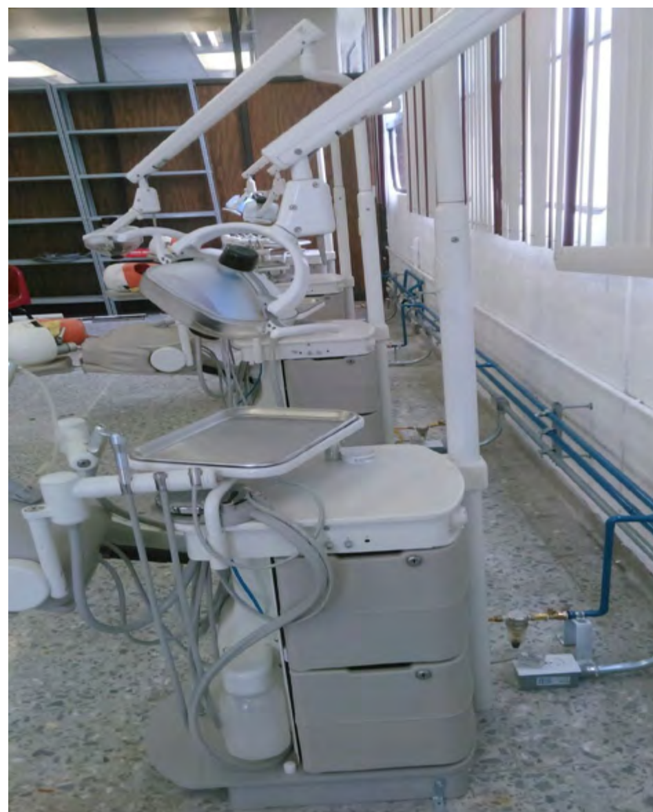
Cambio de tubería de laboratorio de simuladores de odontología
