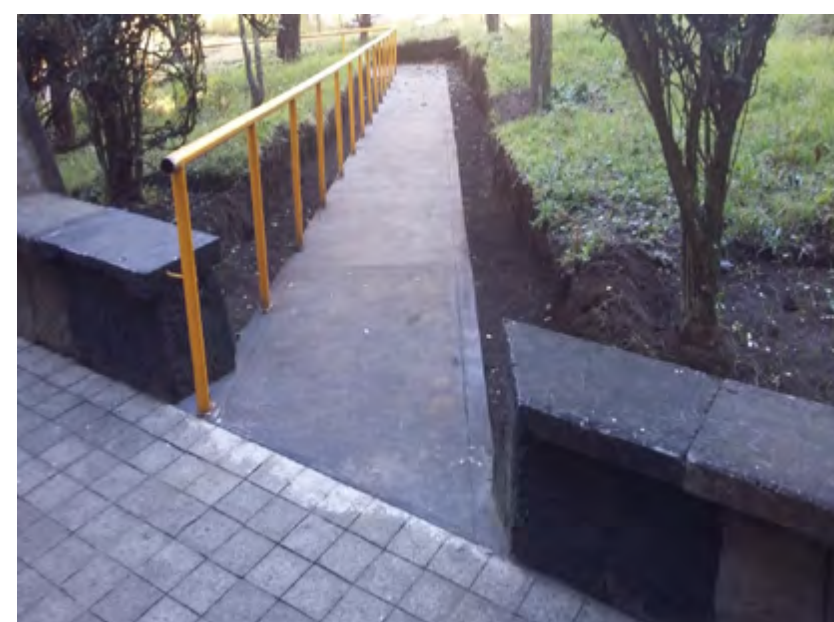
Rampas de acceso
