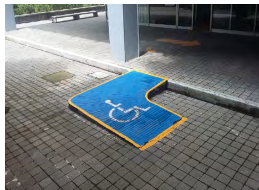
Repintado de rampas de acceso
