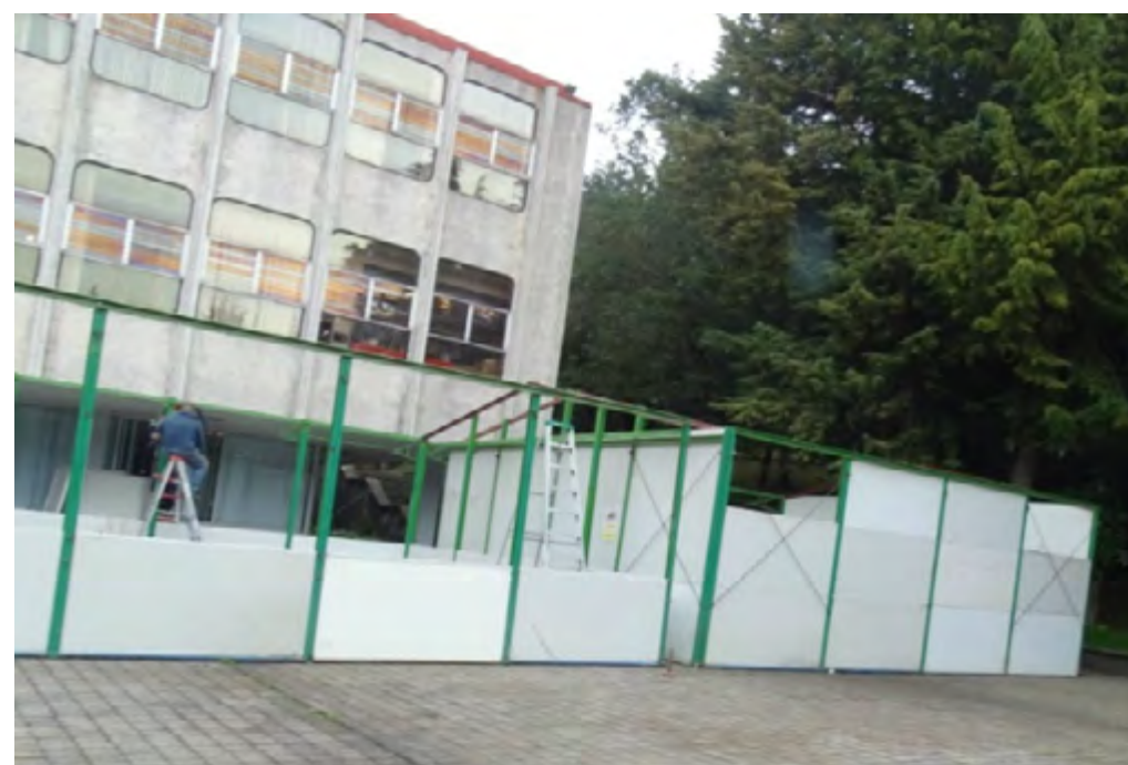
Instalación aulas prefabricadas
