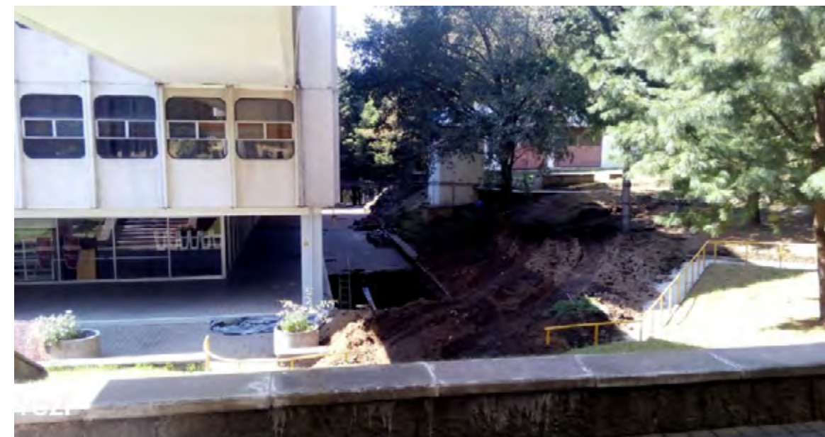
Instalación escaleras de emergencia
