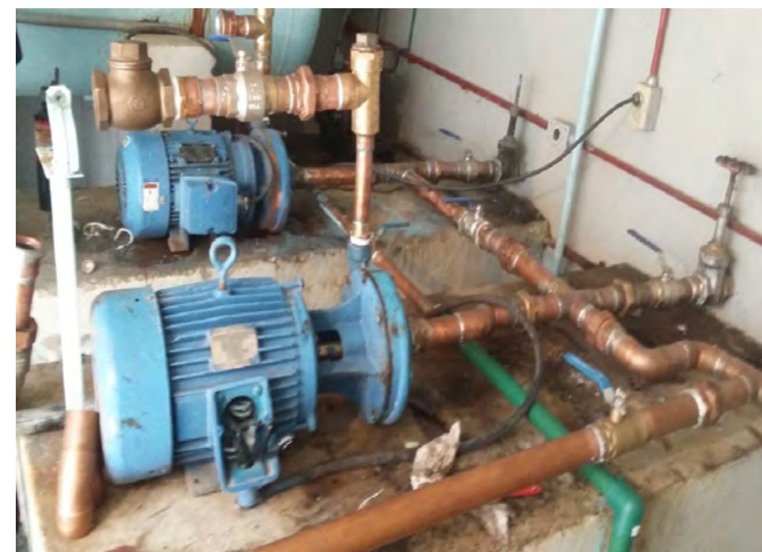
Mantenimiento cuarto de bombas
