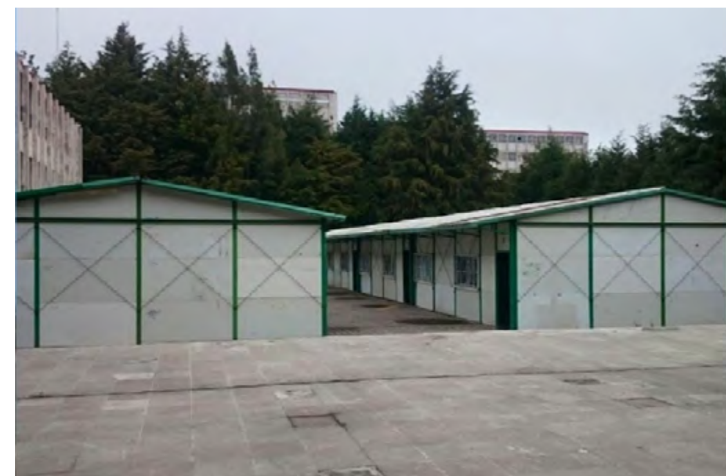
Entrega de aulas prefabricadas
