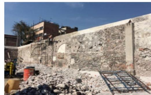
Reconstrucción de la barda del estacionamiento, debido al daño causado por el sismo de septiembre
