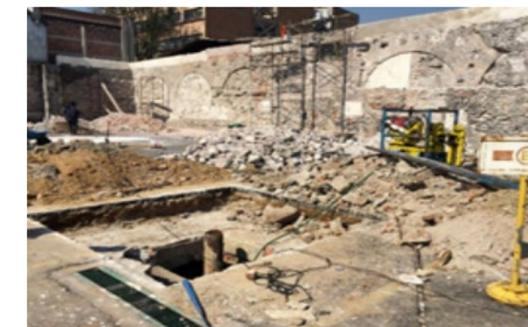
Excavación y reparación de socavón en estacionamiento
