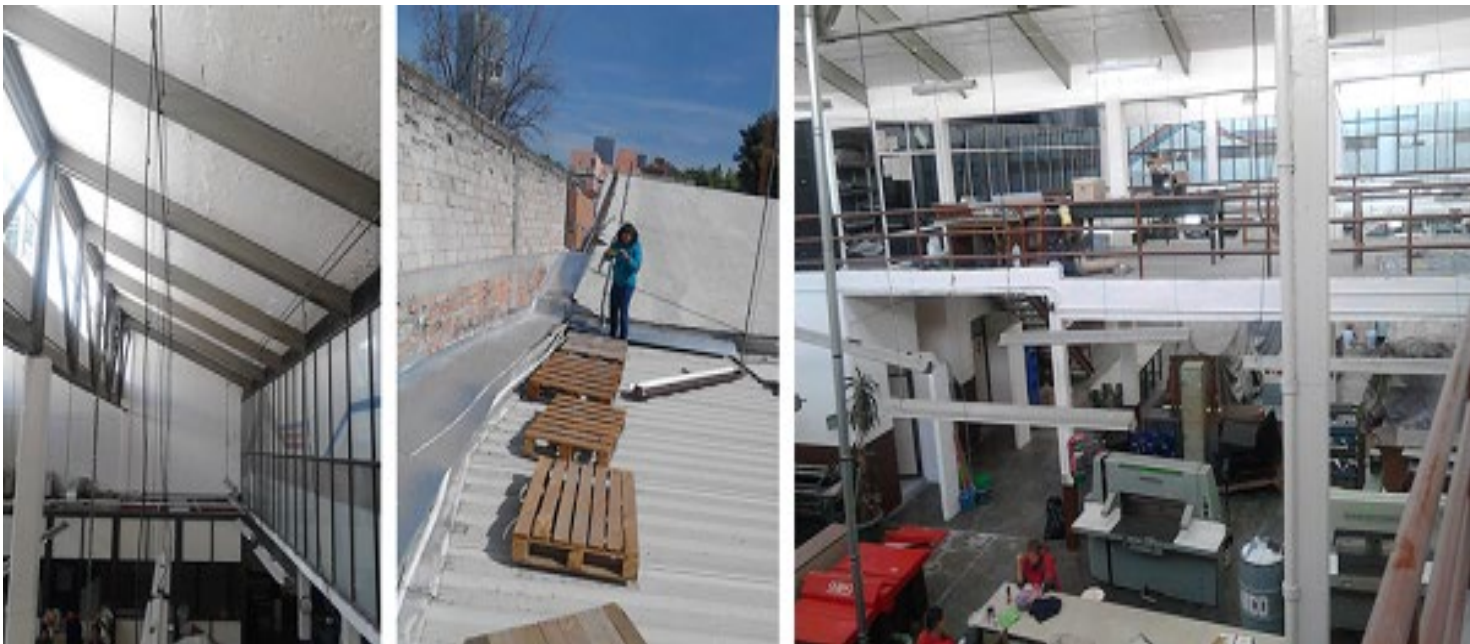
Sellado de juntas y cambio de ventanería
