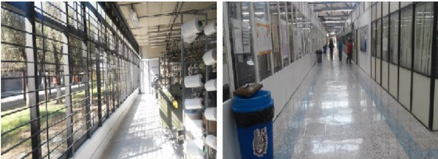
Cancelerías, pasillos y trabajos complementarios
