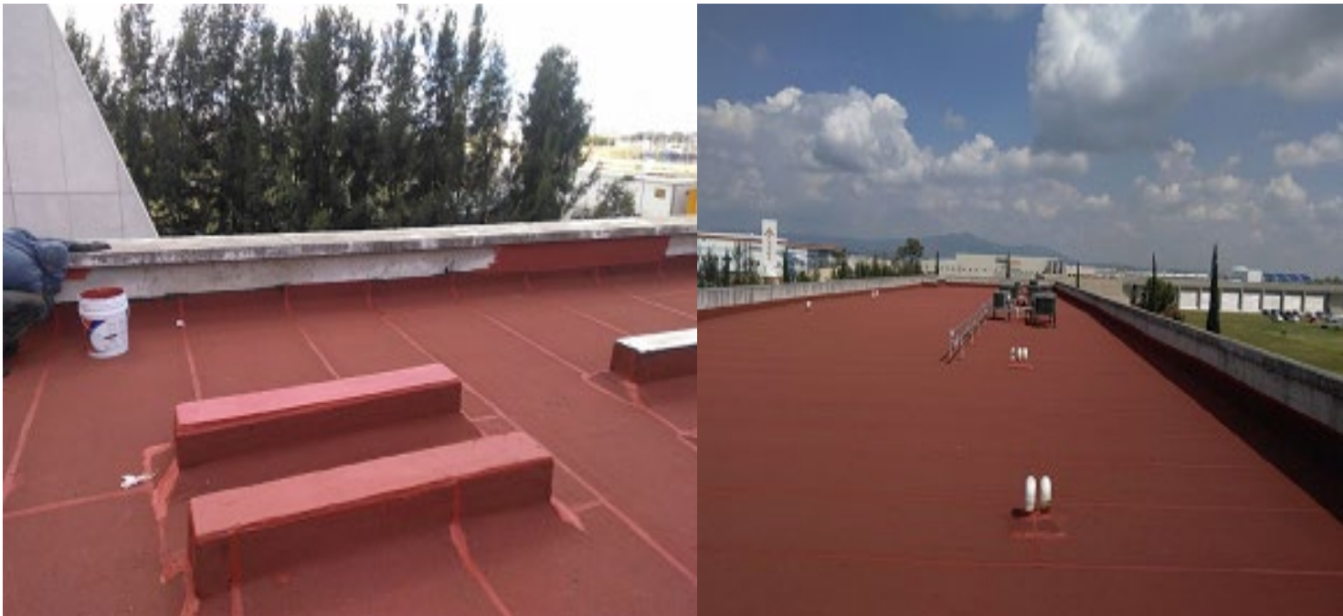
Colocación Impermeabilizante en azotea
