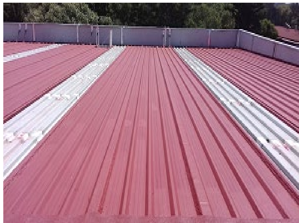
Impermeabilizado de cubierta
