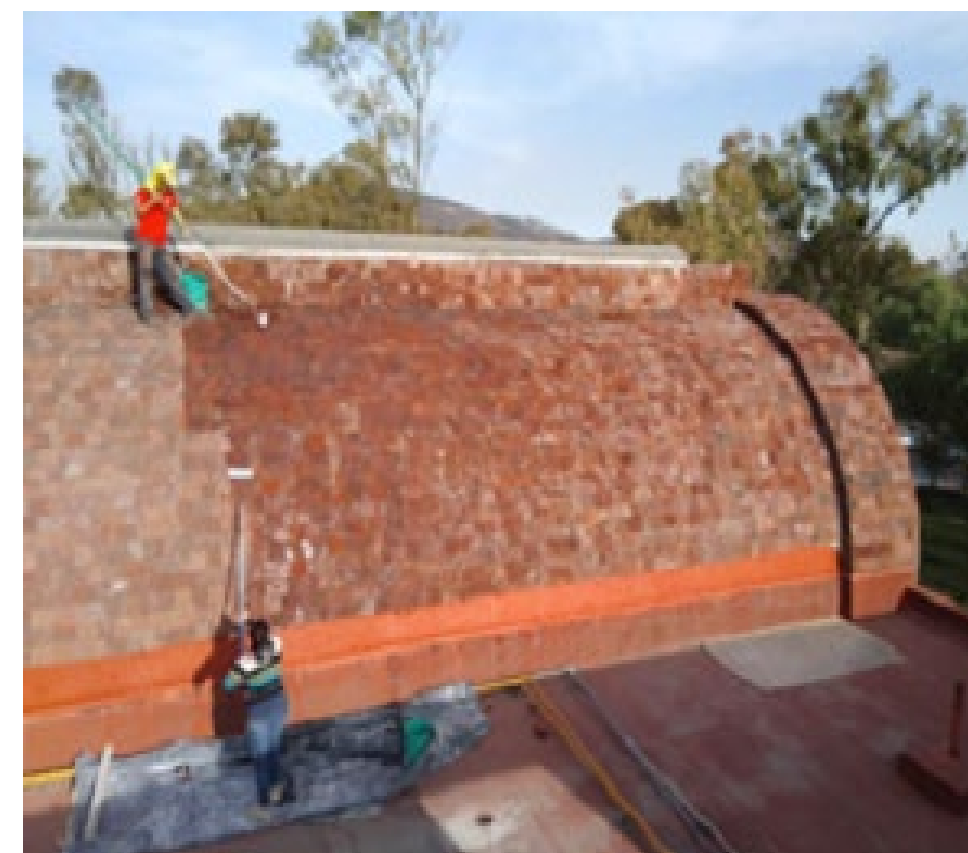
Limpieza y sellado de Bóvedas
