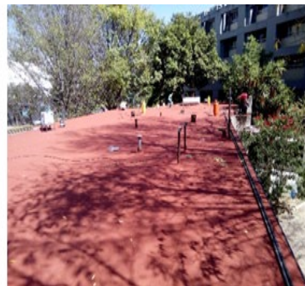
Impermeabilizante en andadores y edificios
