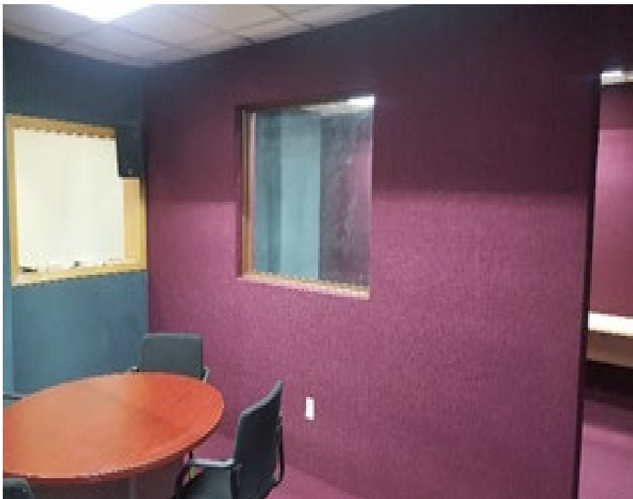
Trabajo de pintura
