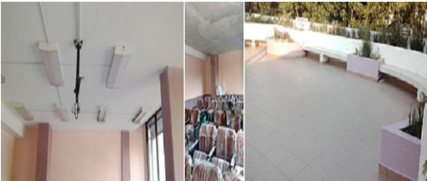
Rehabilitación de Audiovisual
