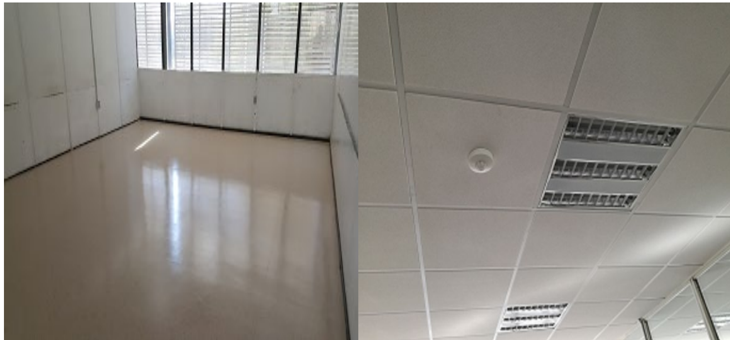
Mantenimiento de piso
