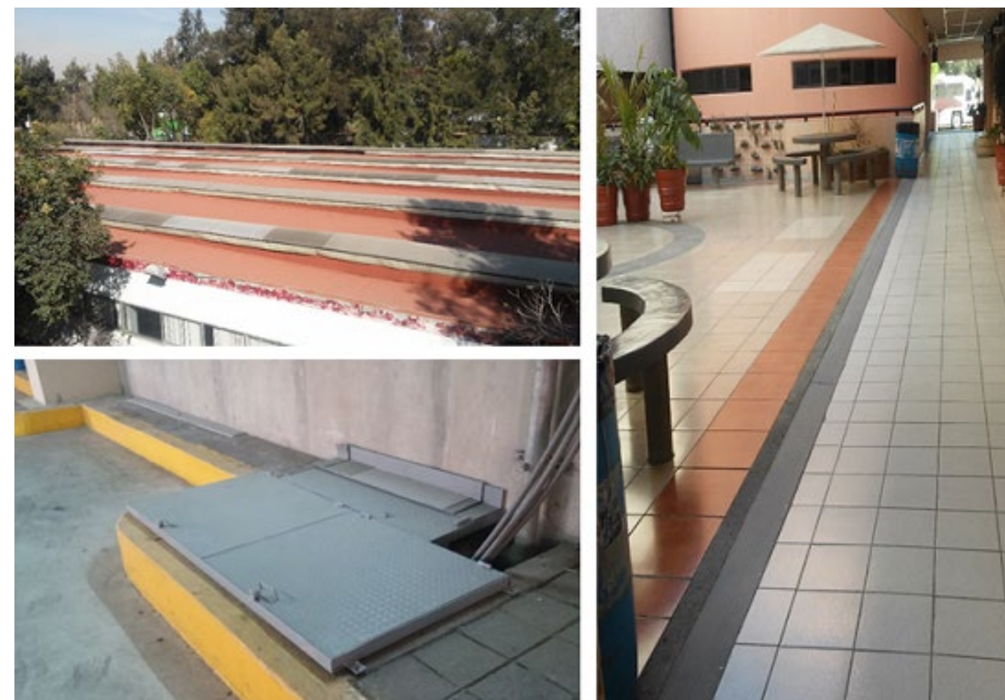
Impermeabilización, juntas constructivas, trabajos complementarios
