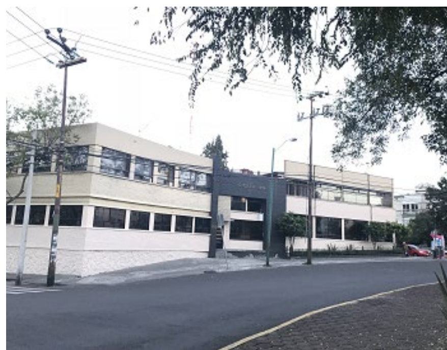
Mantenimiento en fachada principal
