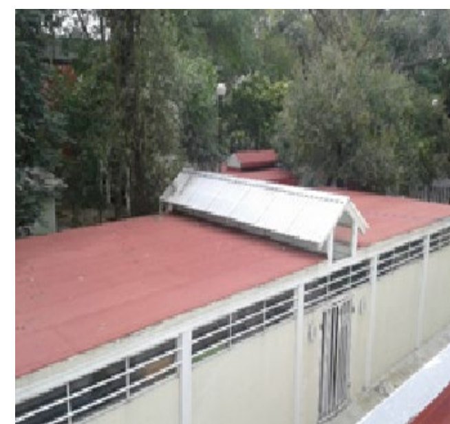
Impermeabilizante en azoteas
