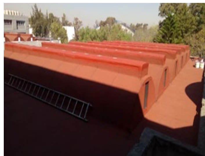
Impermeabilizante en azoteas
