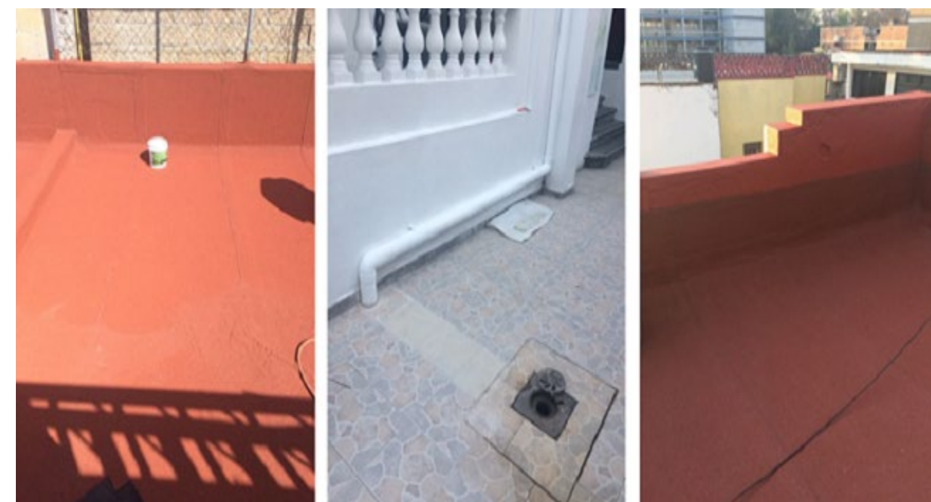
Rehabilitación de b.a.p. e impermeabilización
