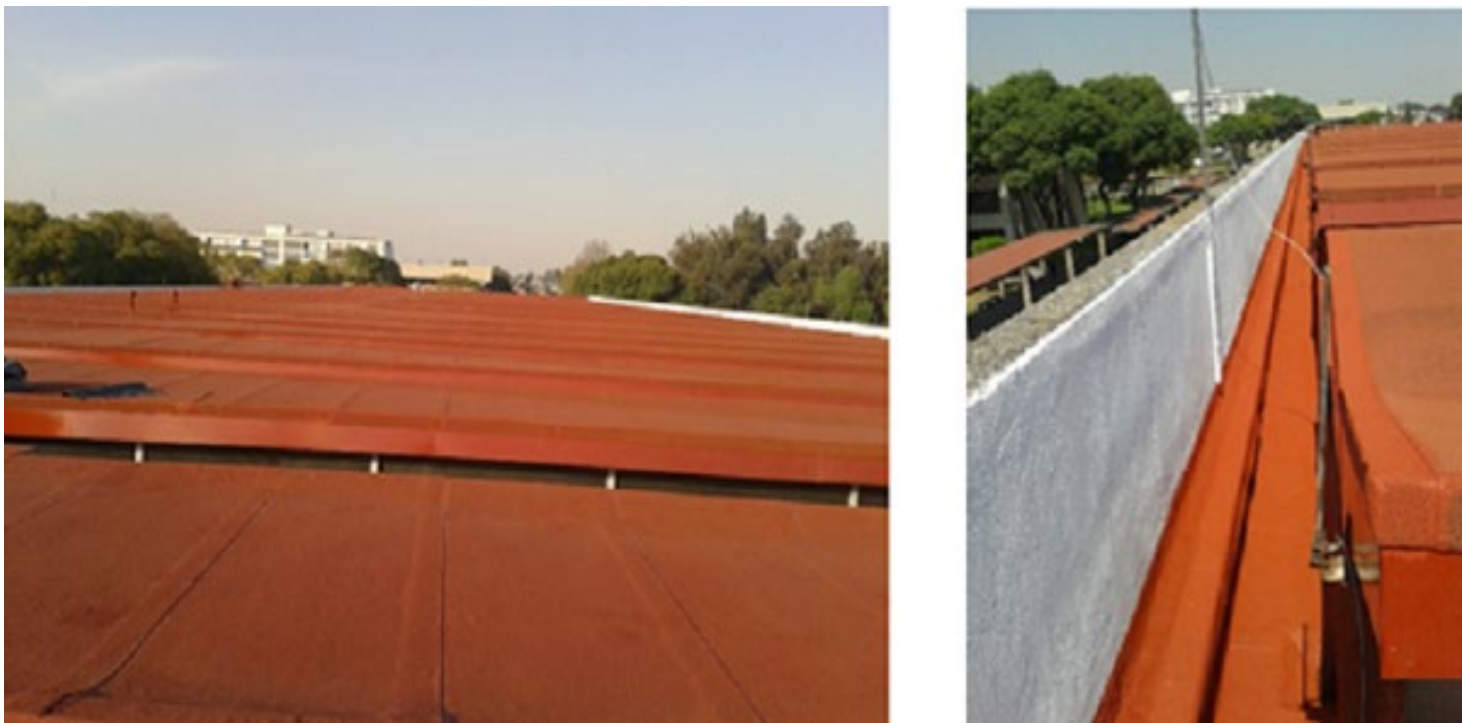
Cambio de impermeabilizante en azotea
