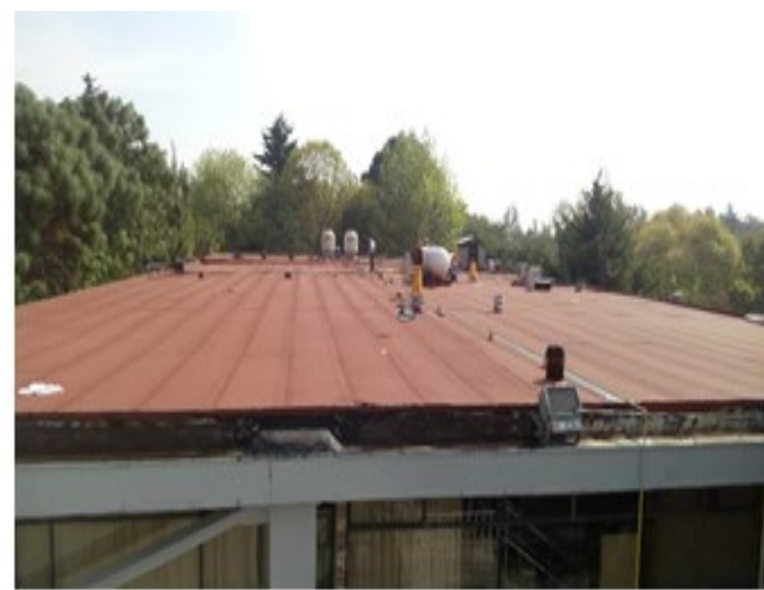
Impermeabilizante en azoteas
