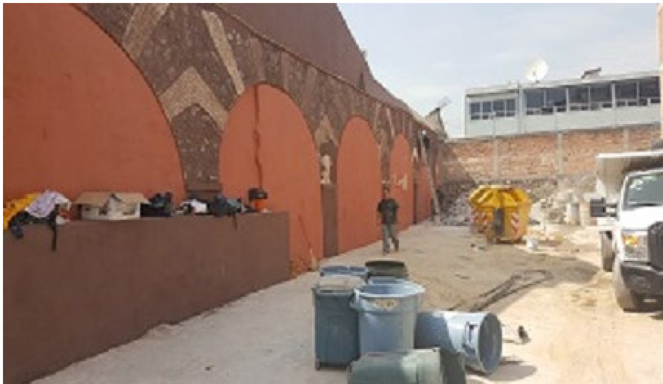
Restauración en muro
