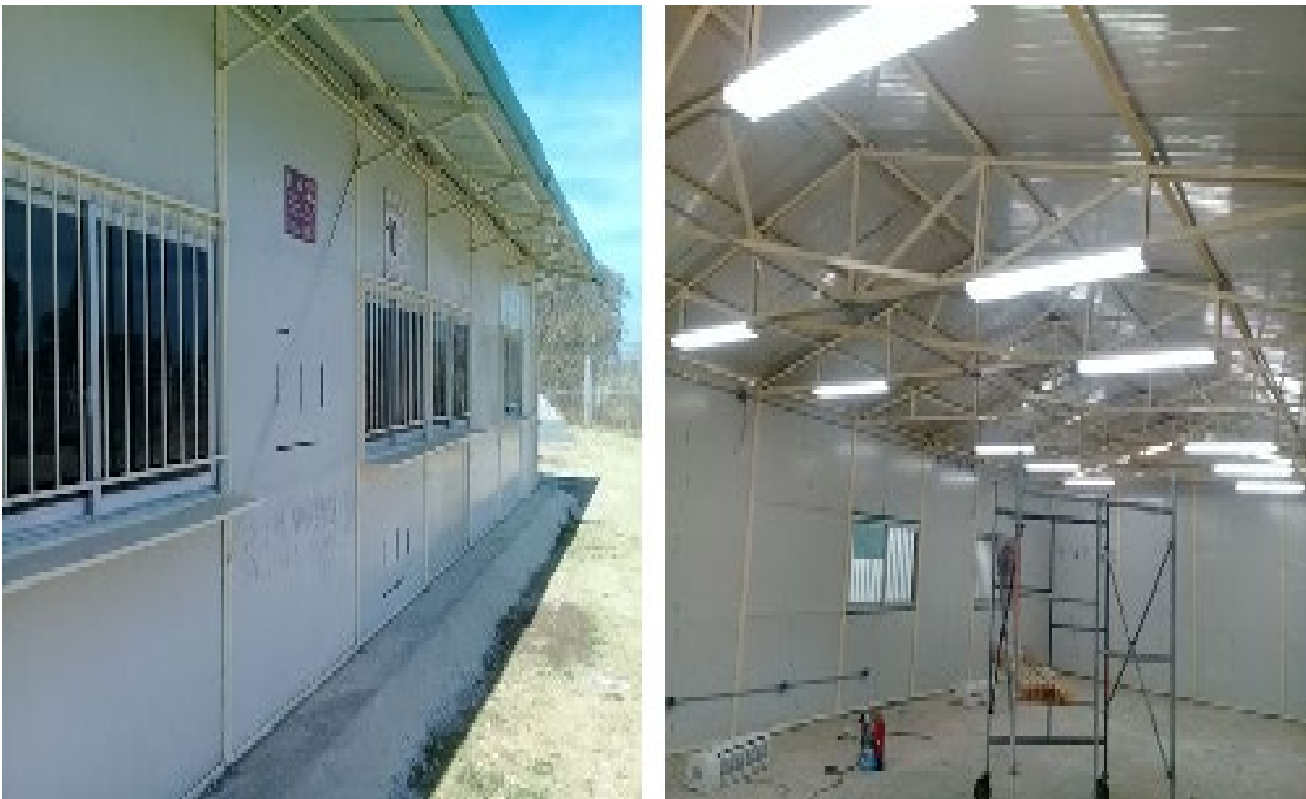
Rehabilitación de espacios
