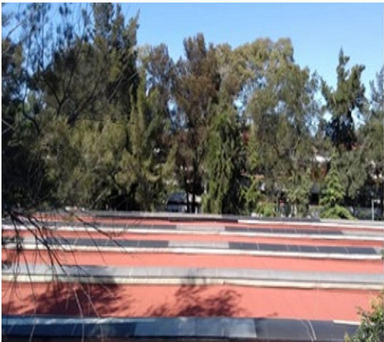
Azotea y reja perimetral
