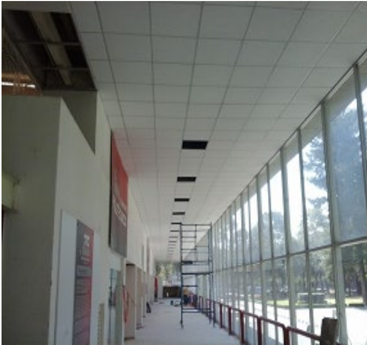
Luminarios en pasillos
