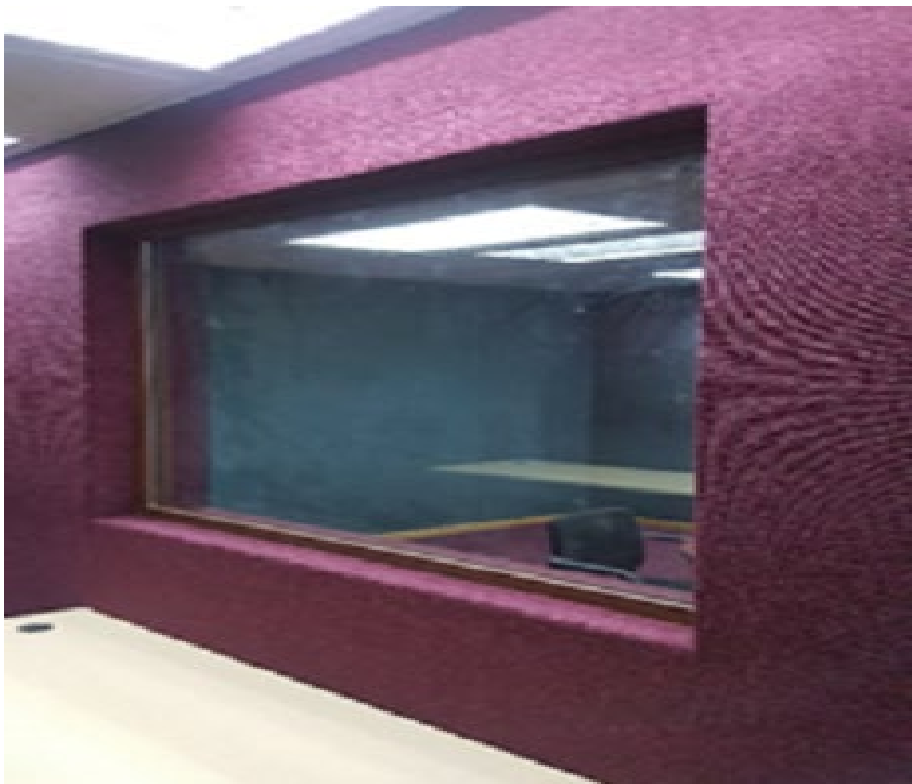
Trabajos de pintura
