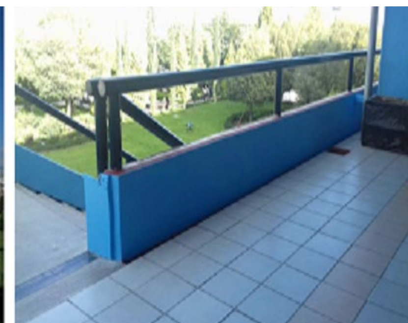
Mantenimiento en fachadas y muretes en pasillo
