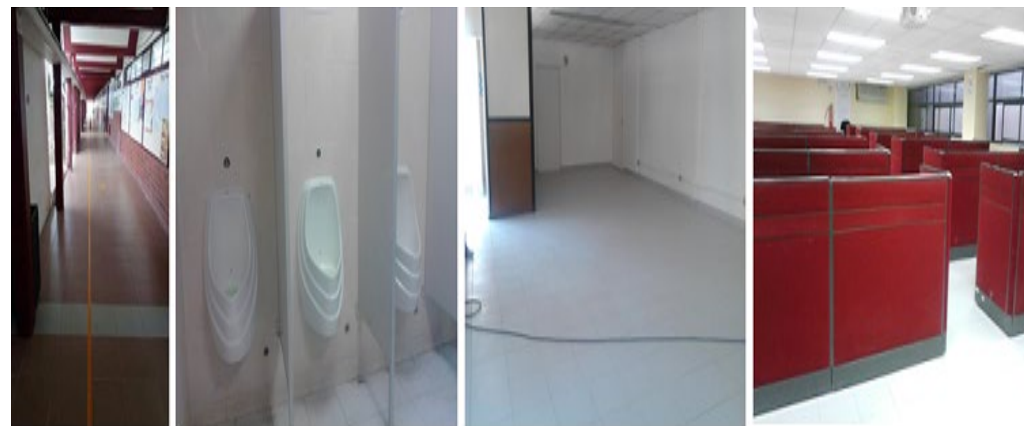
Mantenimiento y trabajos complementarios
