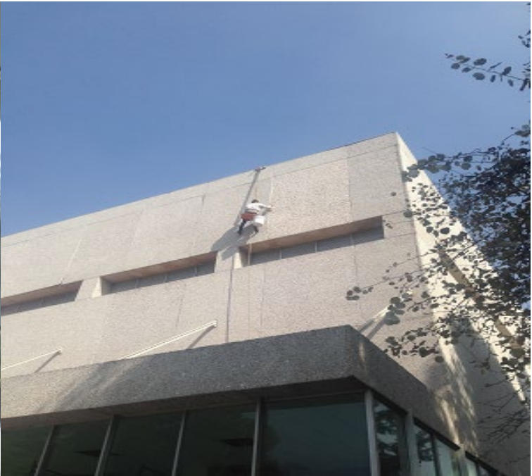
Mantenimiento a módulos en fachadas
