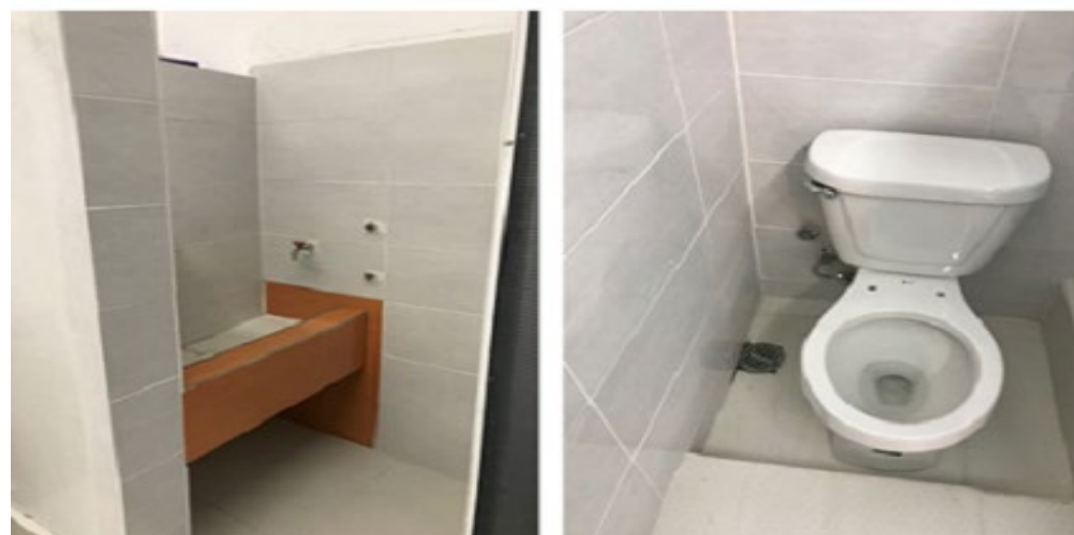
Mantenimiento a núcleos sanitarios
