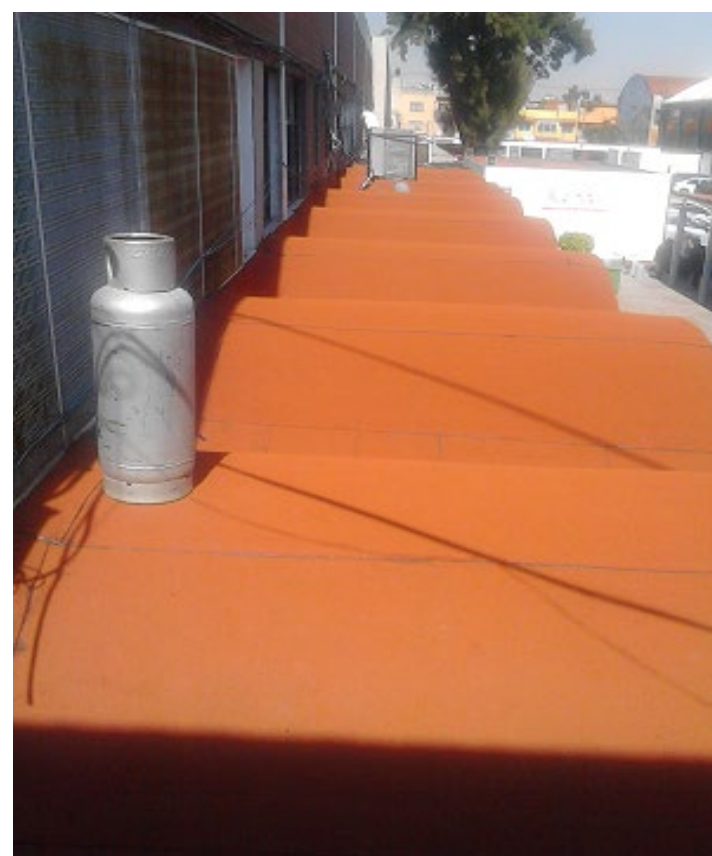
Trabajos de impermeabilización azotea
