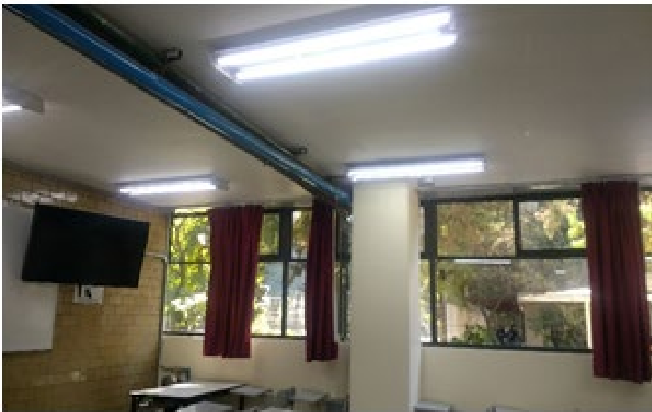
Trabajos en muro y plafones
