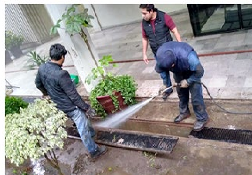
Mantenimiento de rejillas
