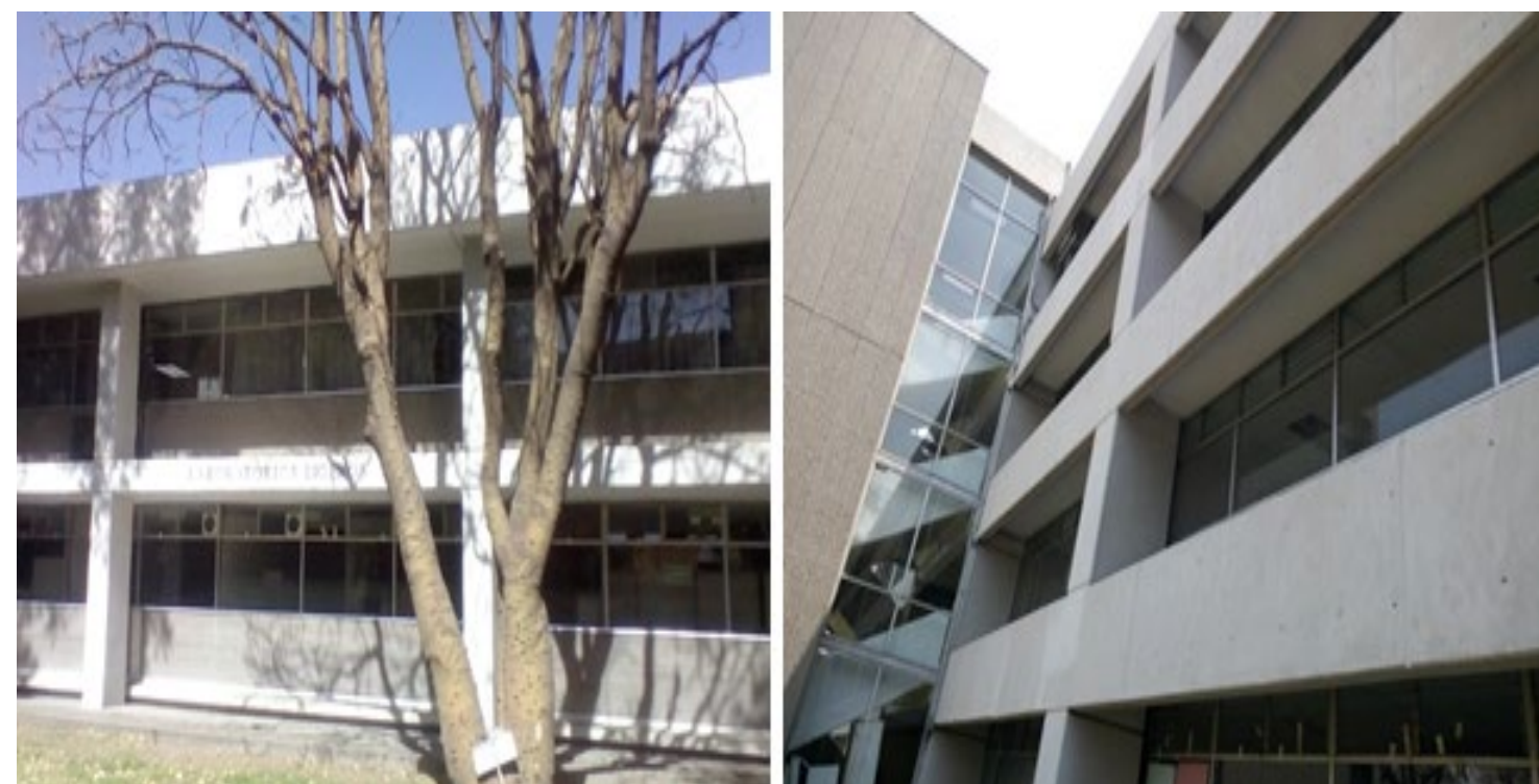
Mantenimiento en fachadas
