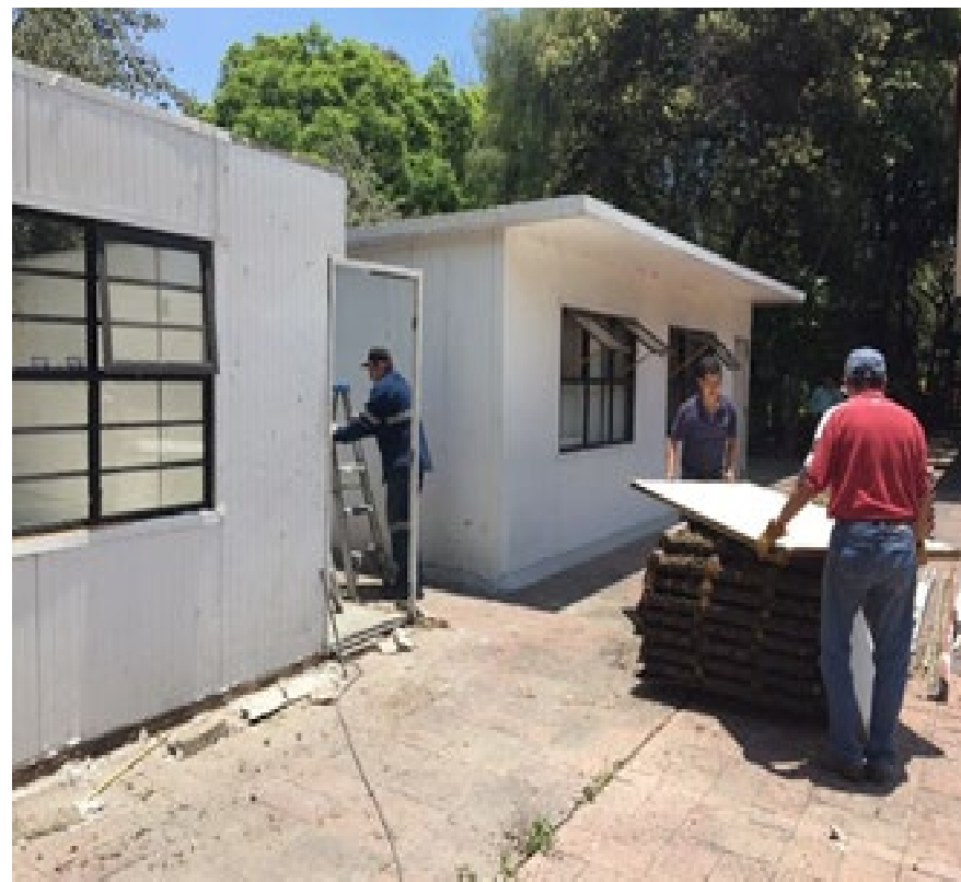
Rehabilitación de espacios exteriores
