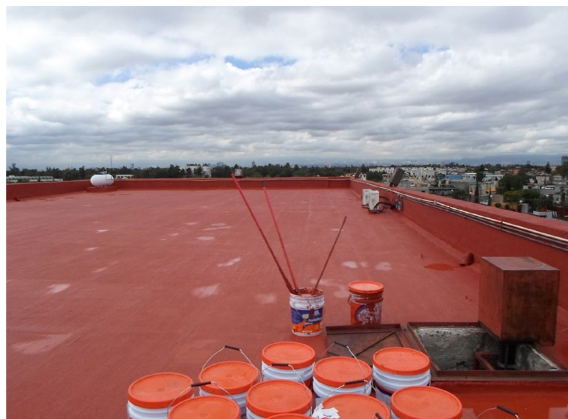
Foto donde se muestra la impermeabilización en las instalaciones del CIEMAD
