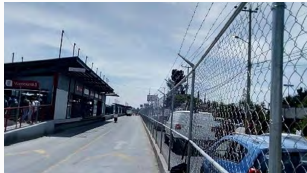
Malla perimetral carril confinado del MEXIBÚS
