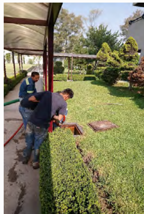
Mantenimiento en los registros en el edificio "M"
