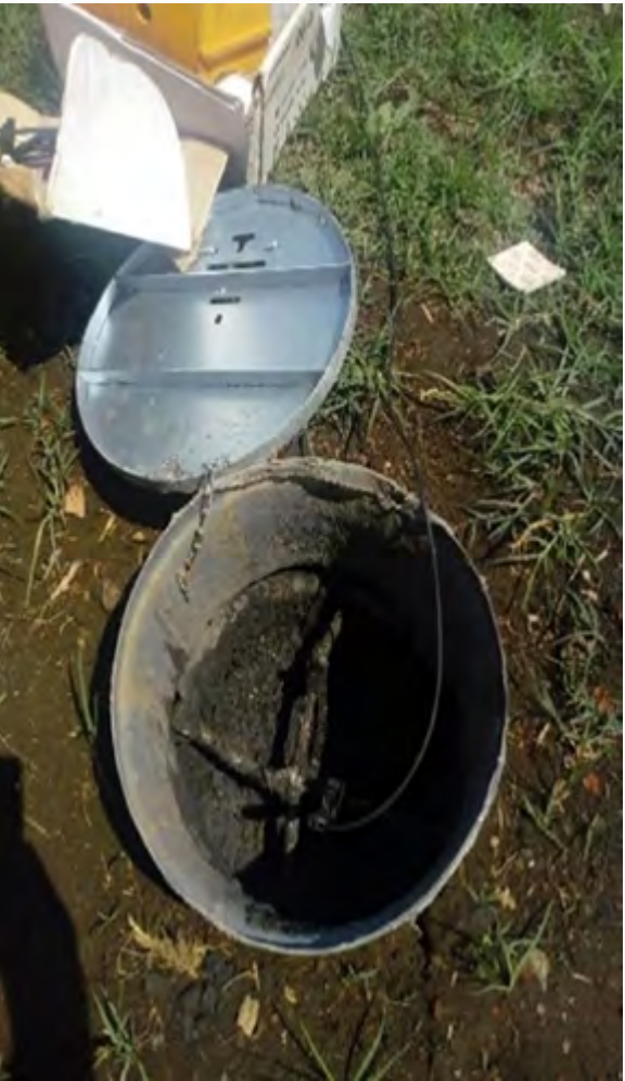
Instalación de Sistema de Tierras Físicas
