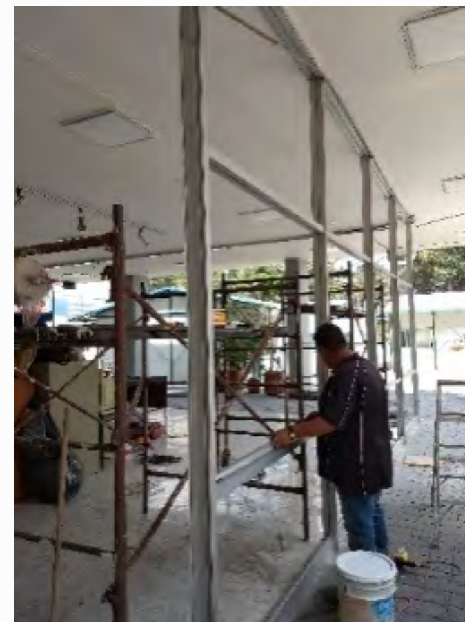
Cambio de cancelería y colocación de vidrio en edificio de Gobierno
