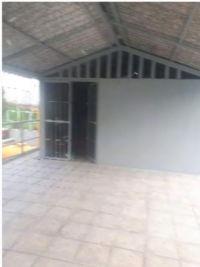
Bodega fabricada para material de actividades deportivas
