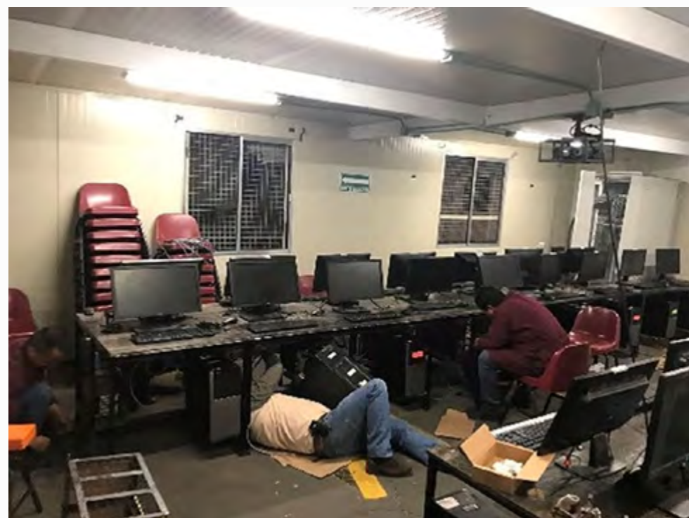
Instalación de Cableado de Red en Aulas de Cómputo
