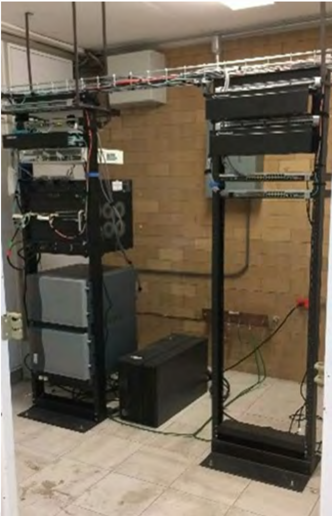
Colocación de Equipos en Nuevo MDF
