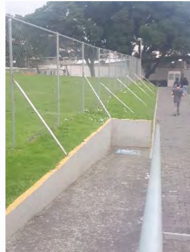
Malla reforzada con tirantes de tubo
