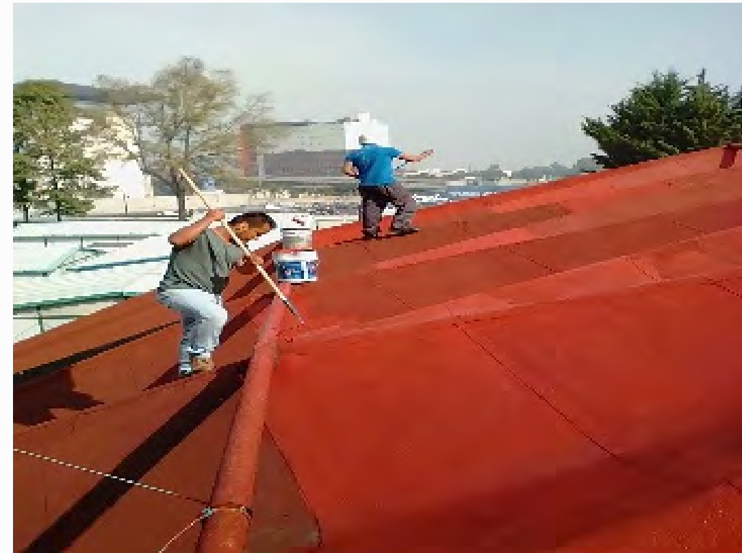
Impermeabilización de domo de cafetería y techo de Sala de Maestros
