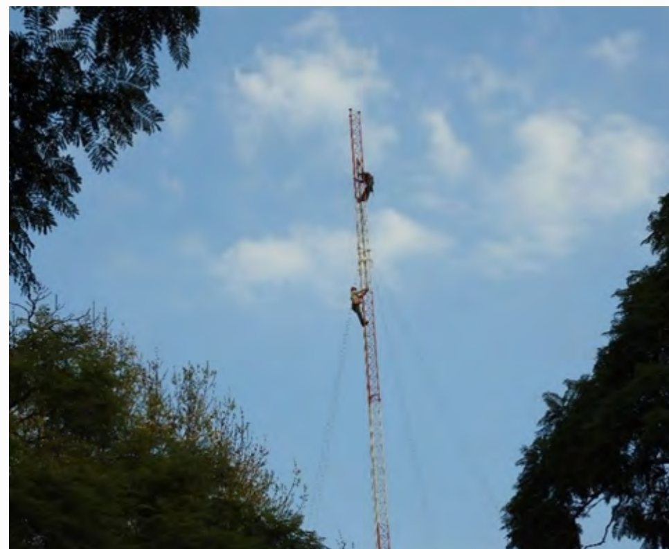
Retiro de la Torre de Microonda
