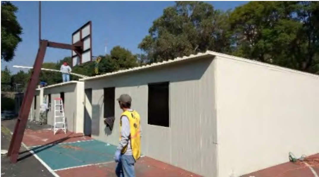
Instalación de aulas provisionales
