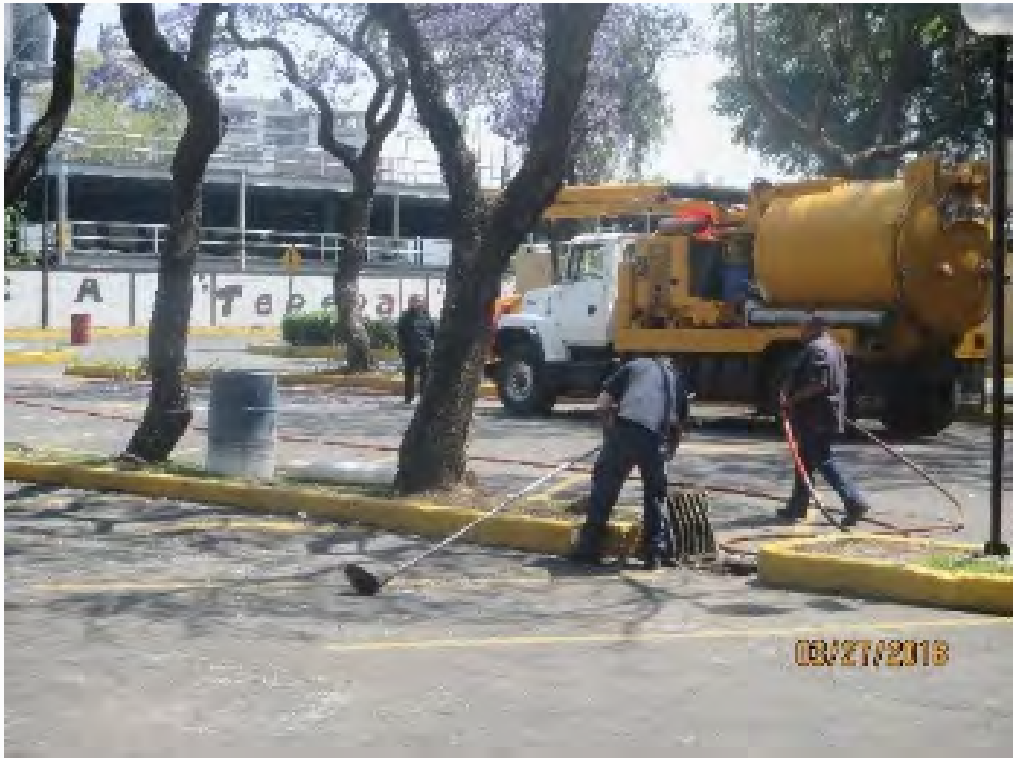
Desazolve de líneas de drenaje
