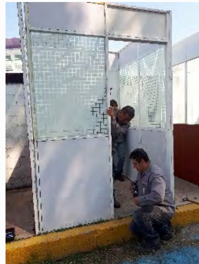
Instalación de casetas para servicio de contención psicológica
