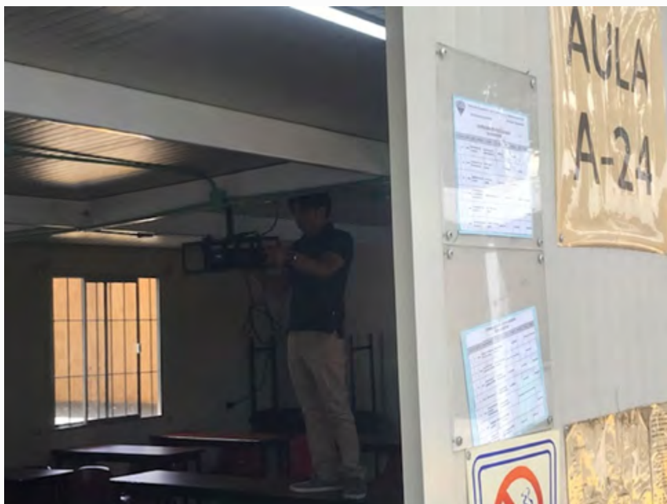
Colocación de vídeo proyectores
