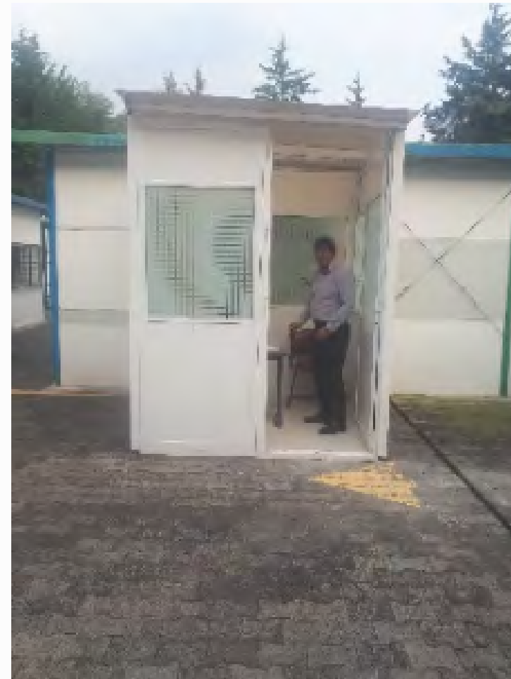
Casetas instaladas para el Departamento de Prefectura
