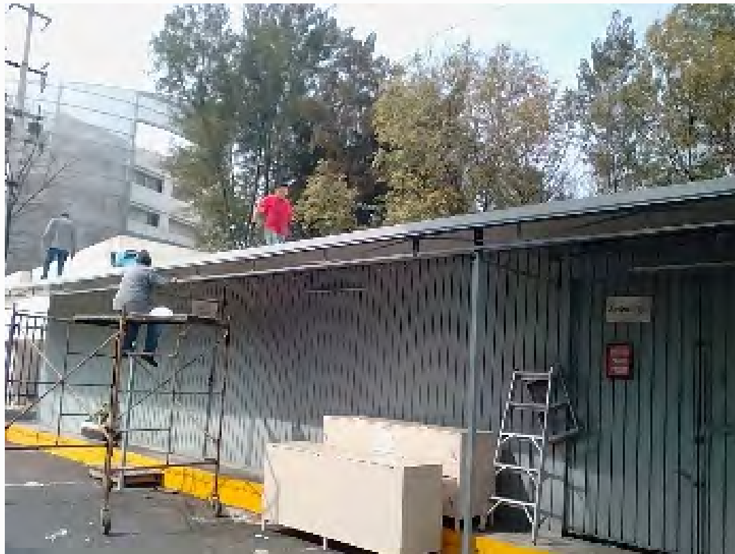
Colocación de multipanel en techo de archivo en trámite
