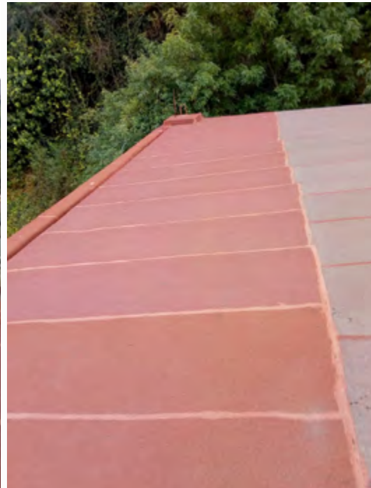
Se realizaron trabajos de impermeabilización en edificios
