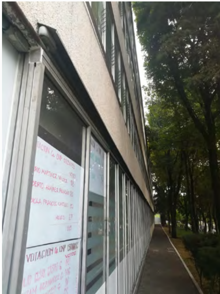
Se realizó sellado de cancelería en fachadas
