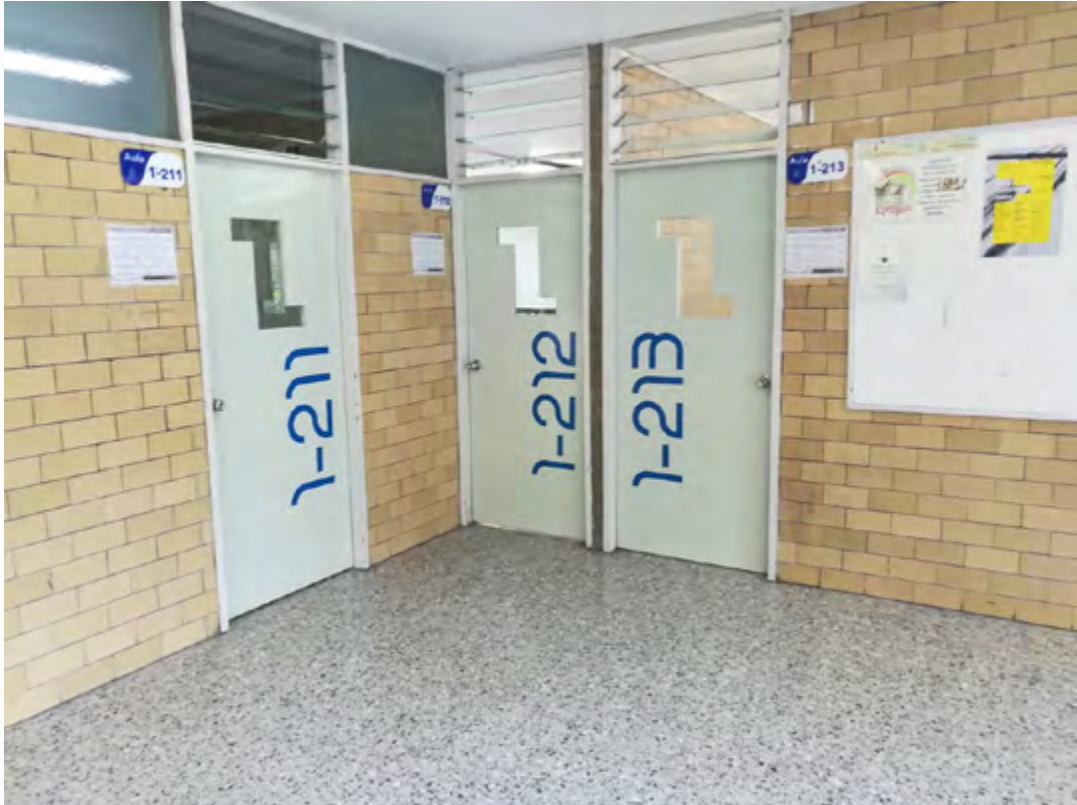
Mantenimiento mayor a puertas de aulas, estado final
