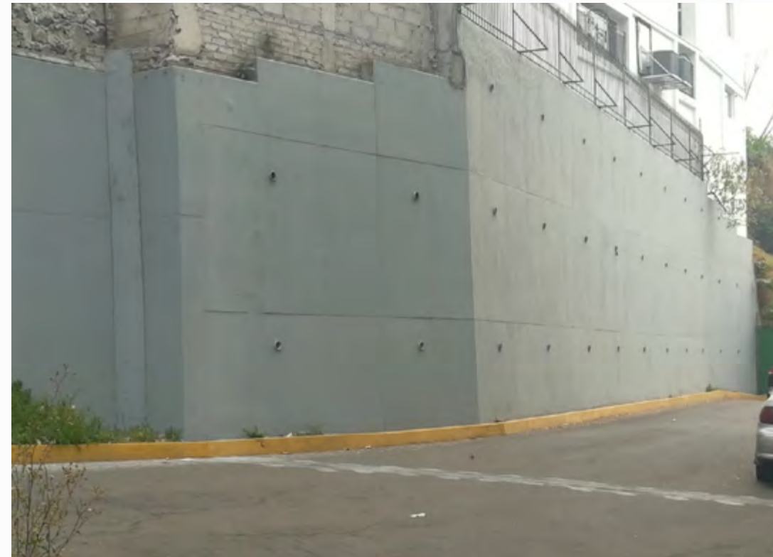
Raspado, reparación de superficie y pintado de muro perimetral
