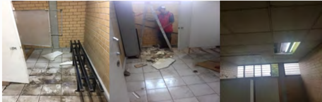
Reparación de retículas de plafón en baños del hangar
