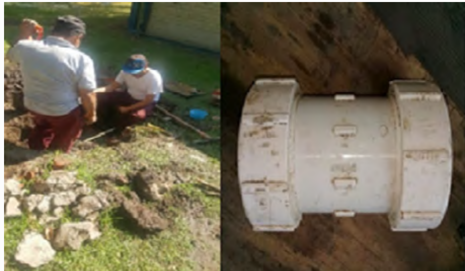
Reparación de fugas en áreas verdes
