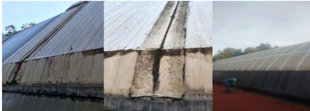
Mantenimiento del domo en la Biblioteca
