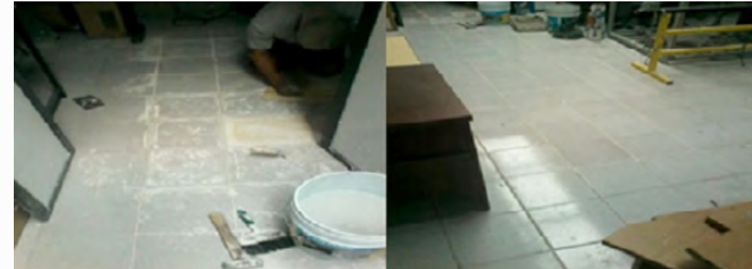
Cambio de loseta en hangar
