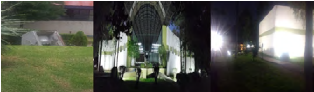
Mantenimiento a 11 cajones de reflectores de la Biblioteca
