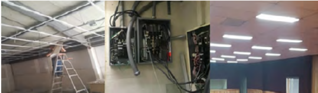
Mantenimiento de instalaciones eléctricas en Sala de Titulación
