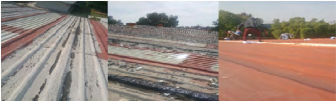
Mantenimiento en techo de multipanel en Laboratorios Pesados
