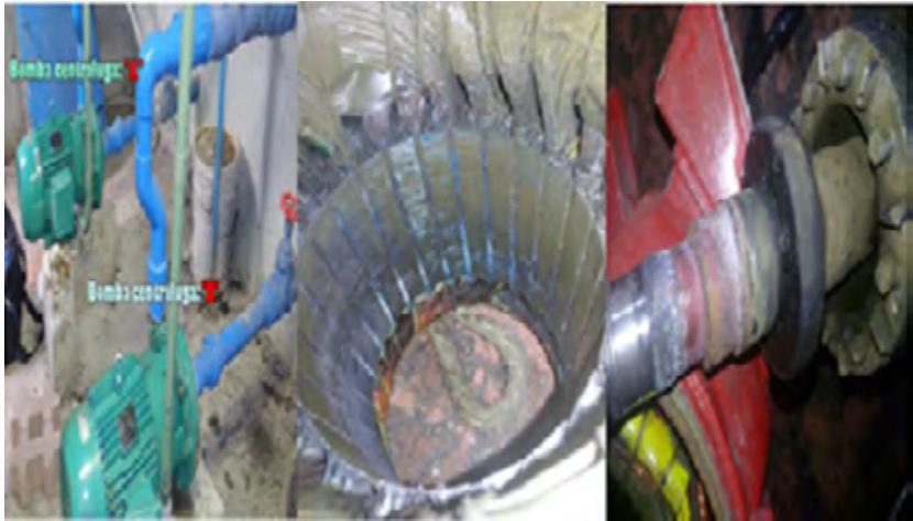
Mantenimiento preventivo a sistema hidroneumático
