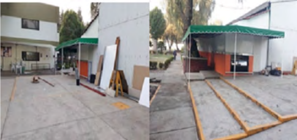
Limpieza y Remodelación de Cafetería
