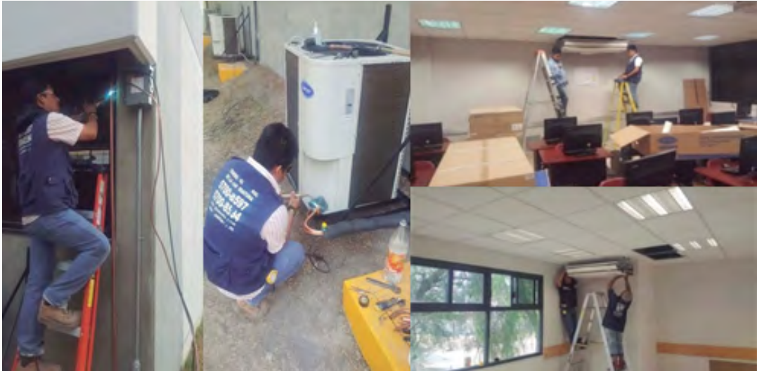
Instalación de Aires Acondicionados en los Edificios "E" y "D"
