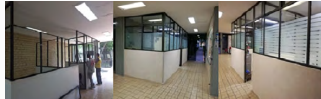
Construcción de tres oficinas para la CEGET
