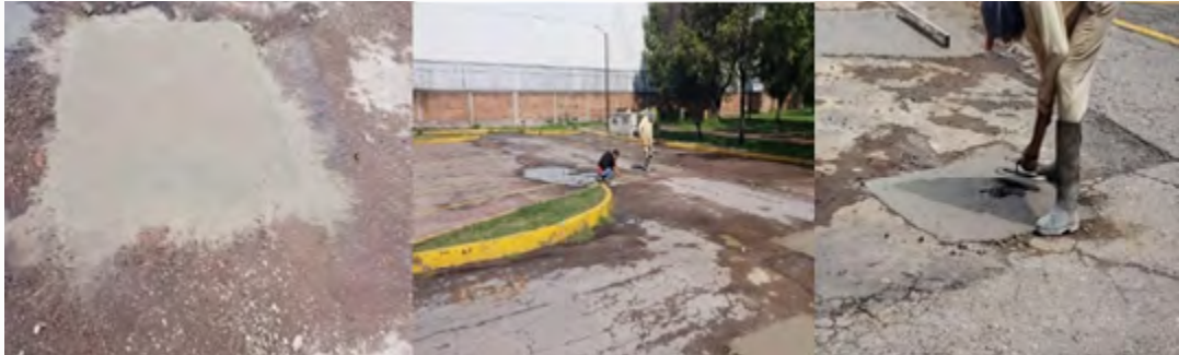
Bacheo de carpeta asfáltica del estacionamiento
