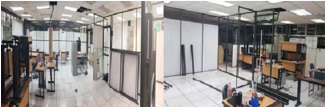
Mantenimiento a cancelería y puertas de aluminio
