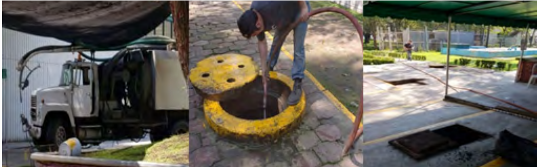
Desazolve del sistema pluvial y de aguas negras
