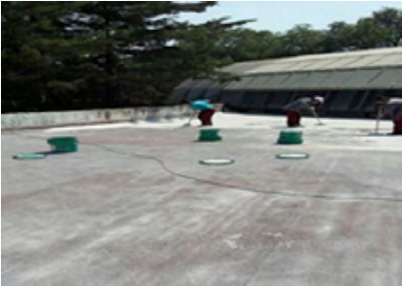
Impermeabilización de azotea de Biblioteca
