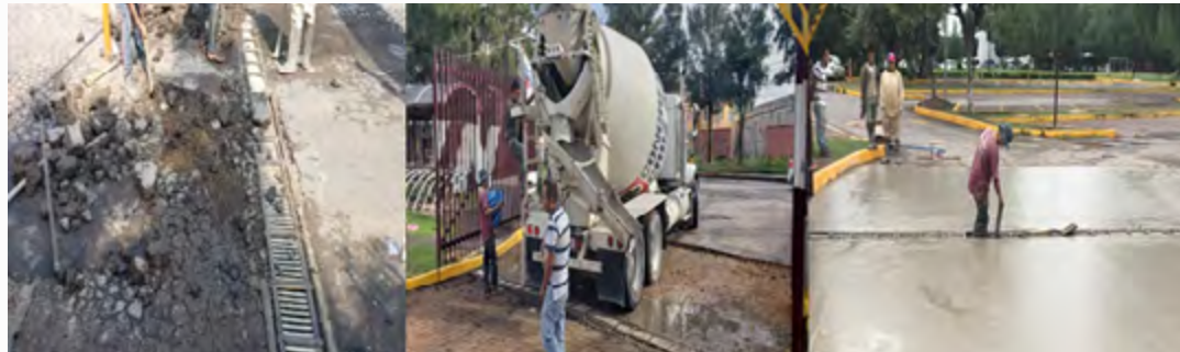
Reparación de pavimento en acceso vehicular
