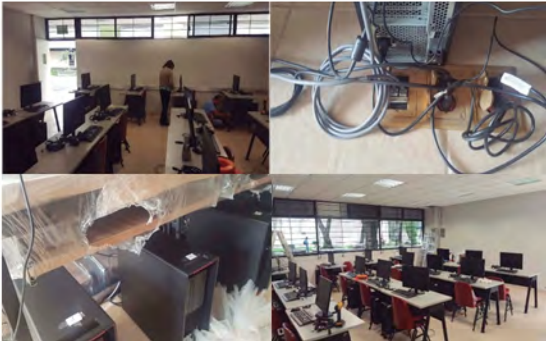
Instalación de cinco laboratorios de cómputo
