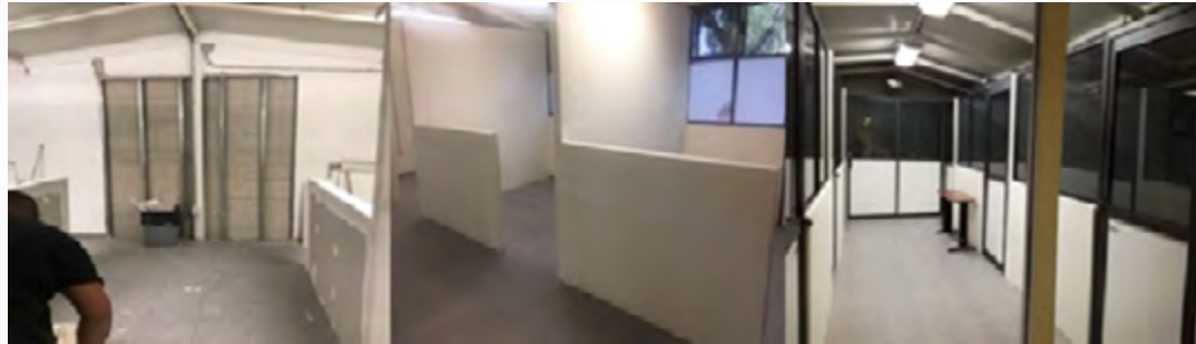
Construcción de siete cubículos para profesores en el edificio G1
