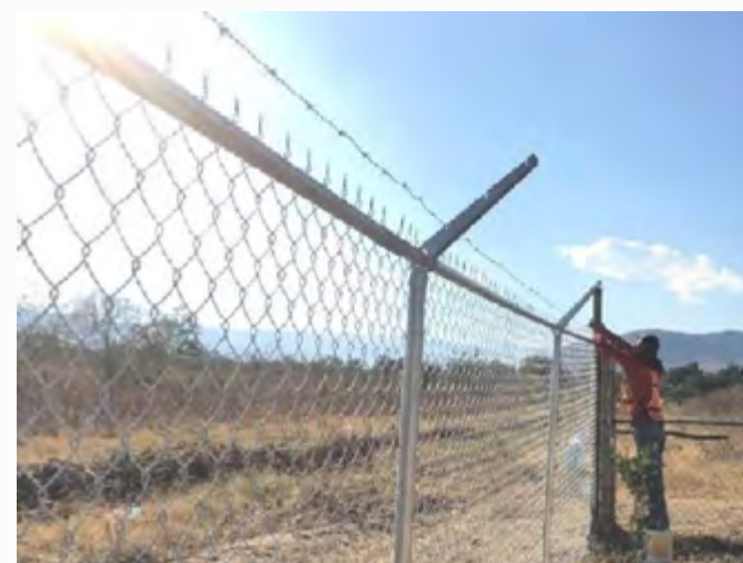
Tensado de malla y mantenimiento a los tubos de soporte
