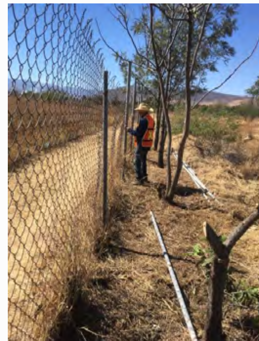
Mantenimiento a la malla perimetral del lado sur-suroeste
