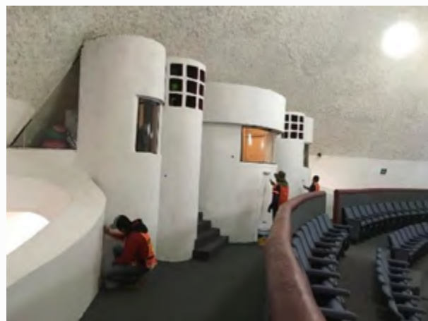
Aplicación de pintura al interior del Aula Magna
