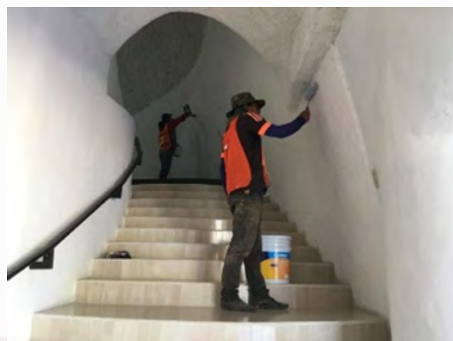
Aplicación de pintura al Aula Magna
