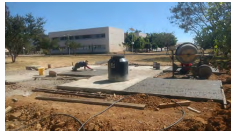
Etapas inicial de construcción
