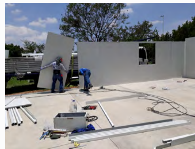
Construcción del aula de usos múltiples con material prefabricado
