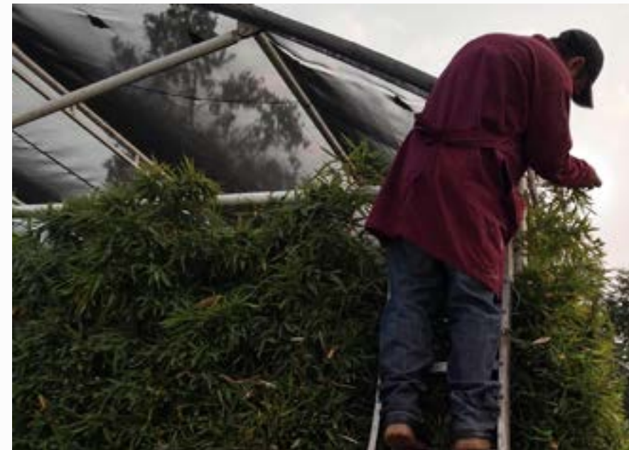
Mantenimiento al auditorio al aire libre "Casa del Agua"
