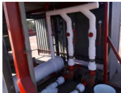
Mantenimiento a equipos de aire acondicionado
