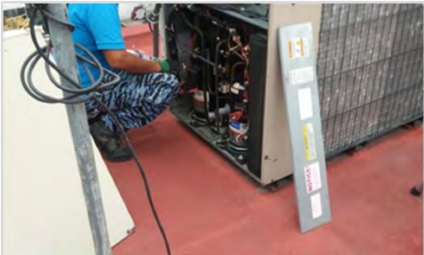
Mantenimiento preventivo aire acondicionado del XE-IPN-TV Canal Once
