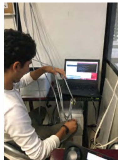
Instalación y configuración de equipo switch en Aula de la ESIA Zacatenco
