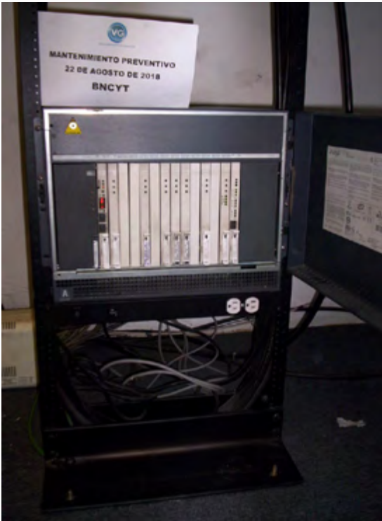
Mantenimiento preventivo al conmutador de la Biblioteca Nacional de Ciencia y Tecnología
