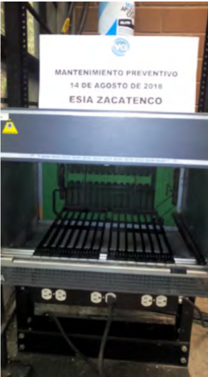
Mantenimiento preventivo al conmutador de la ESIA Unidad Zacatenco
