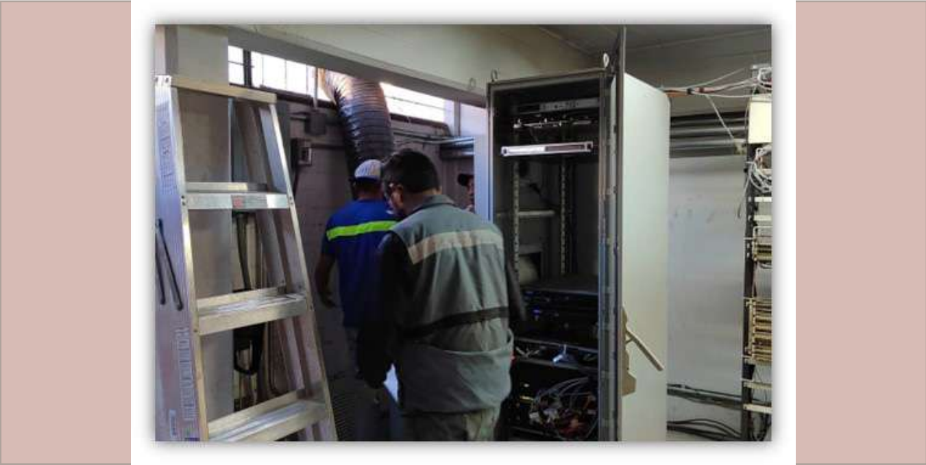
Mantenimiento equipo RITTAL.
