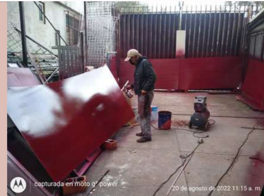
Pintando la lámina para la colocación.
