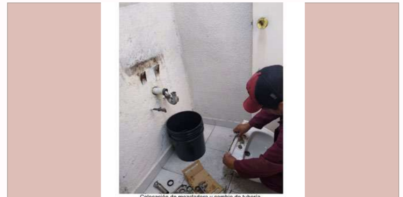
Colocación de mezcladora v cambio de tubería.
