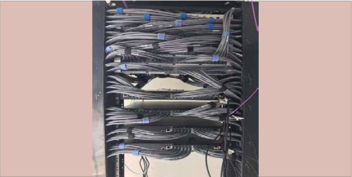
Colocación de cables de red.
