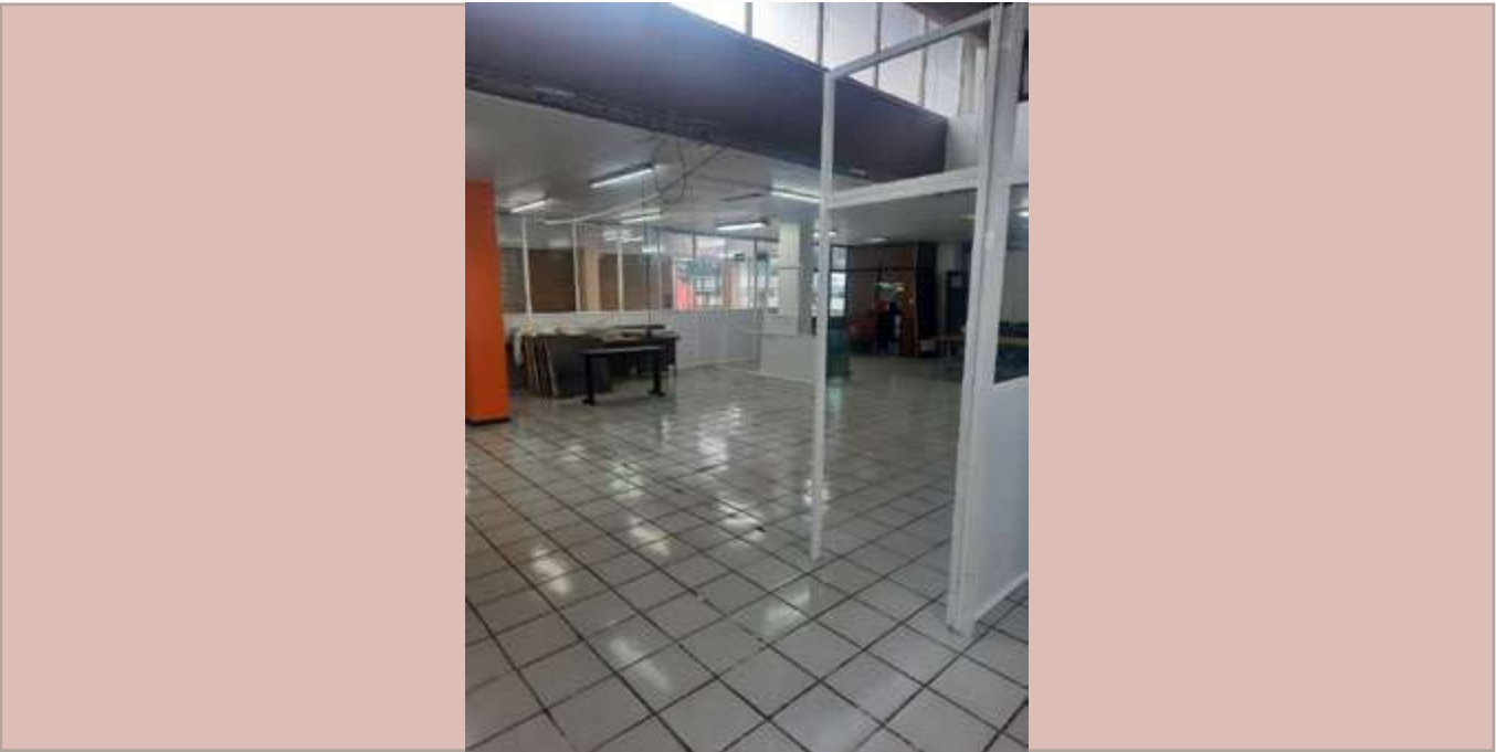
Fabricación y colocación de módulos para confinar sala directiva en área de subdirecciones.
