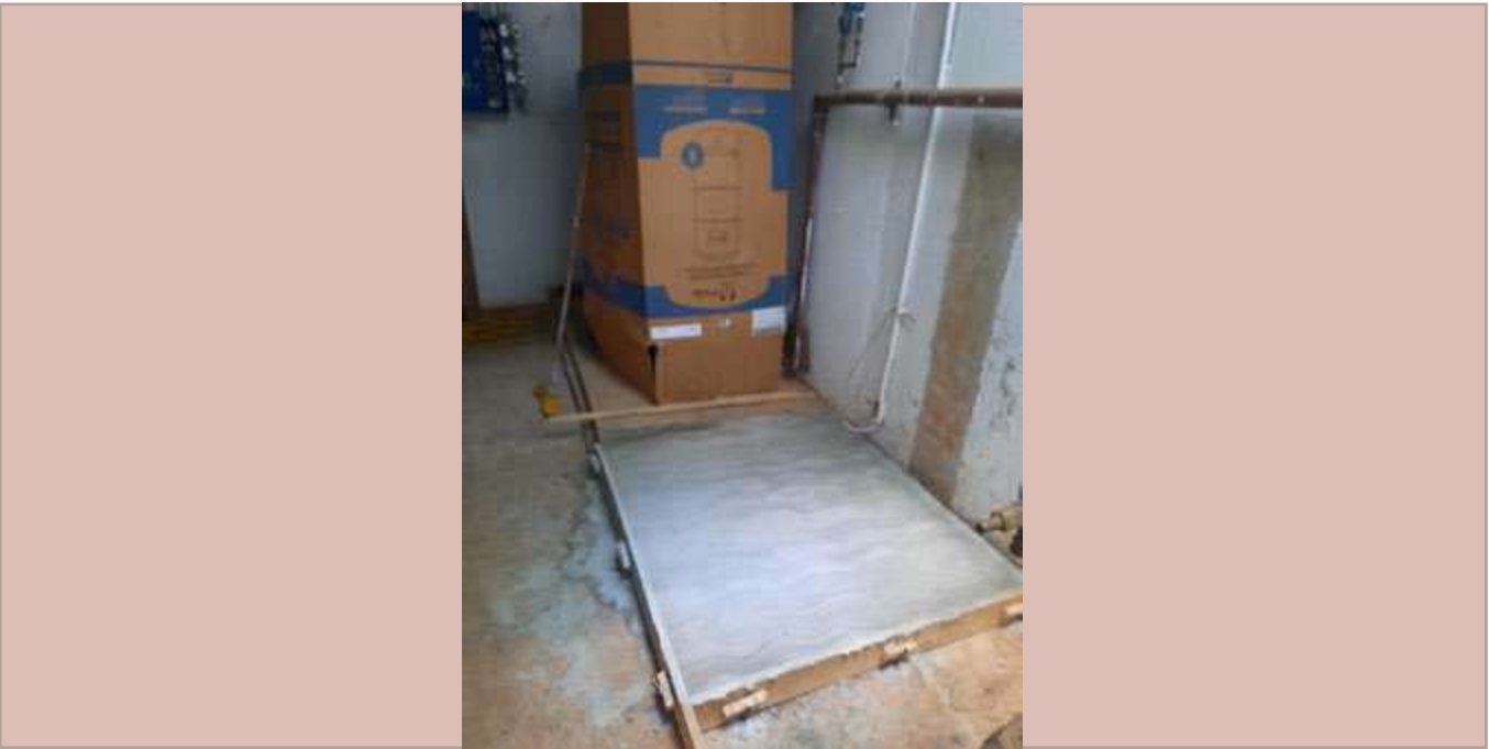
Fabricación de plancha de concreto para la colocación de dos tanques precargados nuevos.
