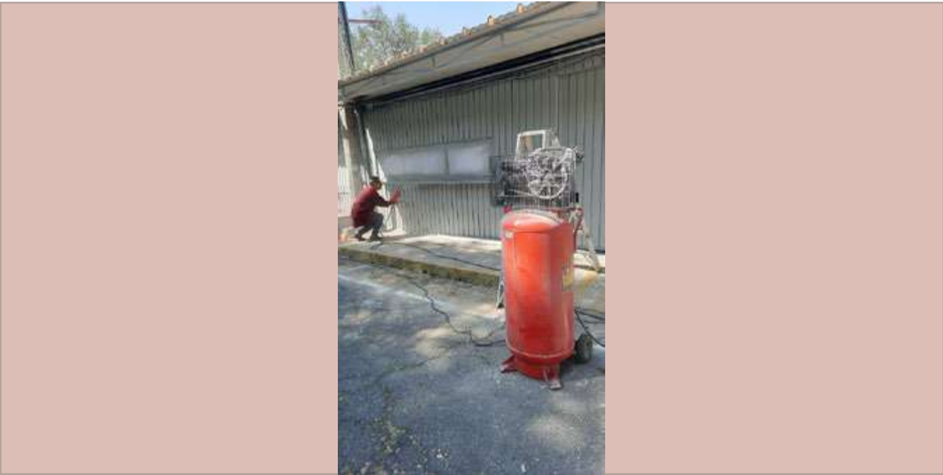
Aplicación de pintura con compresora en fachada de oficinas de CEGET y Recursos Financieros.
