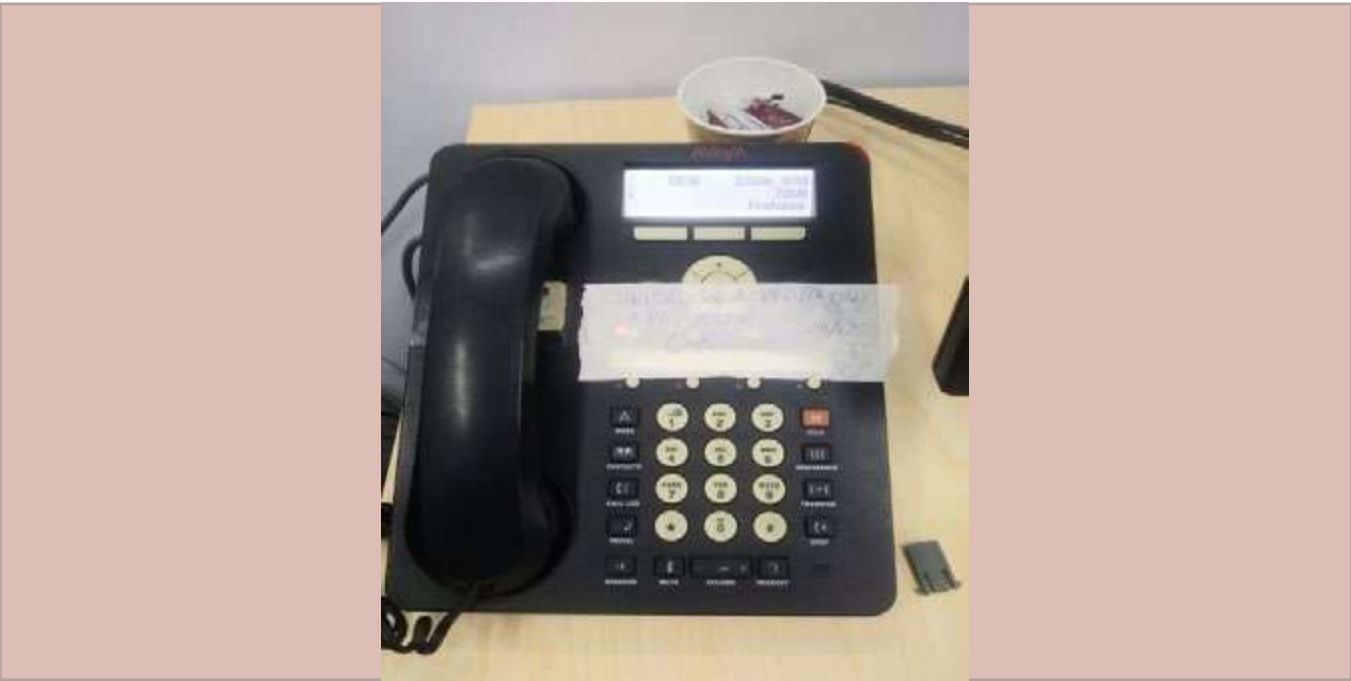
Mantenimiento a equipos telefónicos.
