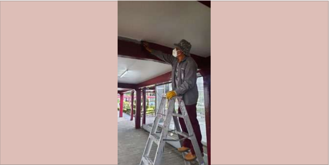
Aplicación de pintura en andadores-1.
