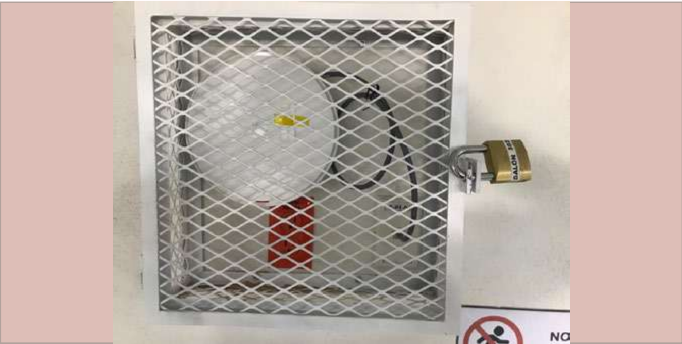
Instalación de jaulas de seguridad para equipos de red.
