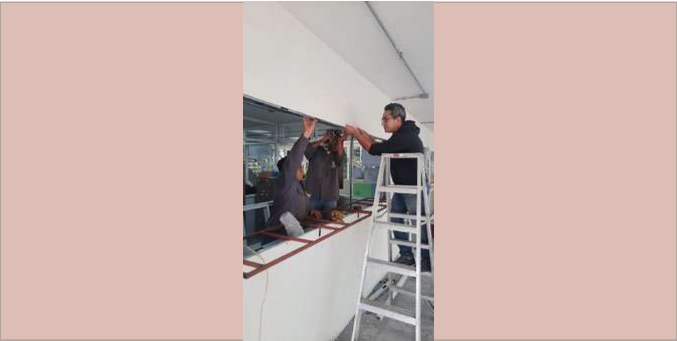
Fabricación e instalación de ventanillas de atención para CELEX-1.
