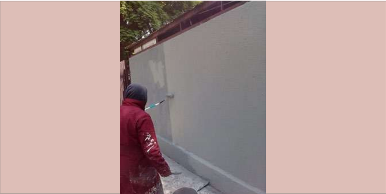
Aplicación de pintura en barda exterior de la zona de actividades deportivas.
