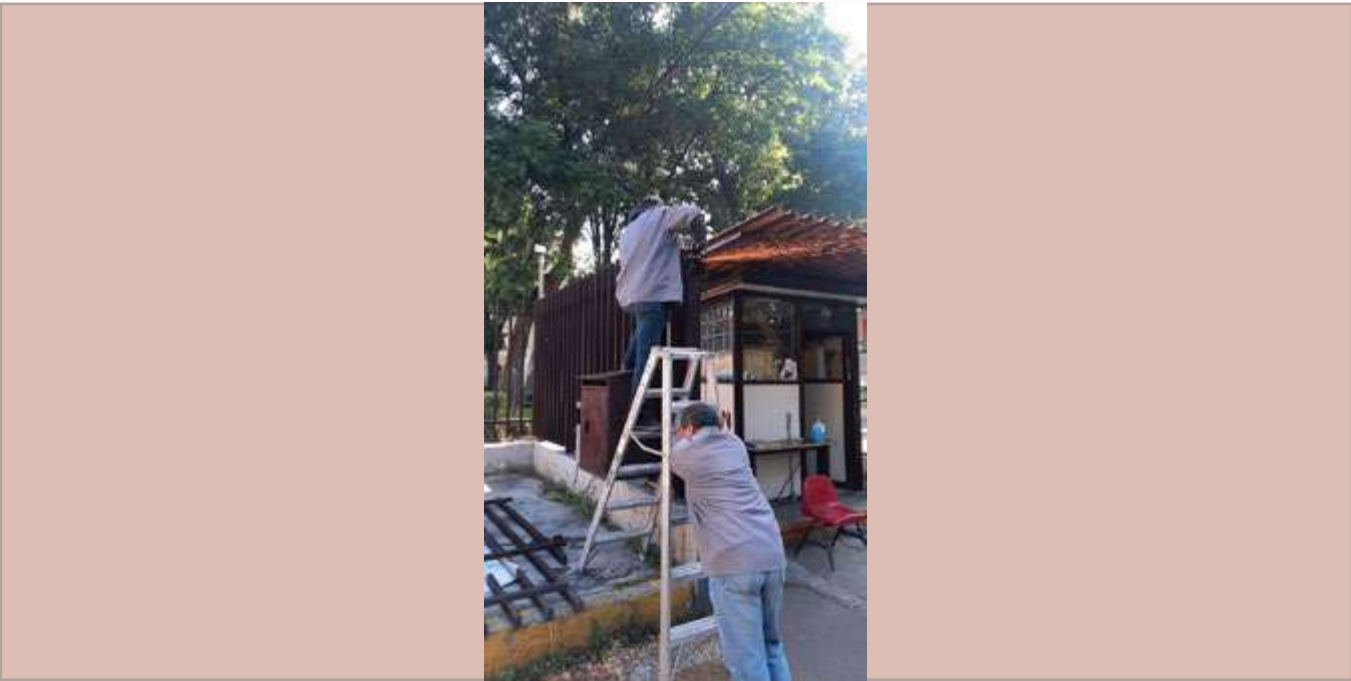
Instalación de tejuelo nuevo en puerta de acceso al estacionamiento de maestros en salubridad.
