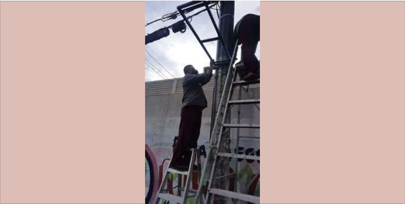
Fabricación y fijado de estructura soporte para torreta de puesto de vigilancia.
