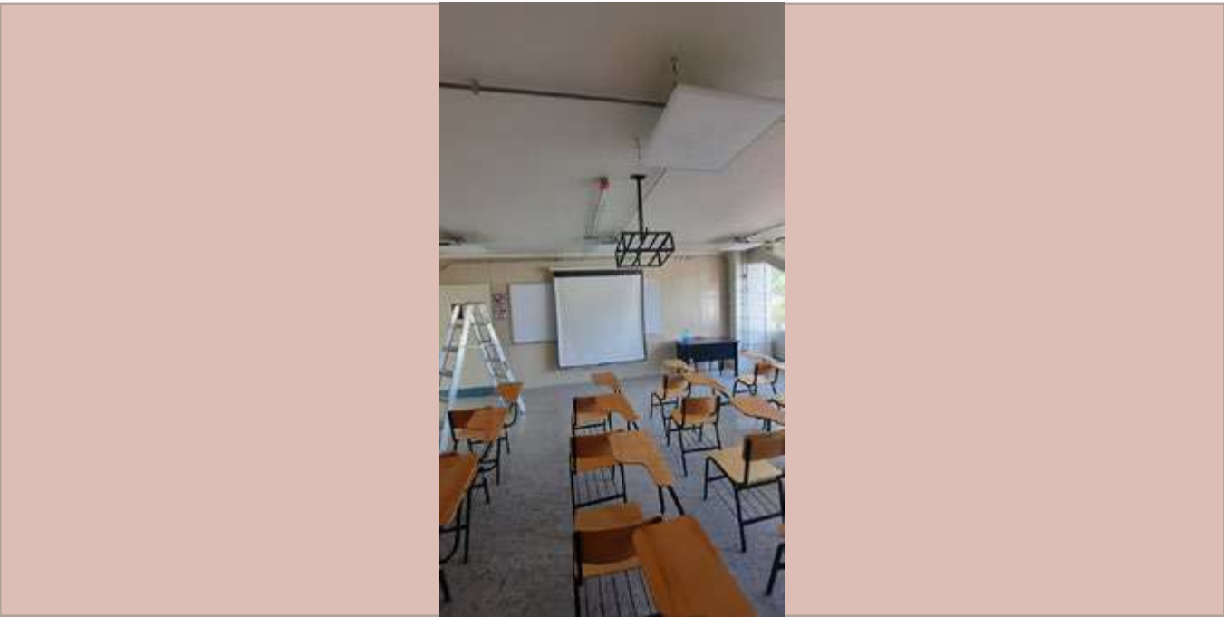
Instalación de pantallas para proyector en aulas de edificio A-1.
