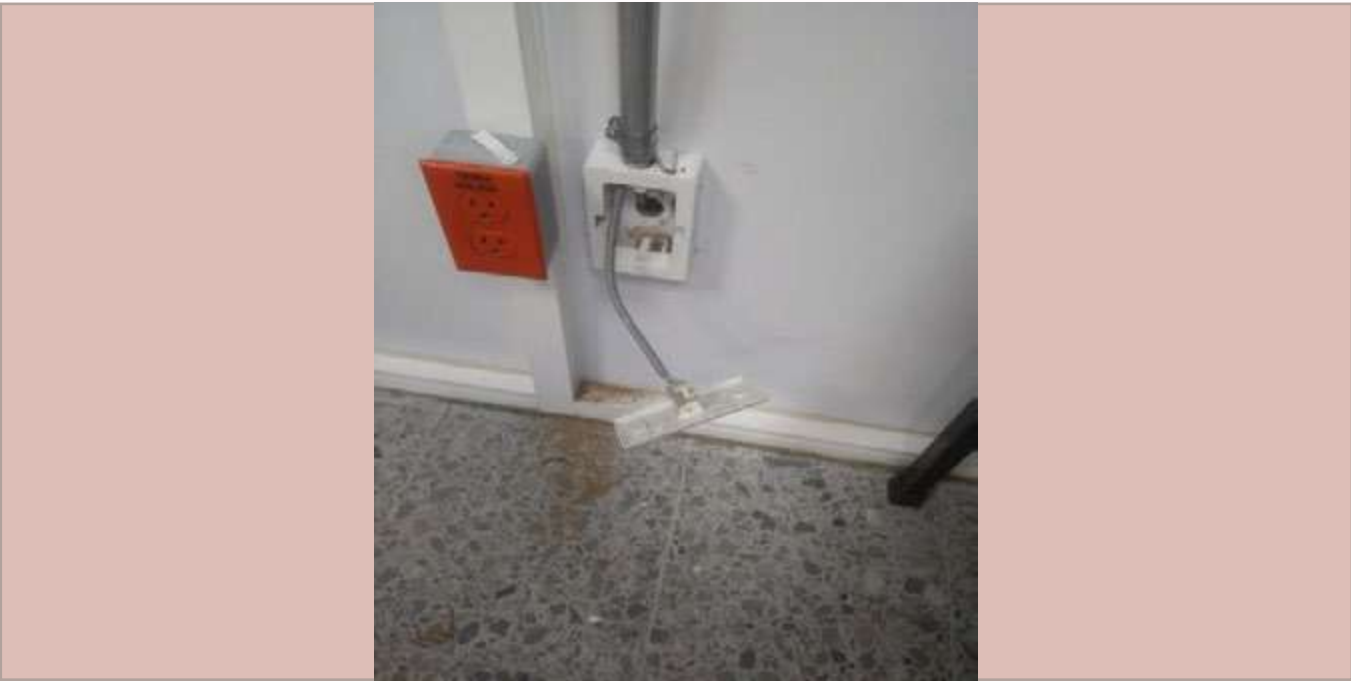
Colocación de Patch Cord.
