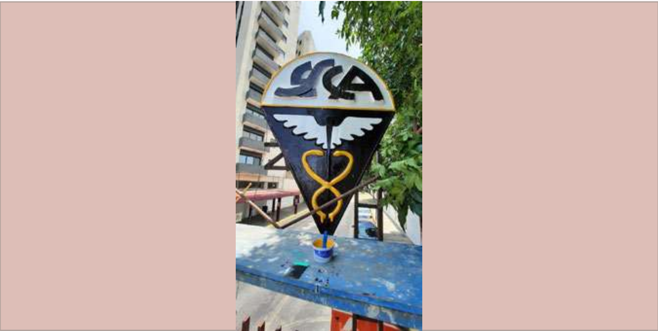
Aplicación de pintura en escudo de la entrada de periférico.
