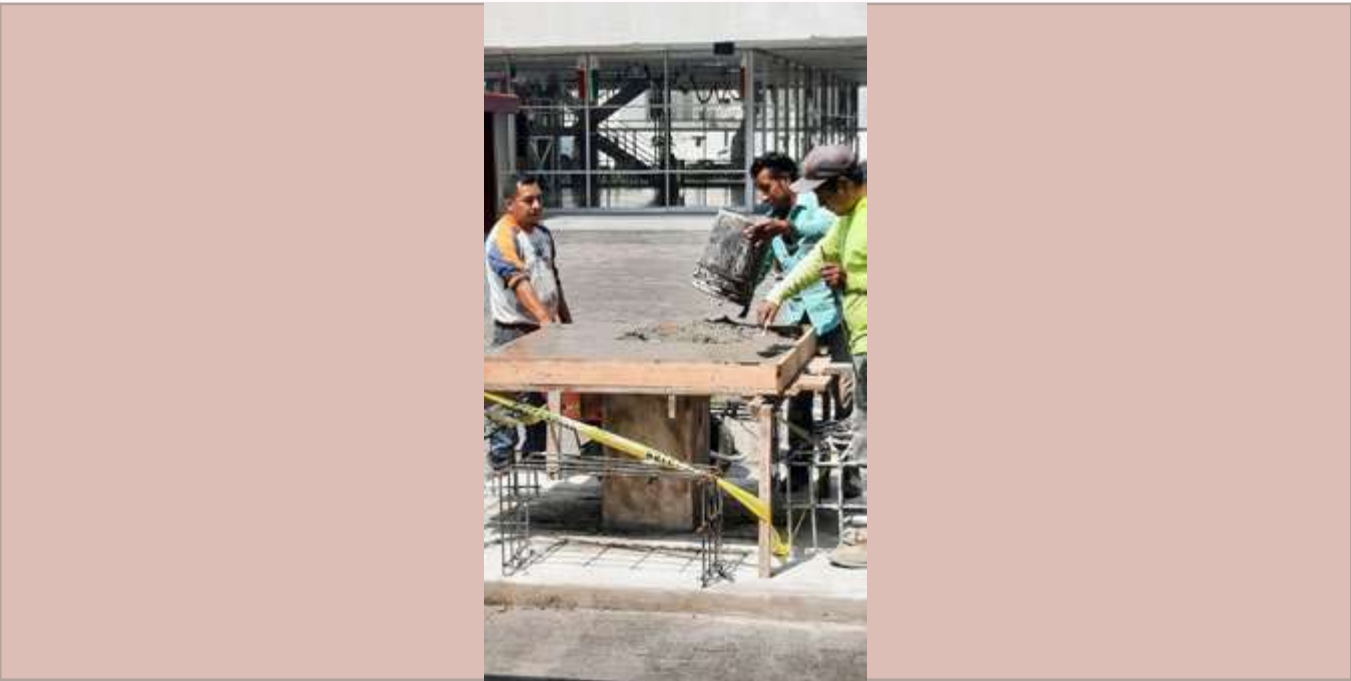
Colado de mesas de concreto con bancas.
