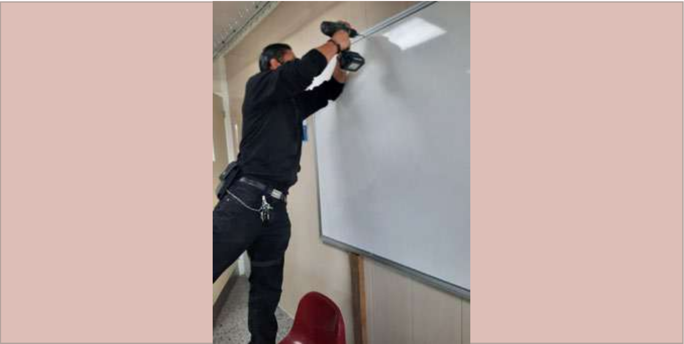
Colocación de pizarrones en aulas.
