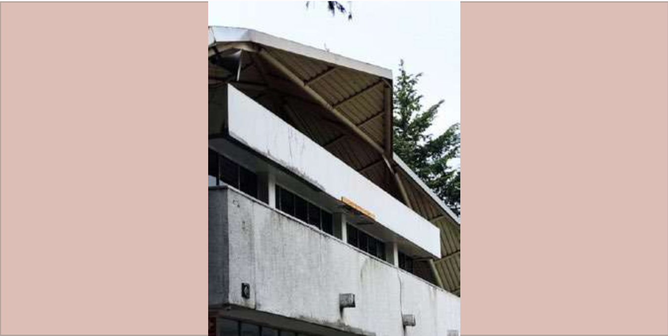
Resane de prefabricado en cafetería con cemento y adhesivo.
