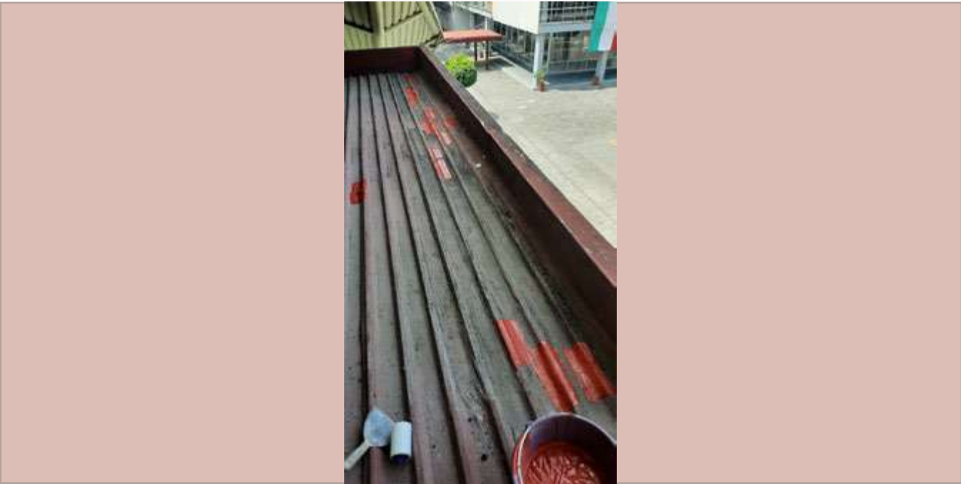
Aplicación de impermeabilizante plástico Impercoat.
