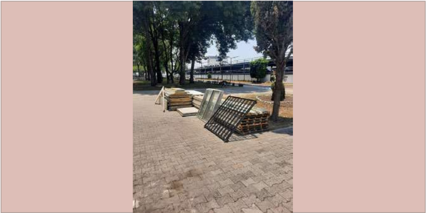
Desmontaje y traslado de aula prefabricada de área de canchas a cabecera de edificio C.
