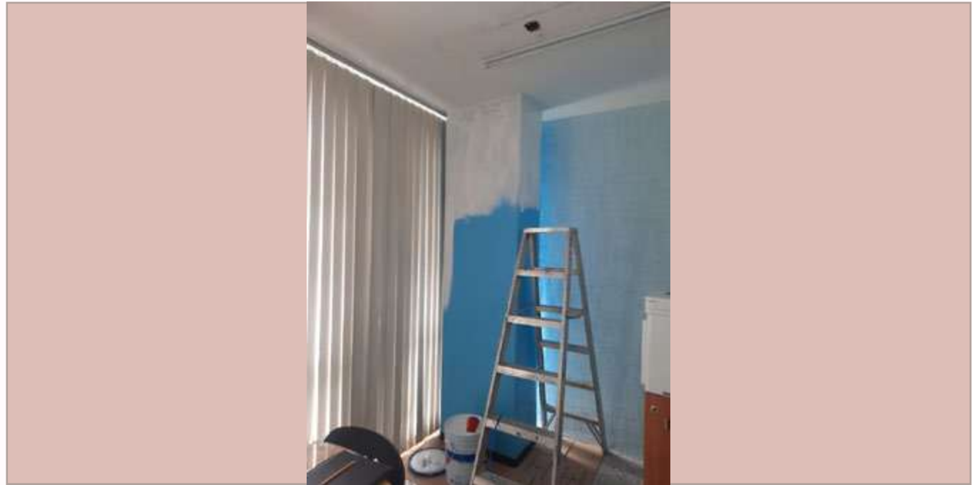
Aplicación de pintura en columnas de oficinas de subdirecciones.
