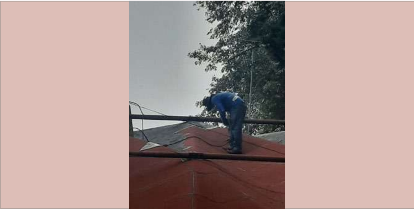
Retiro de impermeabilizante prefabricado dañado en cafetería.
