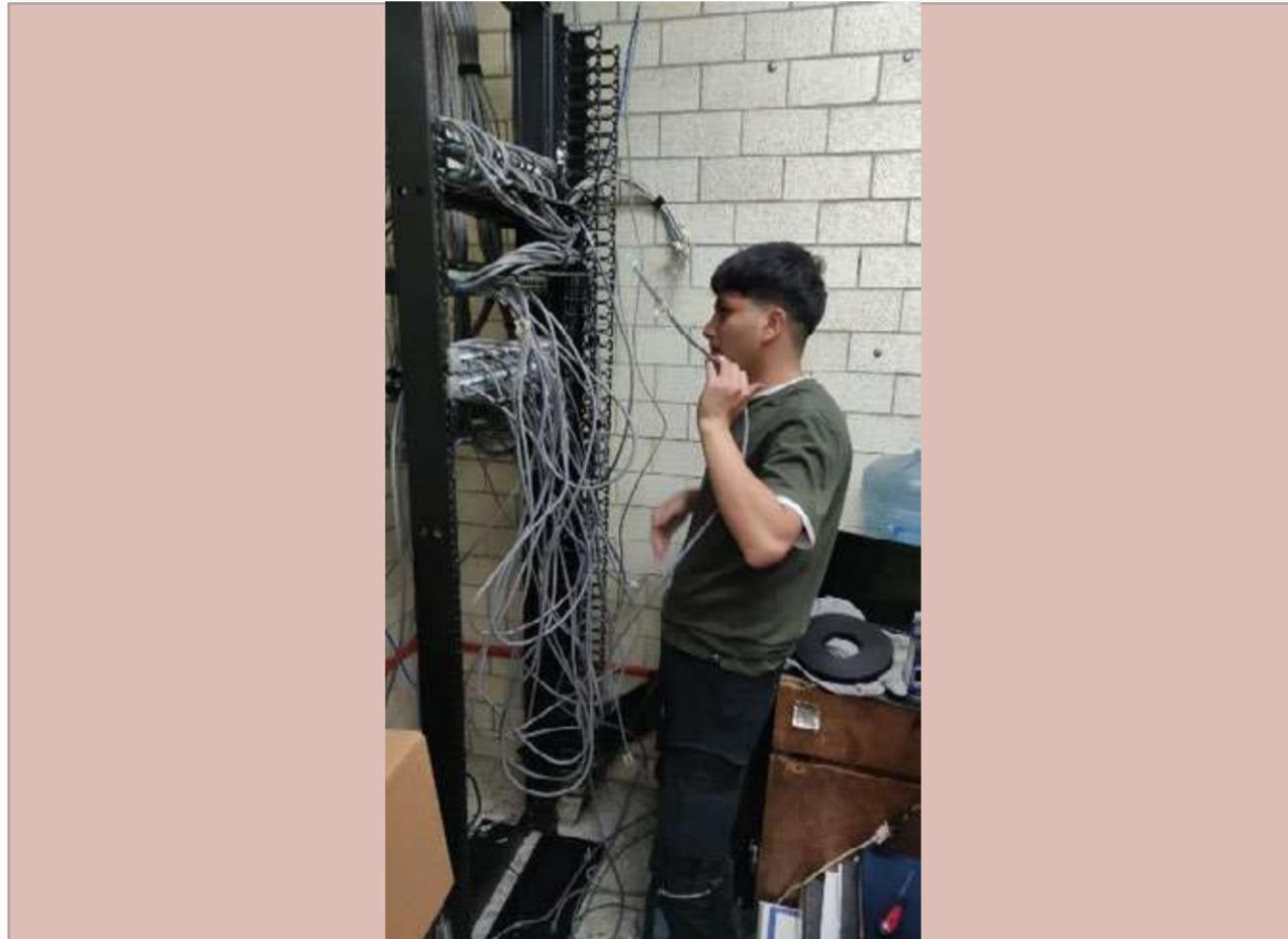
Instalación de un rack para montar switches: sala Makerspace.
