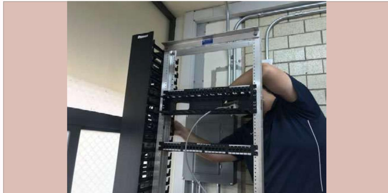
Instalación de un rack para montar switches: sala Realidad Virtual.
