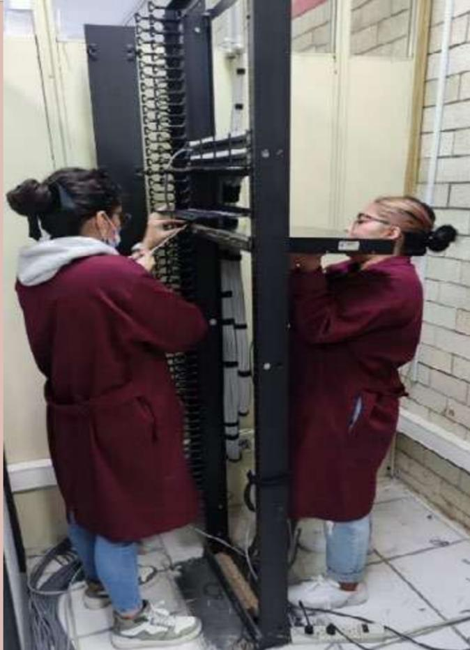
Instalación de un rack para montar switches: sala SIMA Posgrado.
