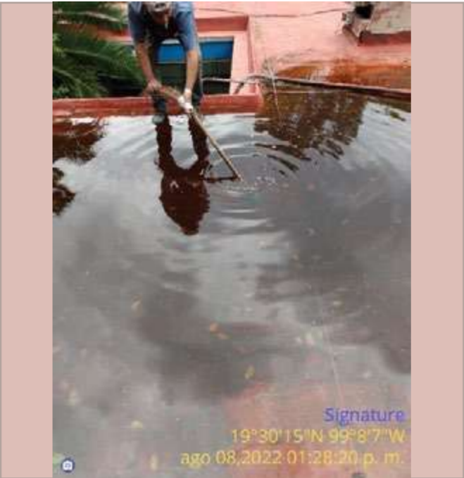
Desasolve de bajadas pluviales.
