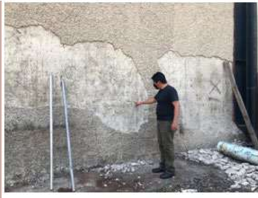
Retiro de aplanado y corte para recibir armado en muro.
