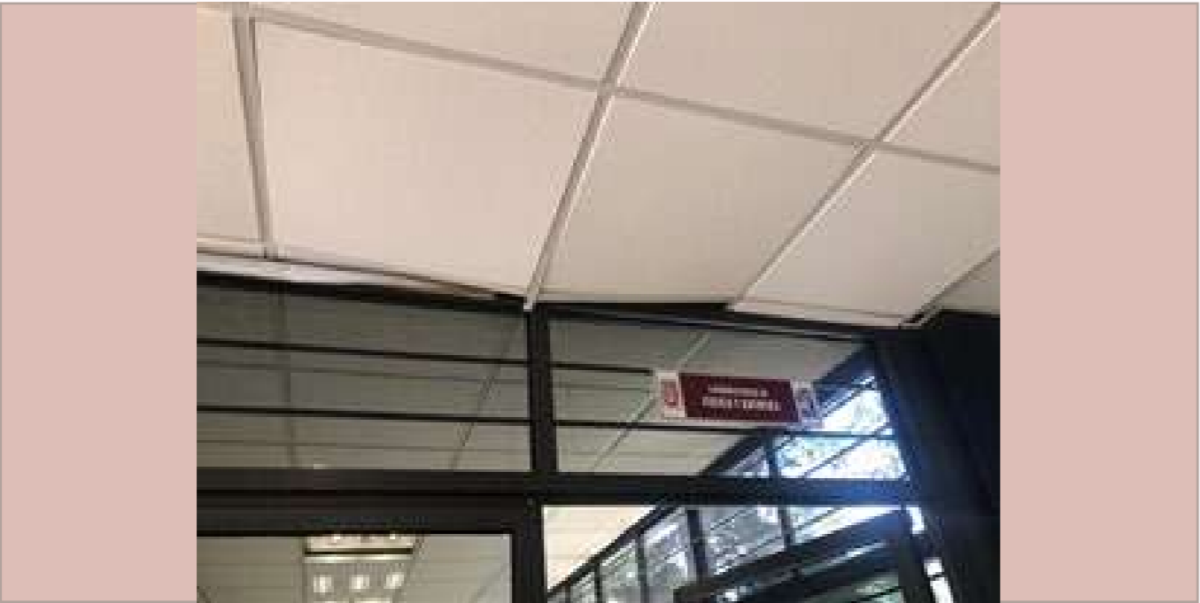
Plafón modular y estructura de aluminio dañada en la puerta de acceso al laboratorio de física.
