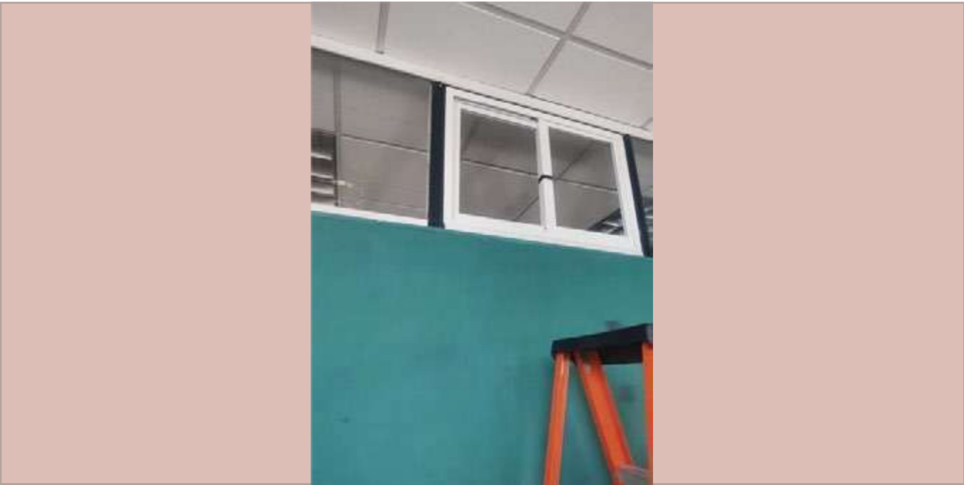
Instalación de ventanas corredizas en Academias.
