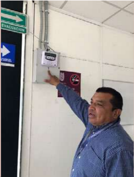
Instalación de equipos de alerta sísmica en Edificios 10, 11 y 12, laboratorio de Puertos y Costas y SEPI.
