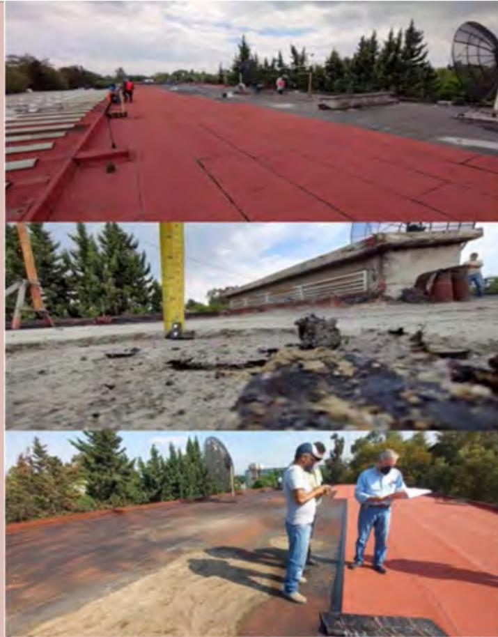
Mantenimiento y conservación de techos para evitar filtraciones.
