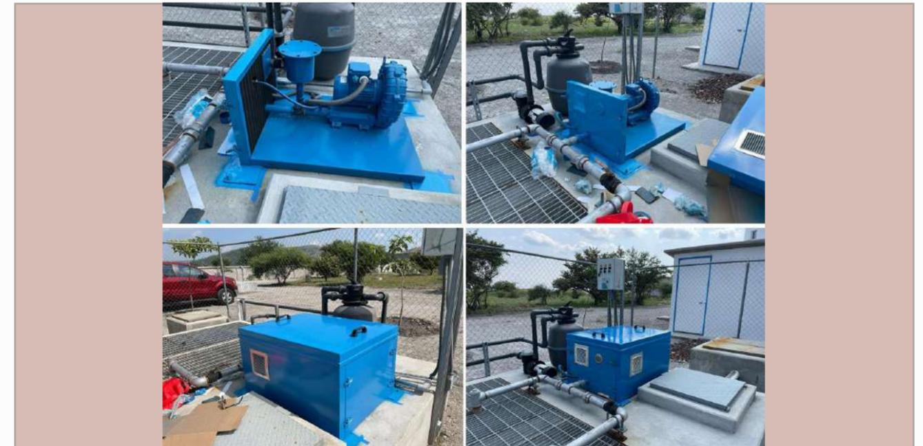
Trabajos de mantenimiento en la planta de tratamiento de aguas, reparación de la cabina acústica y trabajos en la acometida eléctrica.
