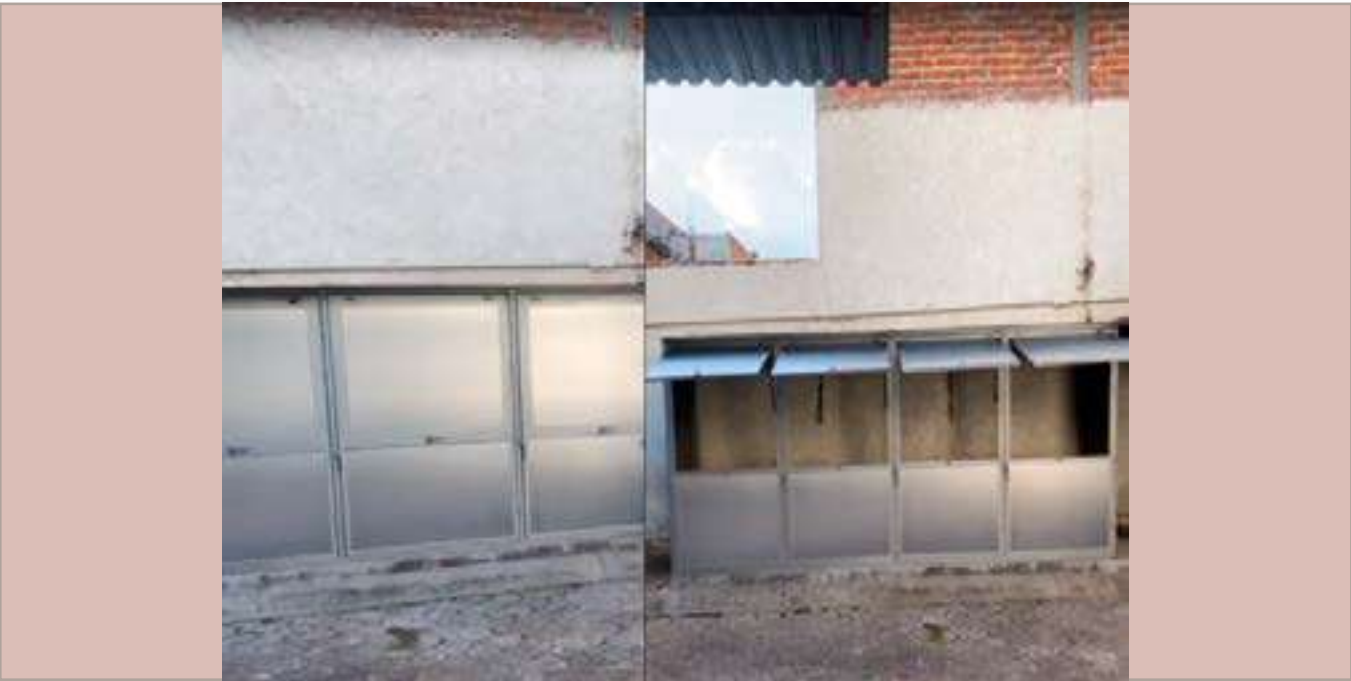
Contenedores para residuos recién construidos.
