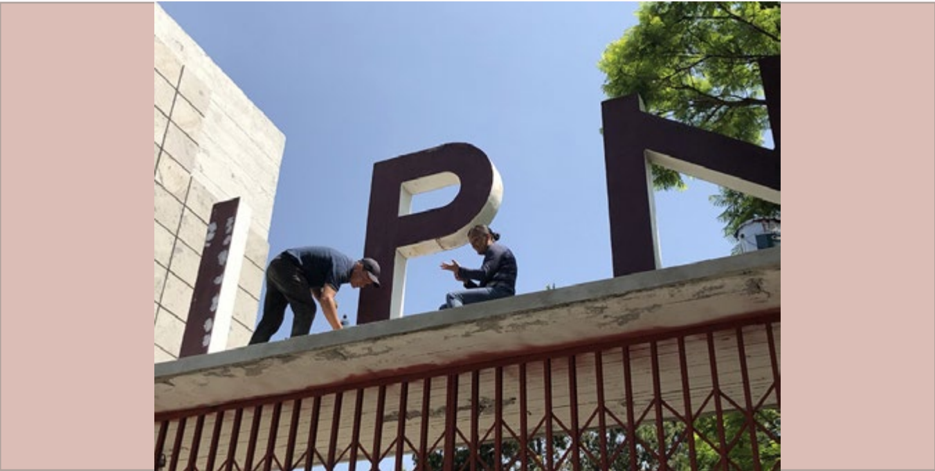
Mantenimiento y reacondicionamiento del Portón del IPN.
