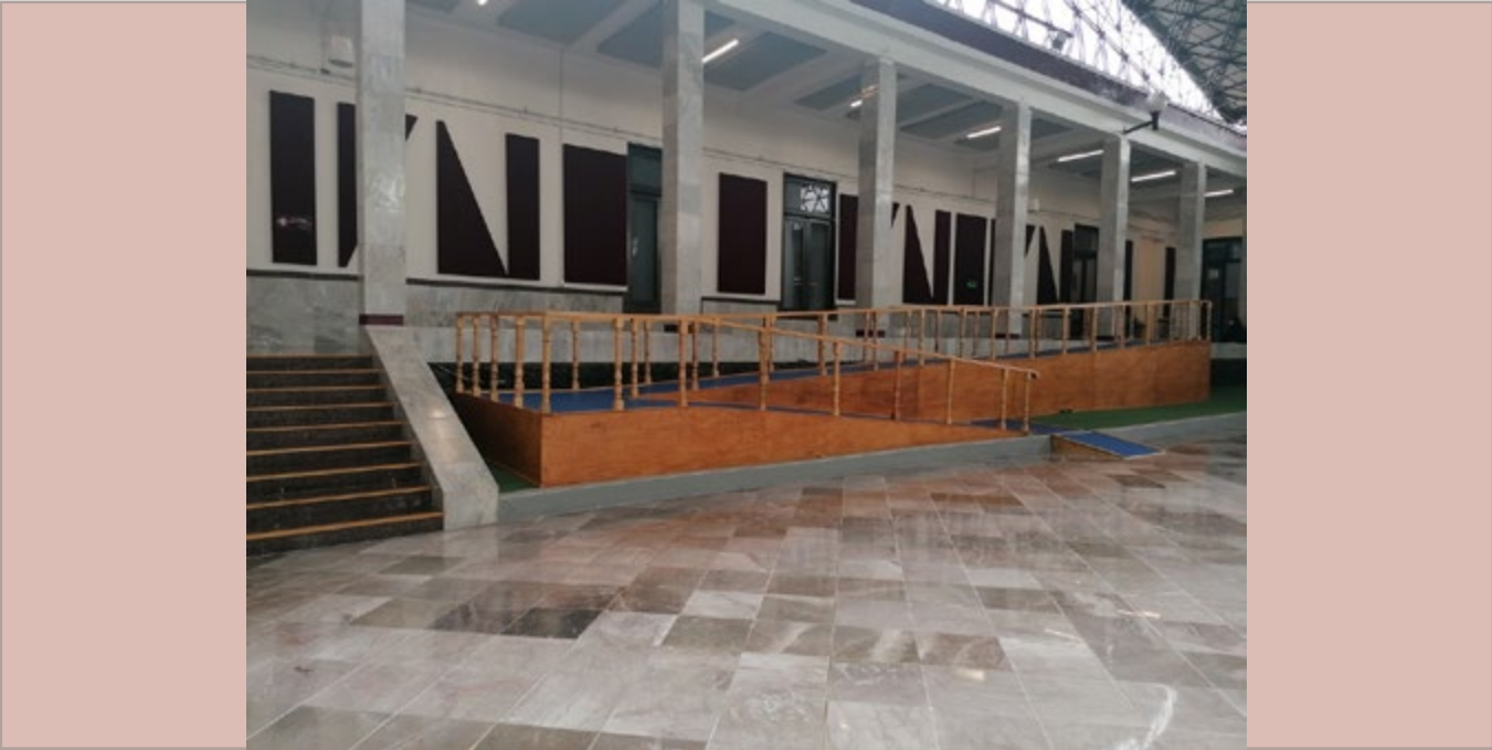
Rampa de acceso al Recinto Histórico y Cultural “Juan de Dios Bátiz”.
