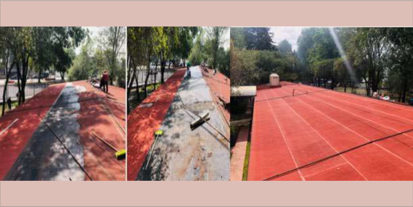
Retiro y aplicación de impermeabilizante.
