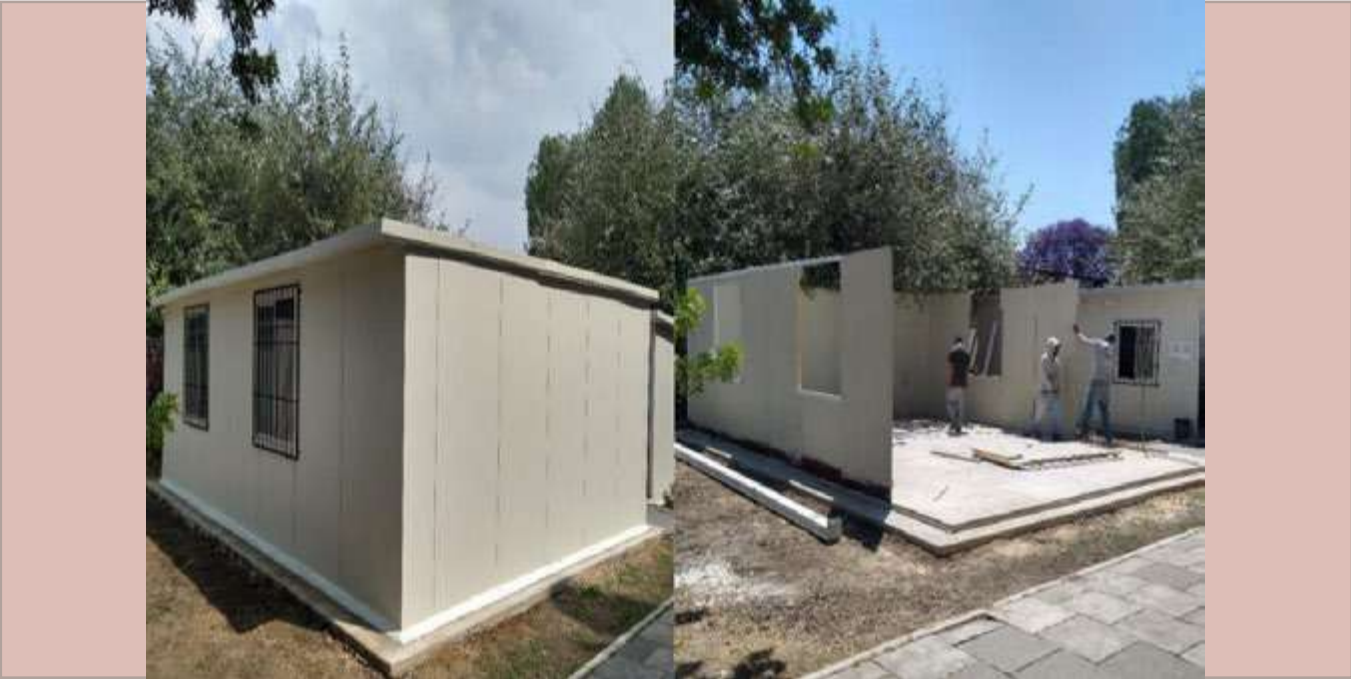
Instalación de casetas prefabricadas.
