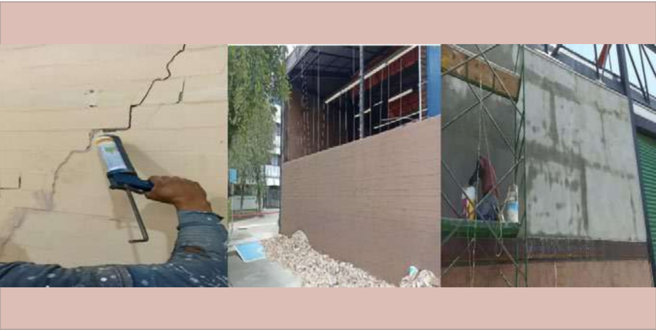
Resane, demolición y elaboración de muro.
