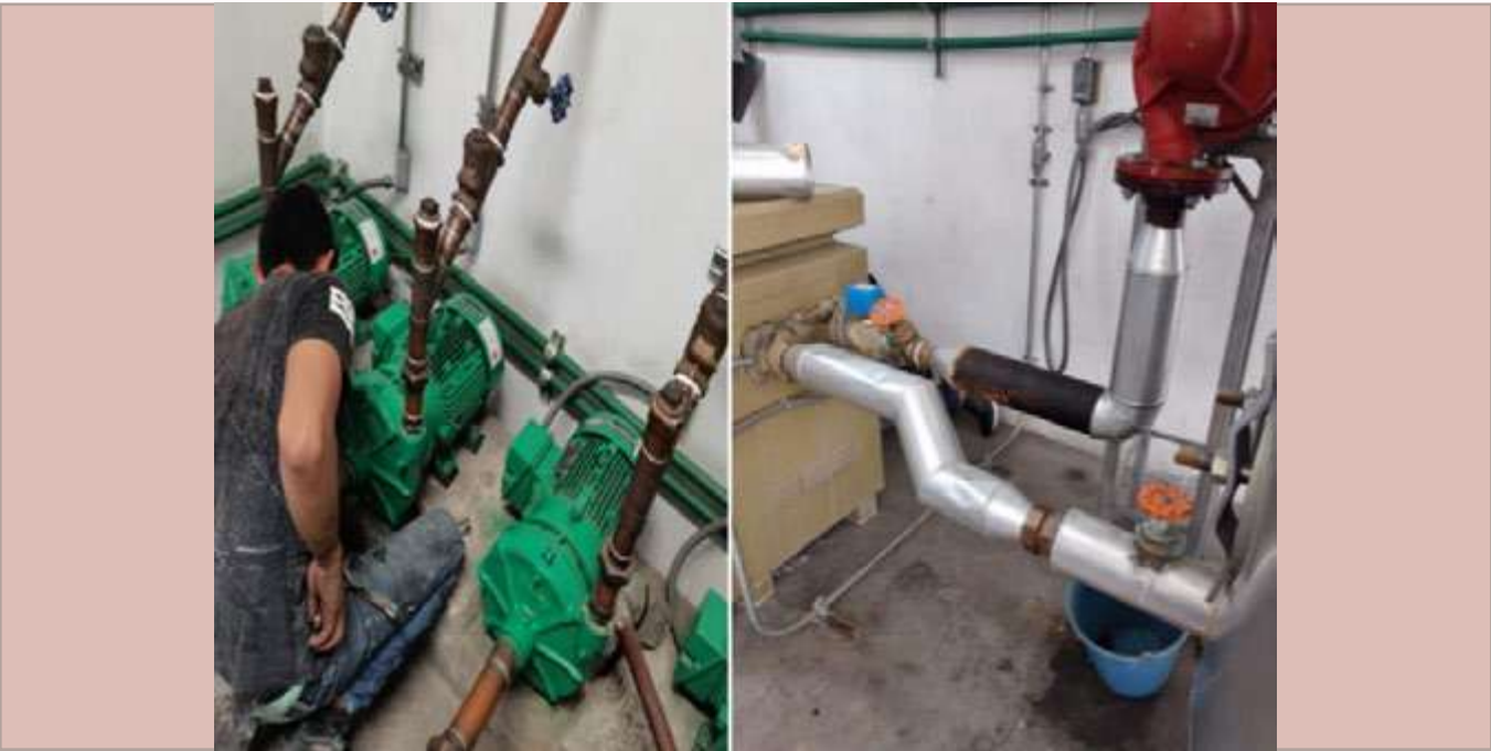
Mantenimiento a calderas e hidroneumáticos.
