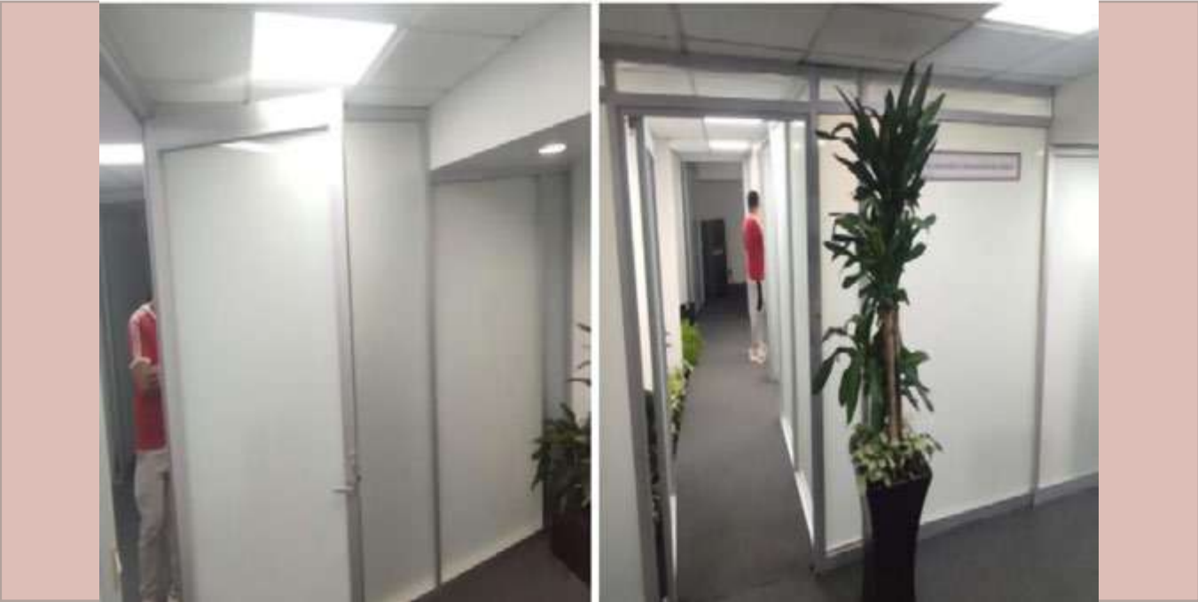
Rehabilitación de oficinas y alumbrado.
