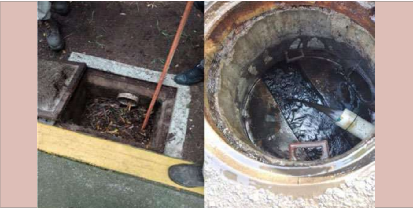
Desazolve de sistemas de drenaje.
