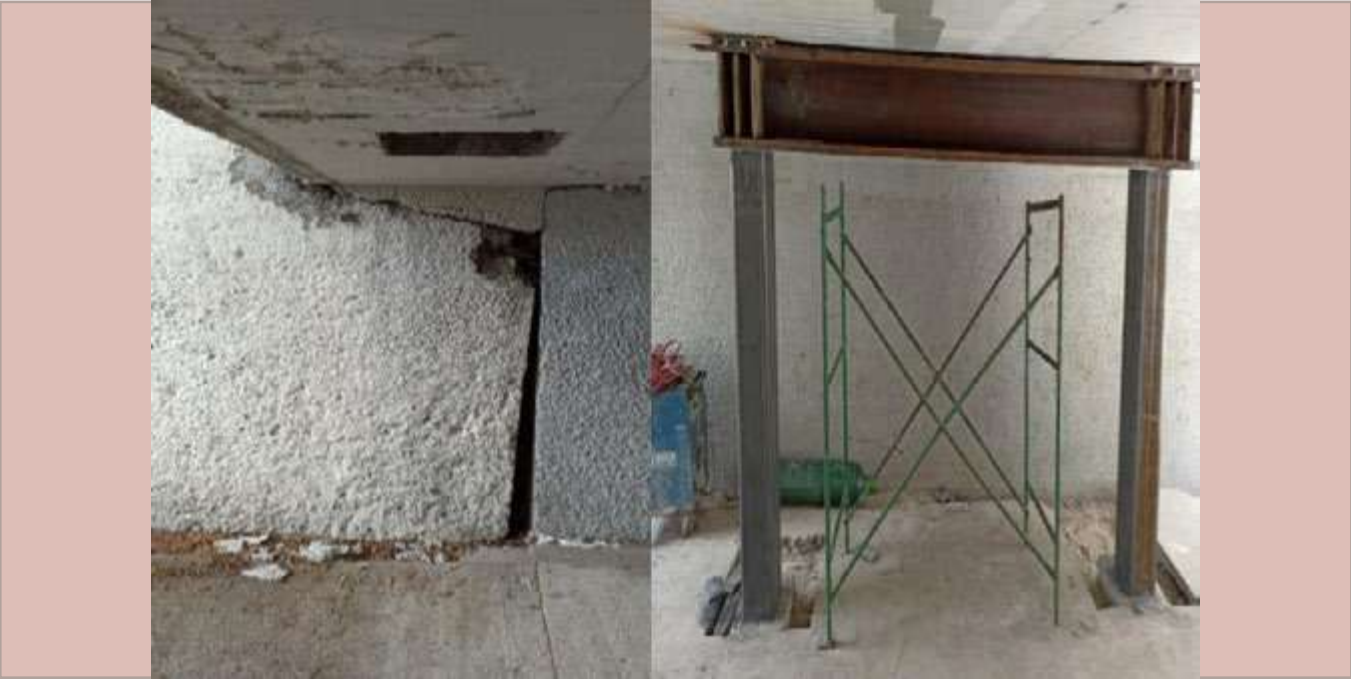
Reparación de piso, colocación de placa y fijación de losa.
