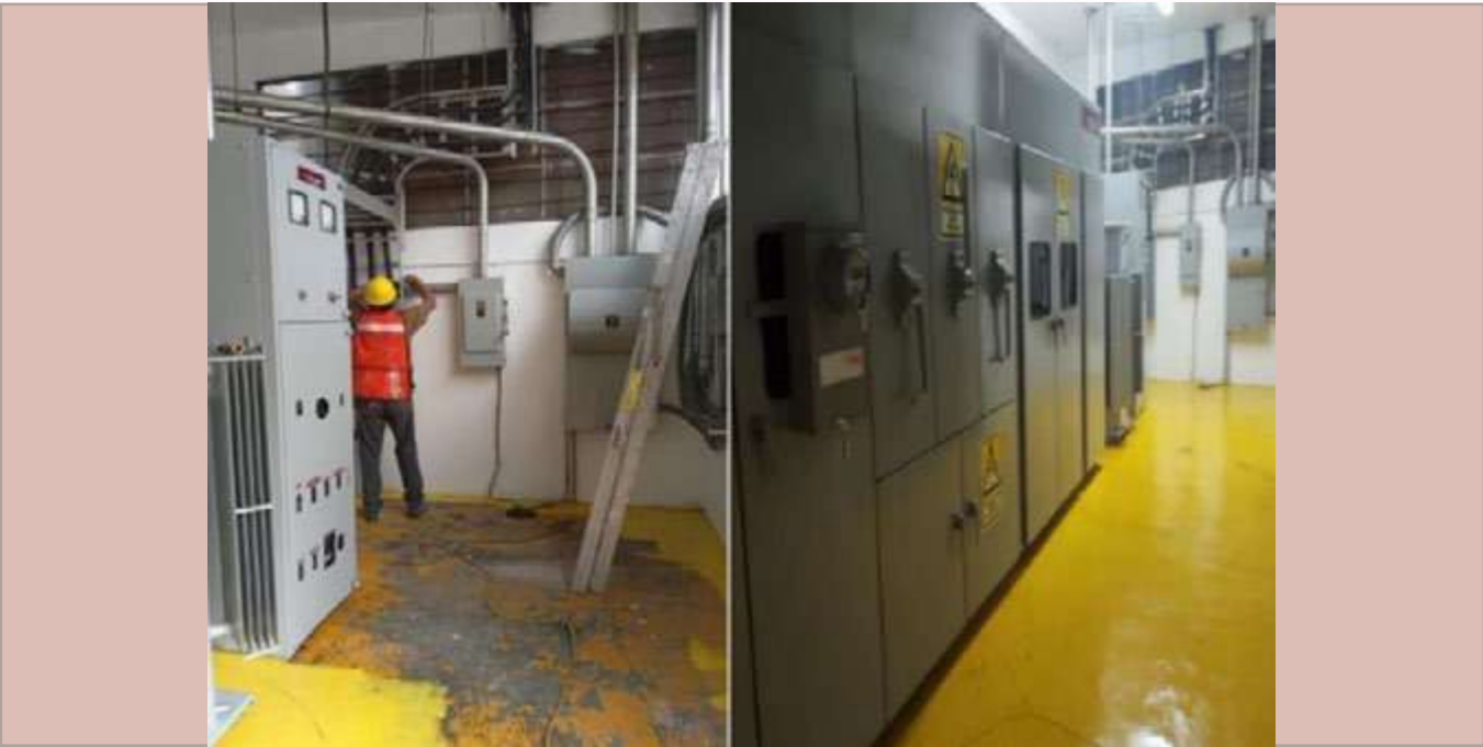
Mantenimiento al transformador de 400 KWA.
