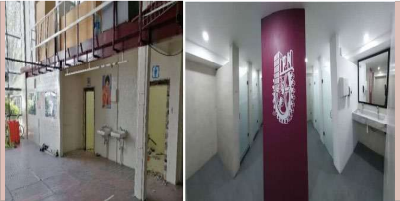
Rehabilitación de baños del gimnasio de Vacunología.
