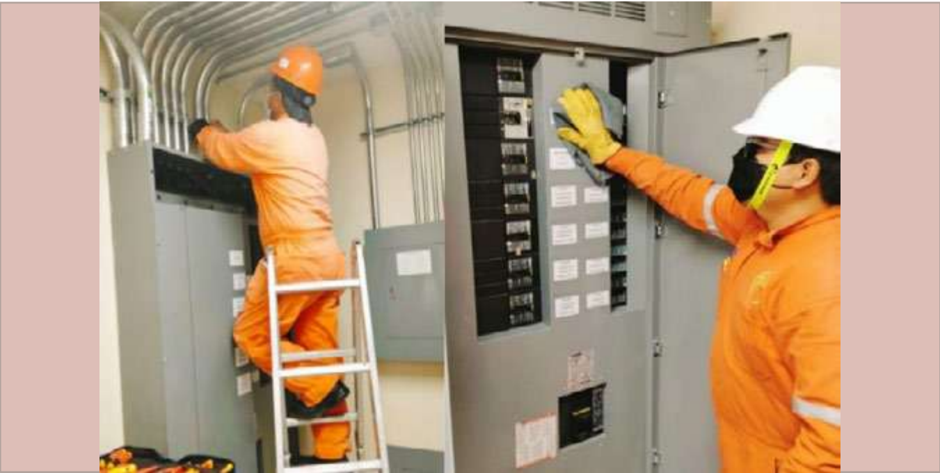
Pruebas, reacondicionamiento y limpieza de subestación.
