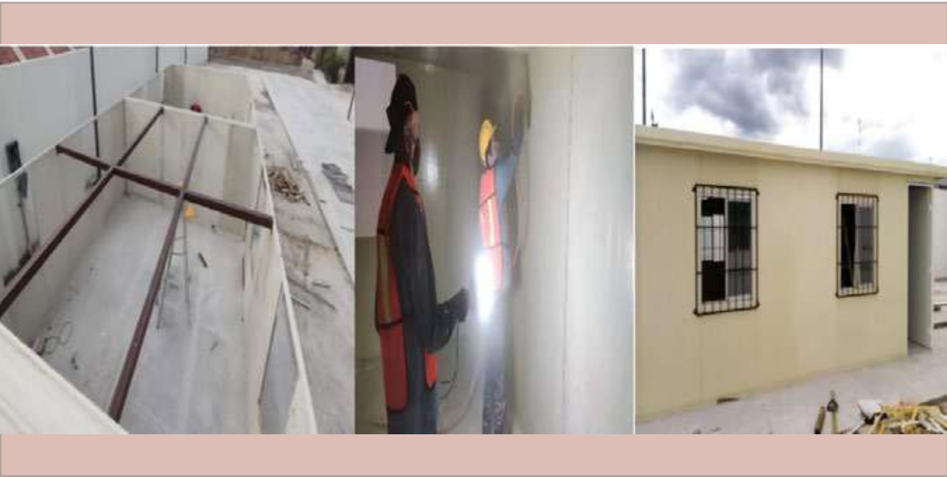
Instalación de caseta, estructuras, muros y energía eléctrica.
