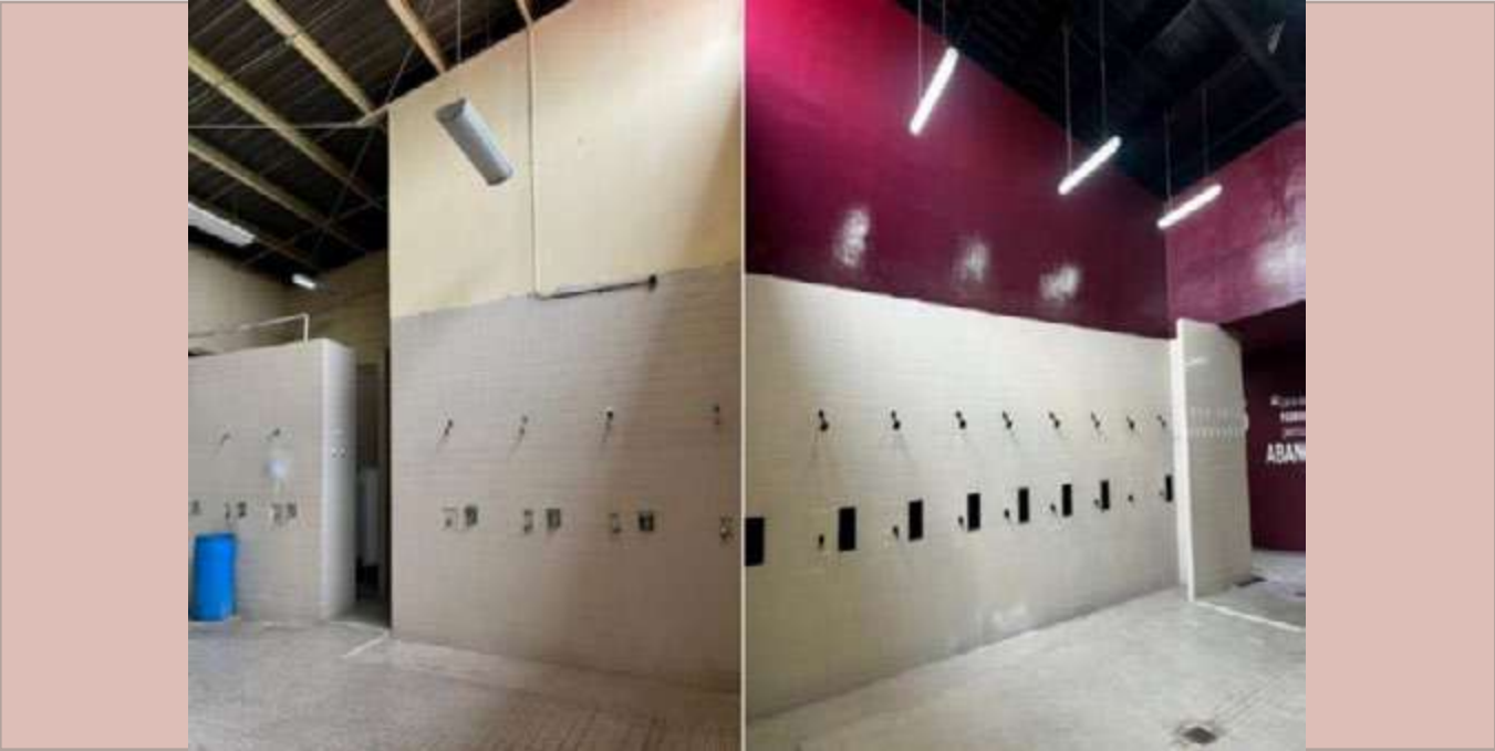
Mantenimiento de vestidores, regaderas y baños.
