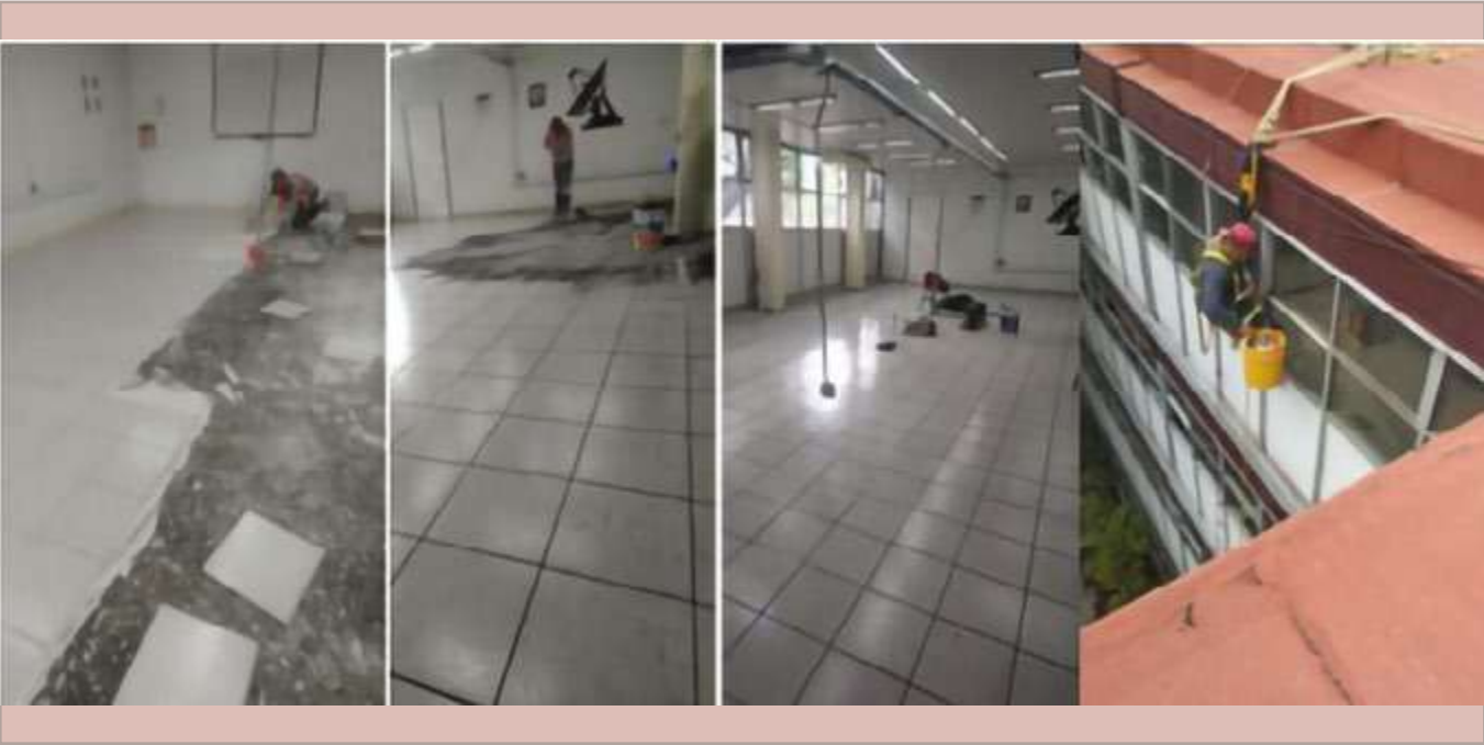
Mantenimiento piso loseta e instalaciones.
