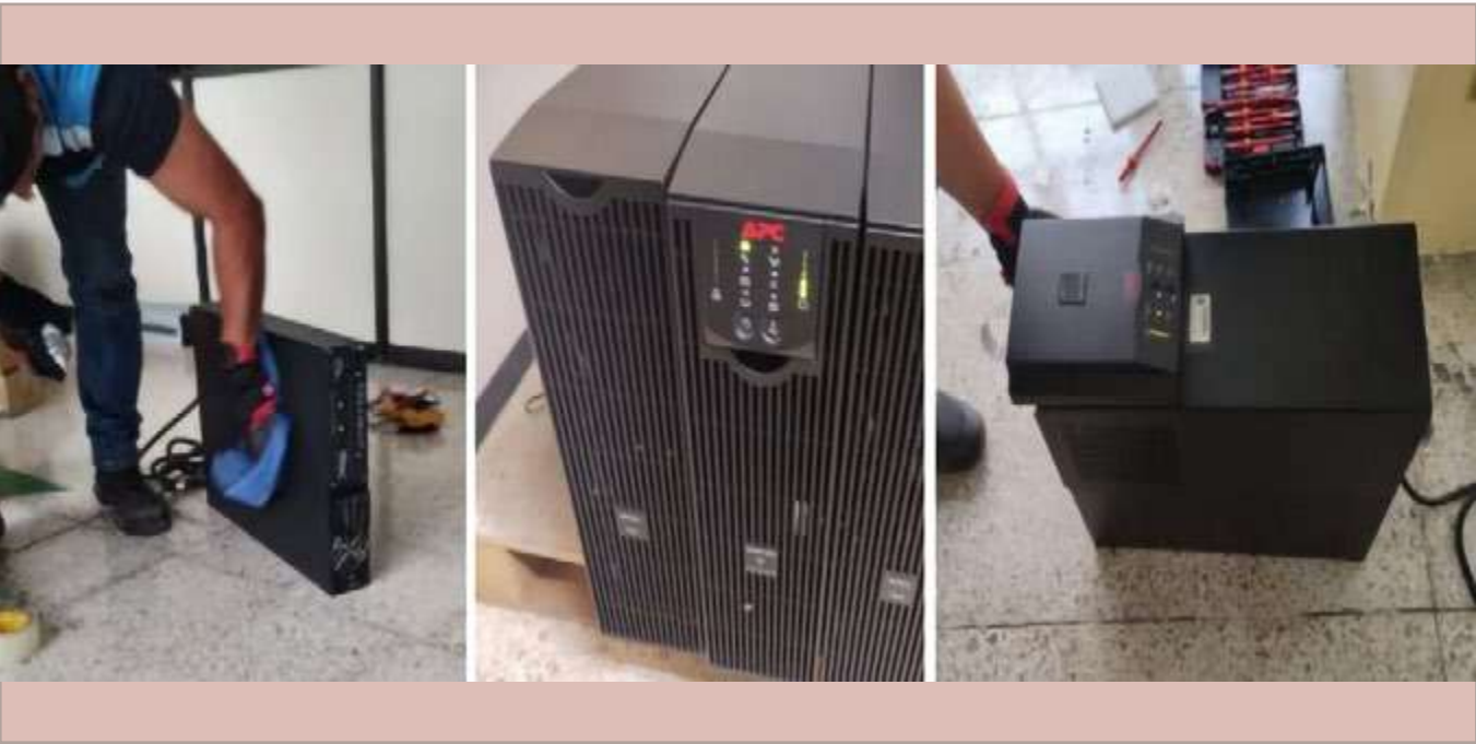
Limpieza y mantenimiento de UPS.
