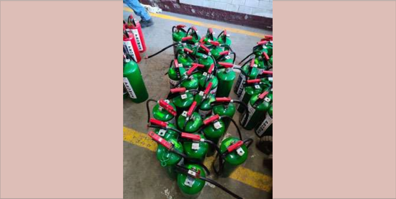
Mantenimiento y recarga de extintores.
