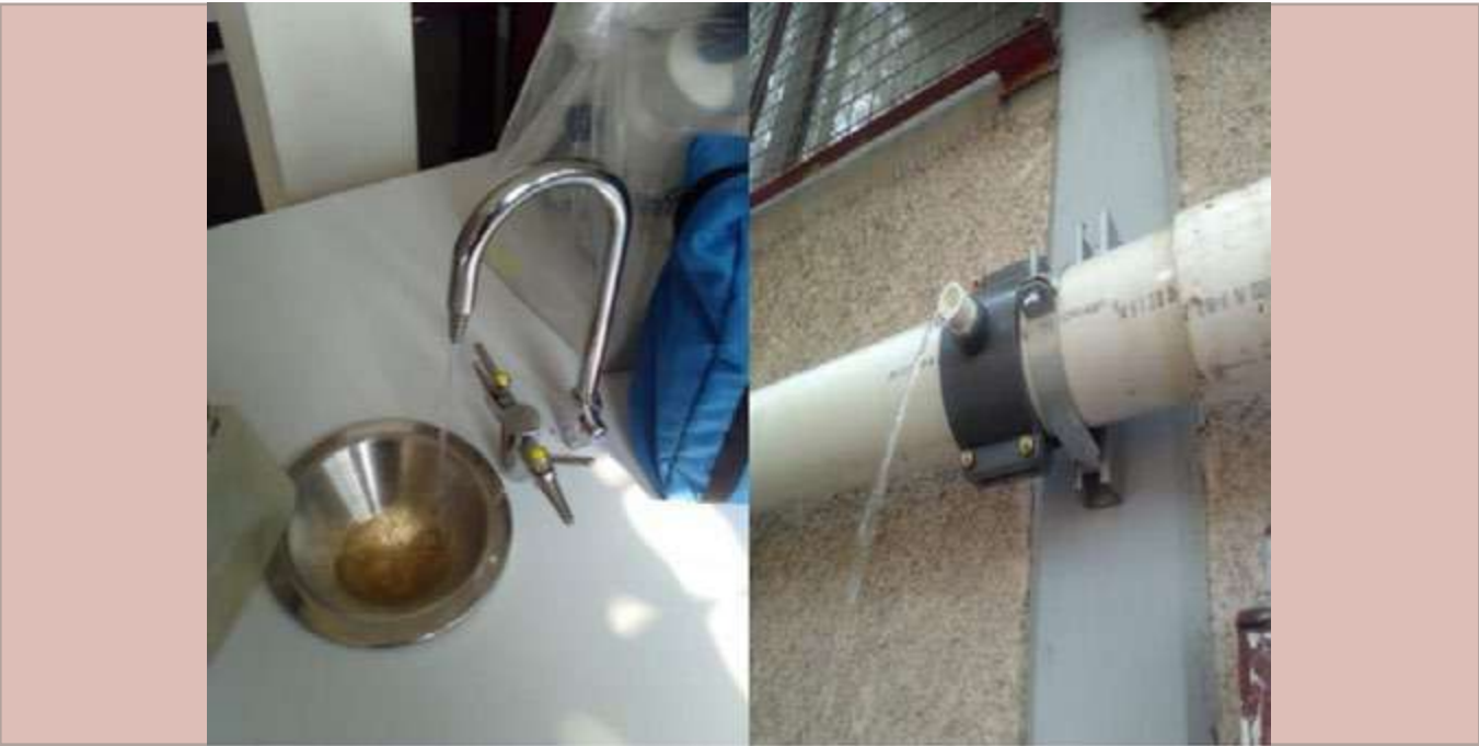
Mantenimiento a instalaciones hidráulicas.
