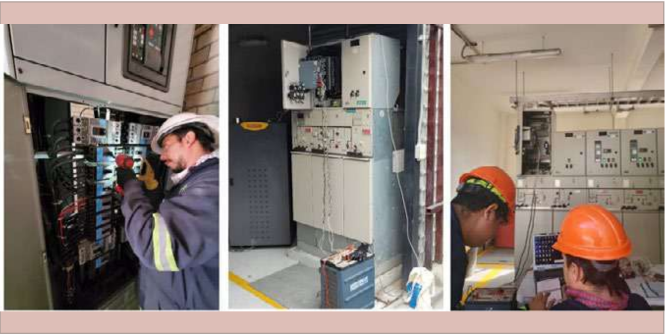
Servicio de mantenimiento a subestaciones.
