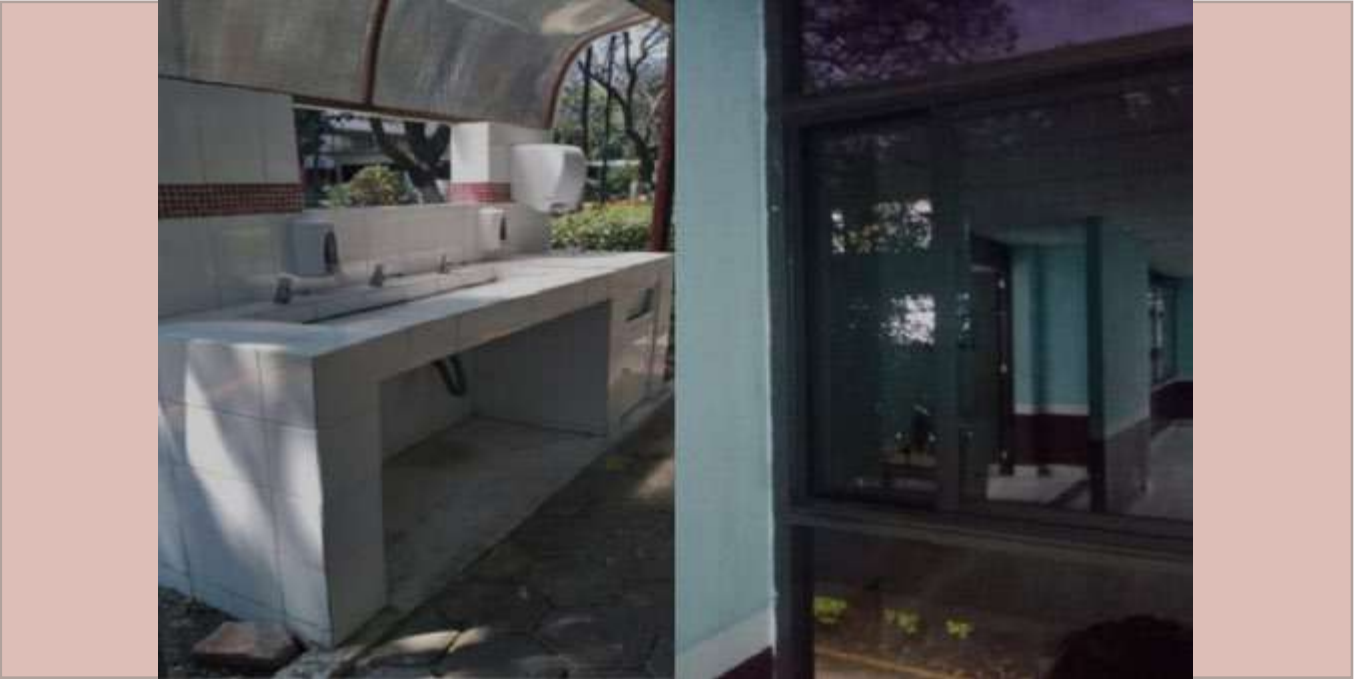
Instalación de lavabos y cancelería en ESE.
