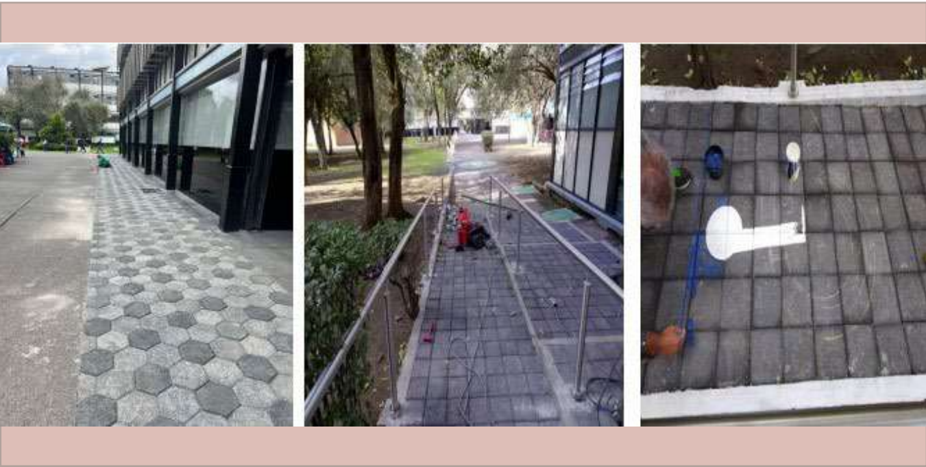
Mantenimiento perimetral, instalación de barandal y señalización.
