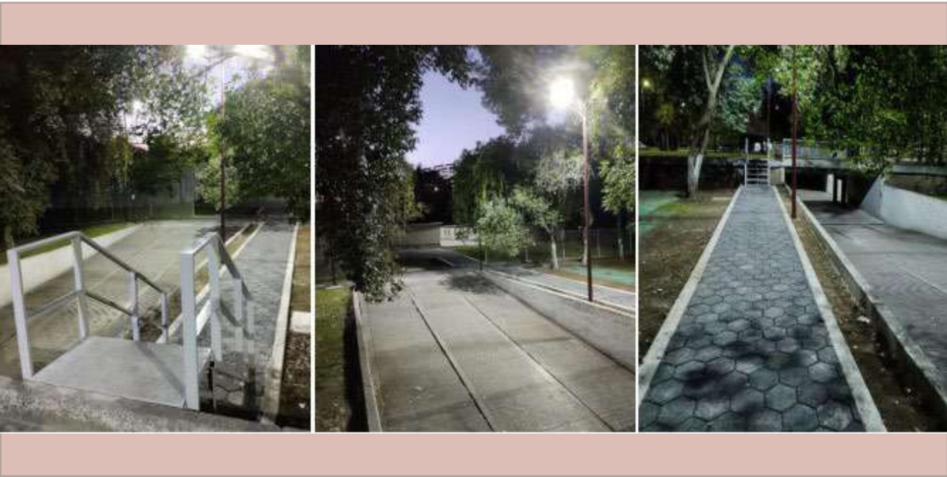
mantenimiento a luminarias y pasos a desnivel.
