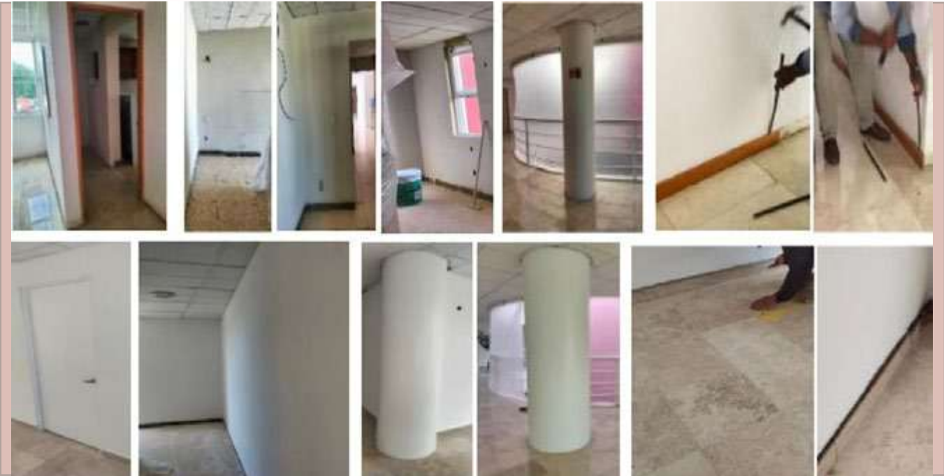
Mantenimiento en instalaciones de la RIV.
