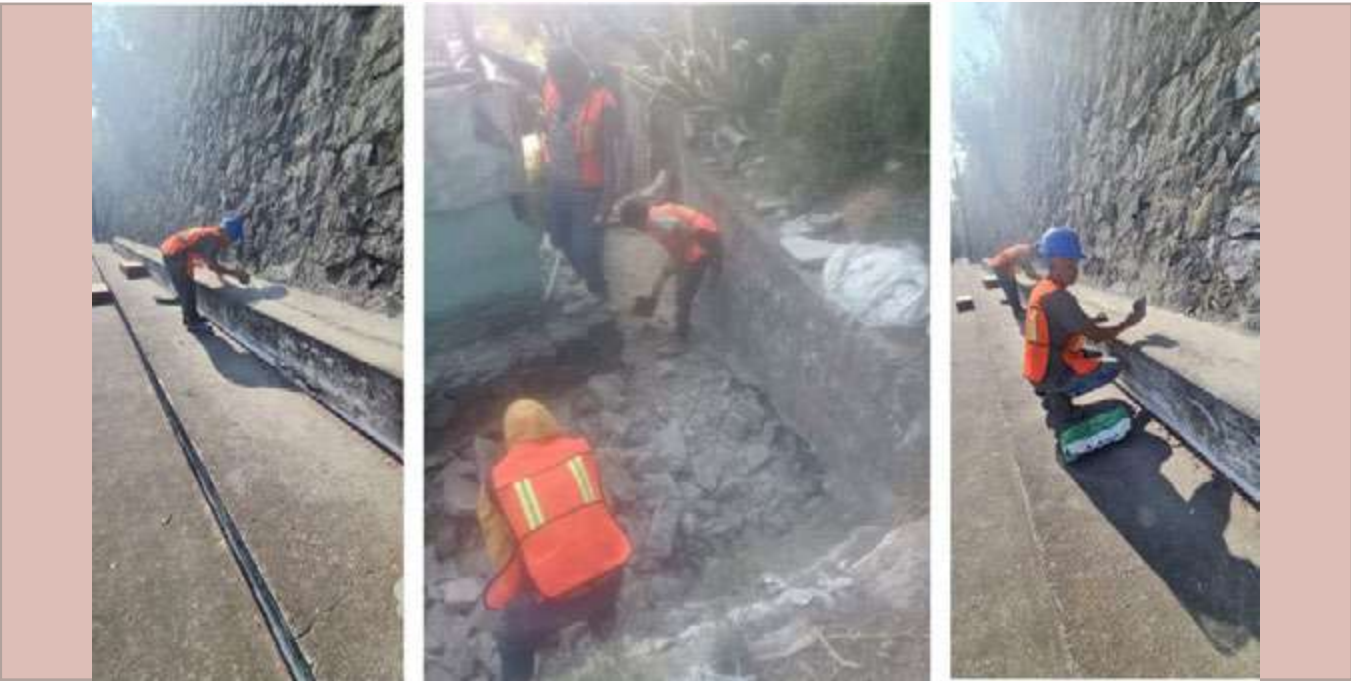
Mantenimiento en barda perimetral.
