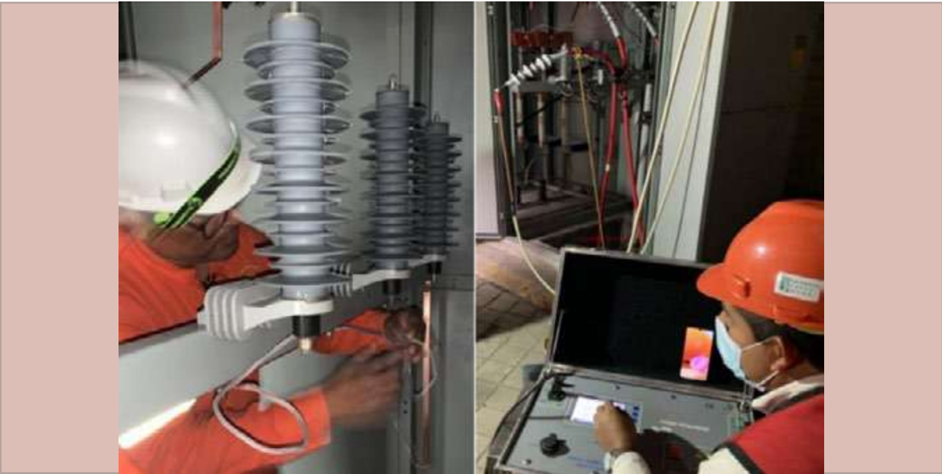
Reacondicionamiento, pruebas y reparación de subestación.
