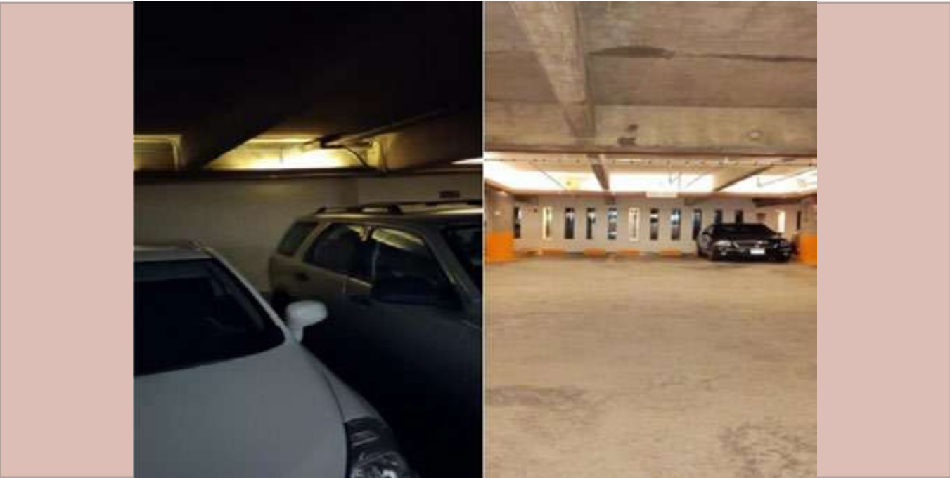
Mantenimiento a instalaciones eléctricas de la Dirección General.
