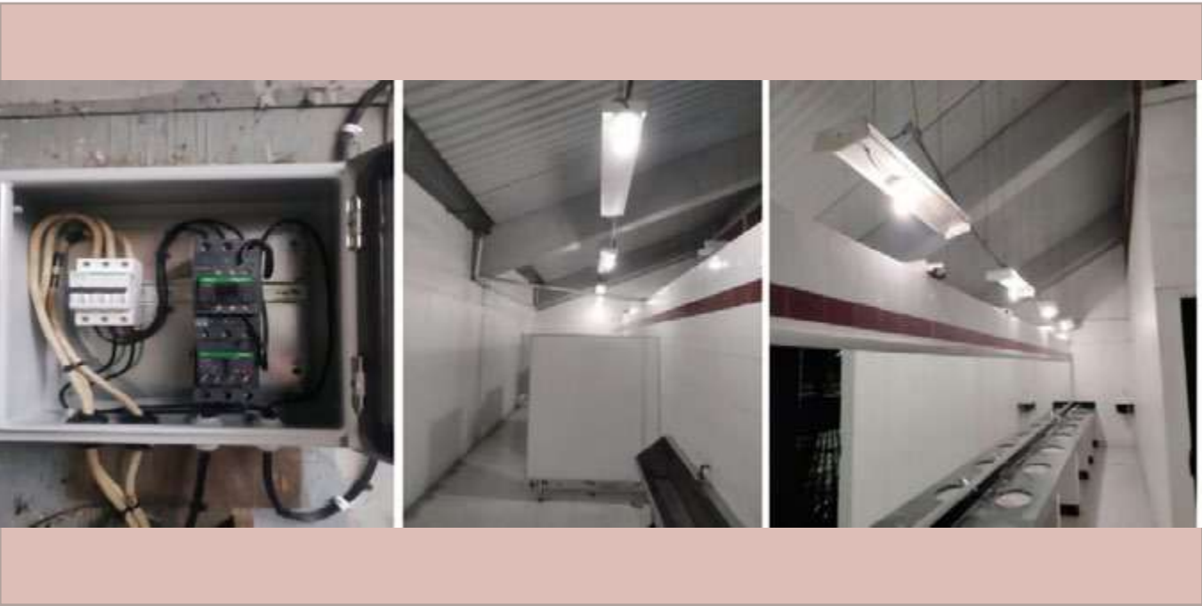
Mantenimiento e instalación de luminarias.
