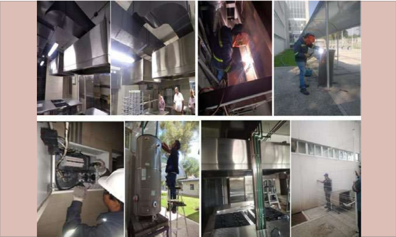
Mantenimiento preventivo y correctivo eléctrico al edificio de gastronomía.
