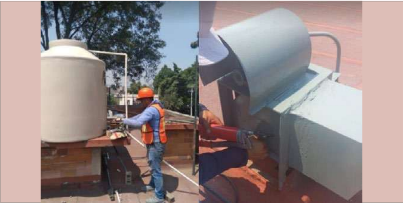
Mantenimiento a extractores de aire.
