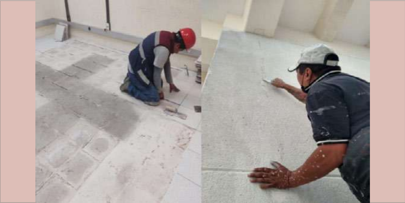
Reparación de muros, paredes, plafones y acabados de pisos
