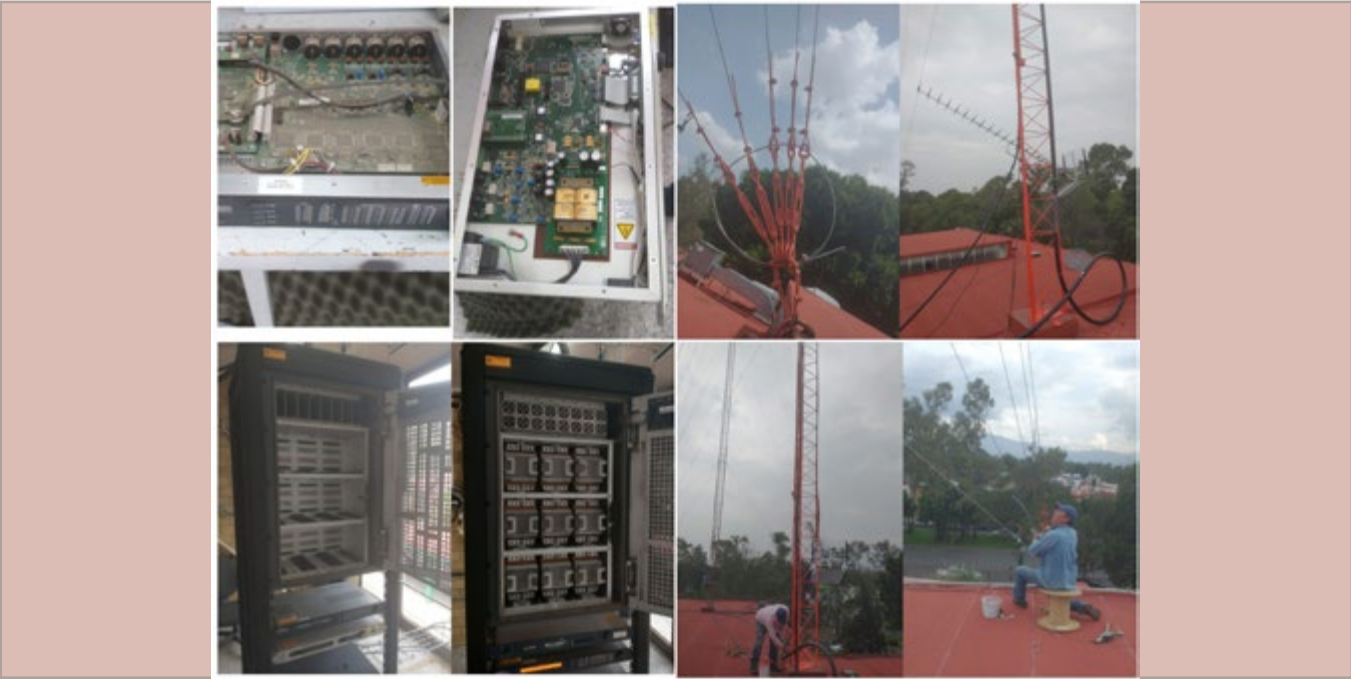
Mantenimiento preventivo anual al equipo de transmisión y a la torre arriostrada de Radio IPN.
