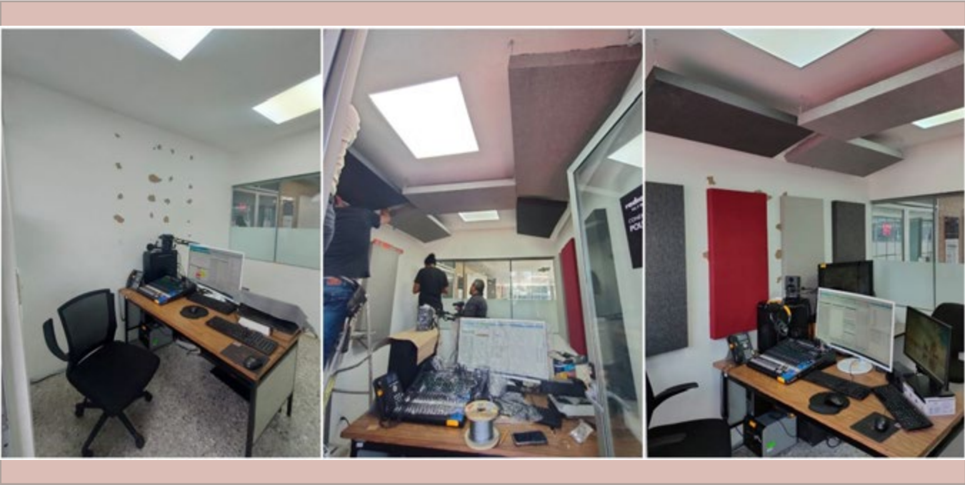
Mantenimiento correctivo a la cabina de operación y transmisión de Radio IPN en la ESIME Culhuacán.
