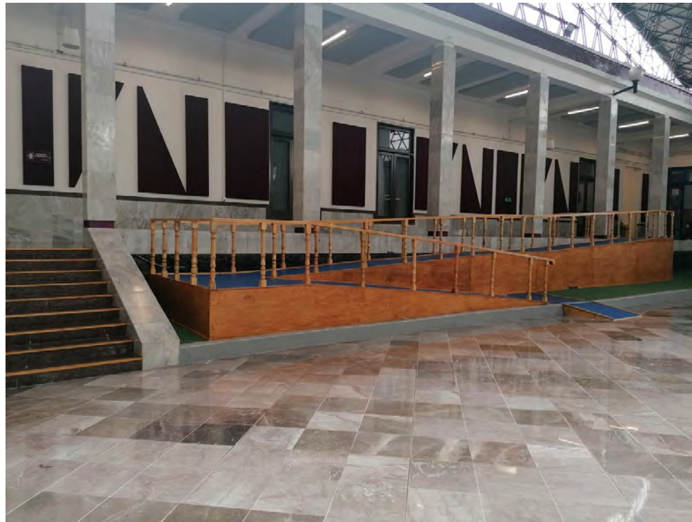
Rampa de acceso Decanato
