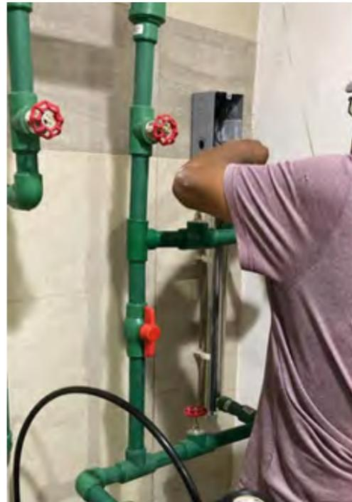
Mantenimiento a tubería hidráulica y filtros del edificio de Gastronomía
