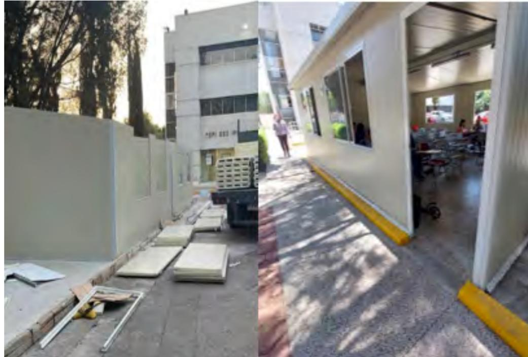
Instalación de casetas prefabricadas a base de multipanel
