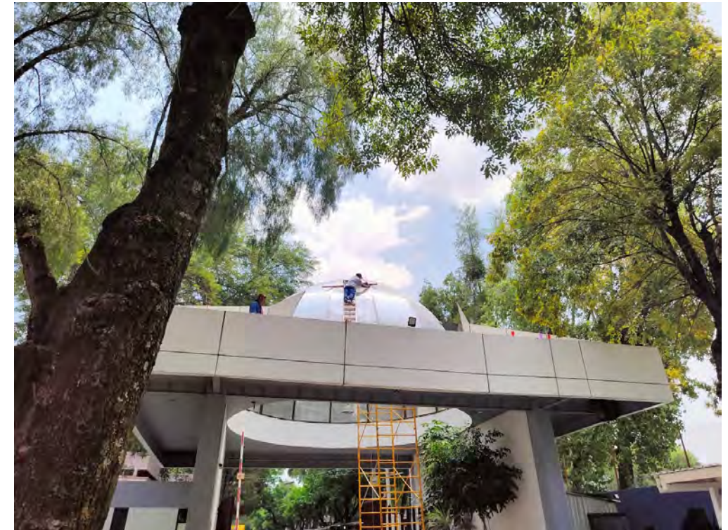
Reparación y sustitución de láminas del domo de entrada principal del estacionamiento No 1
