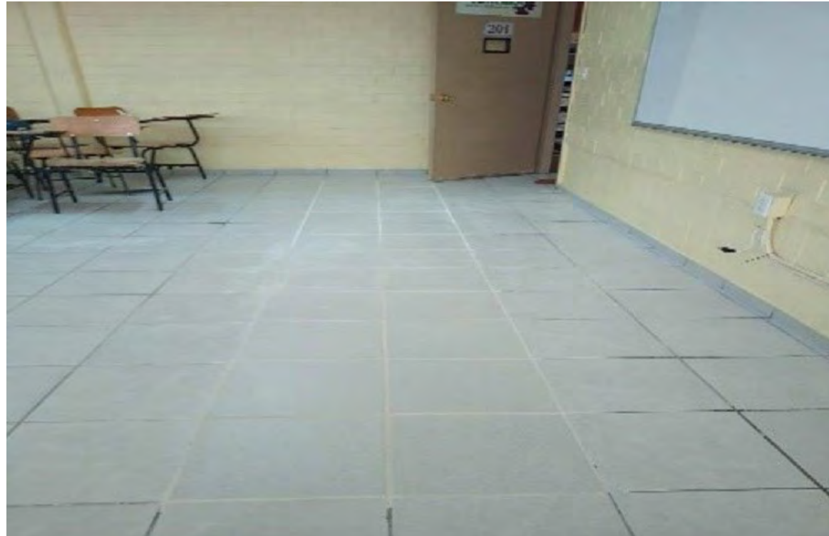
Mantenimiento a piso del salón 201 del edificio “D
