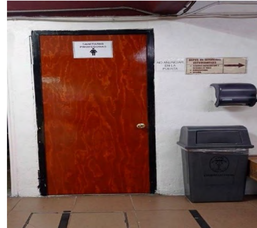
Mantenimiento a puertas de sanitarios docentes
