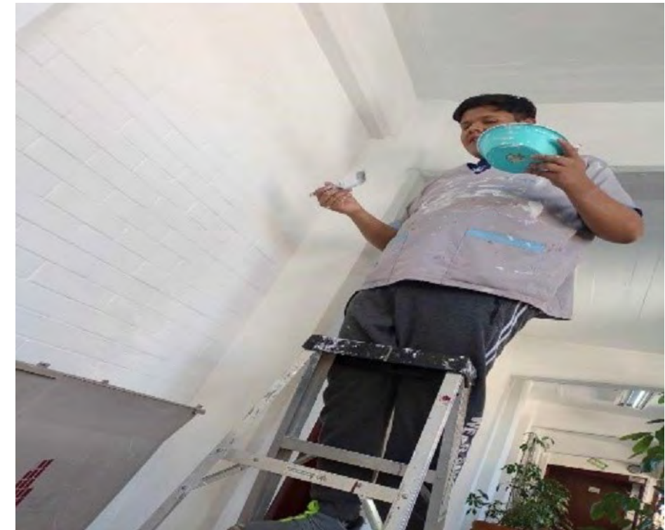
Pasillo de CELEX Revillagigedo No. 83 Col. Centro
