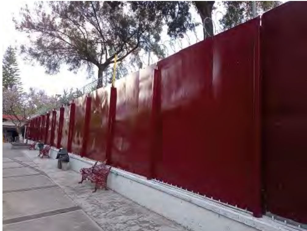
Mantenimiento a puertas de acceso principal
