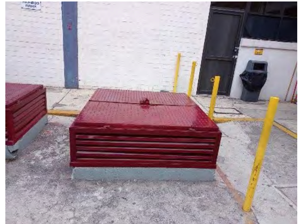
Mantenimiento a tapa de cisterna
