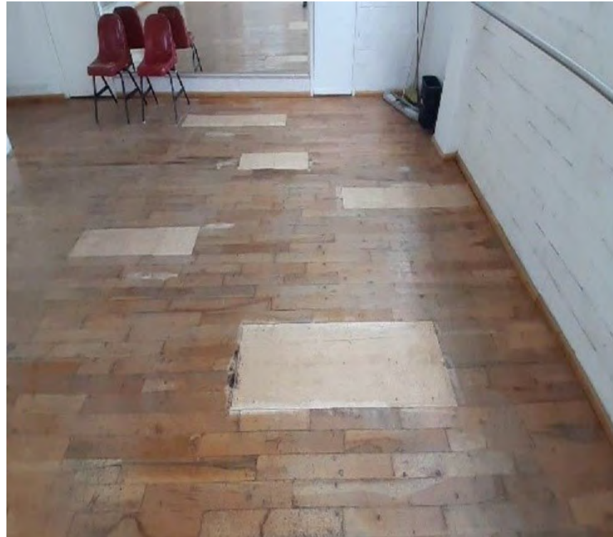
Mantenimiento a duela del salón de danza
