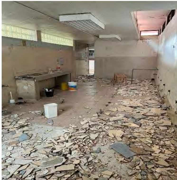
Mantenimiento a baños
