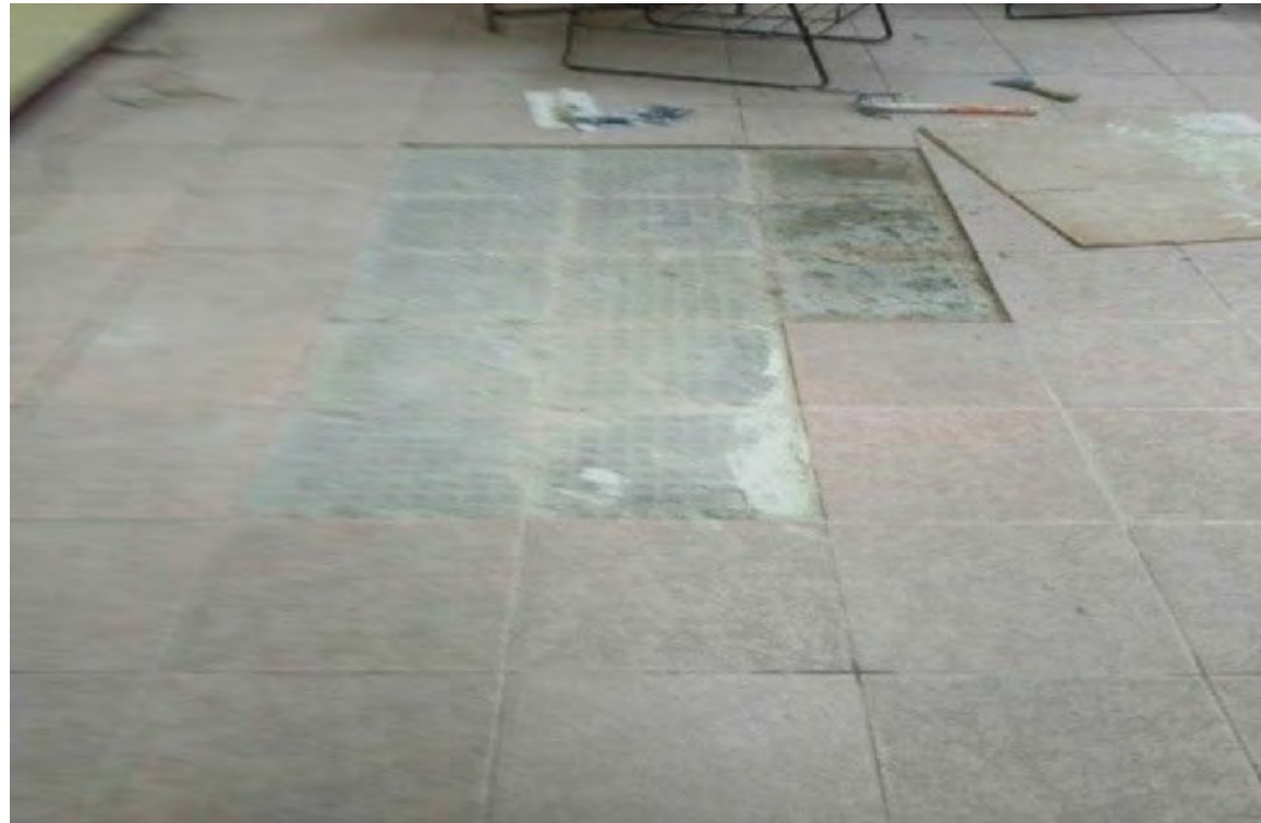
Reemplazo de loseta en el salón del edificio A
