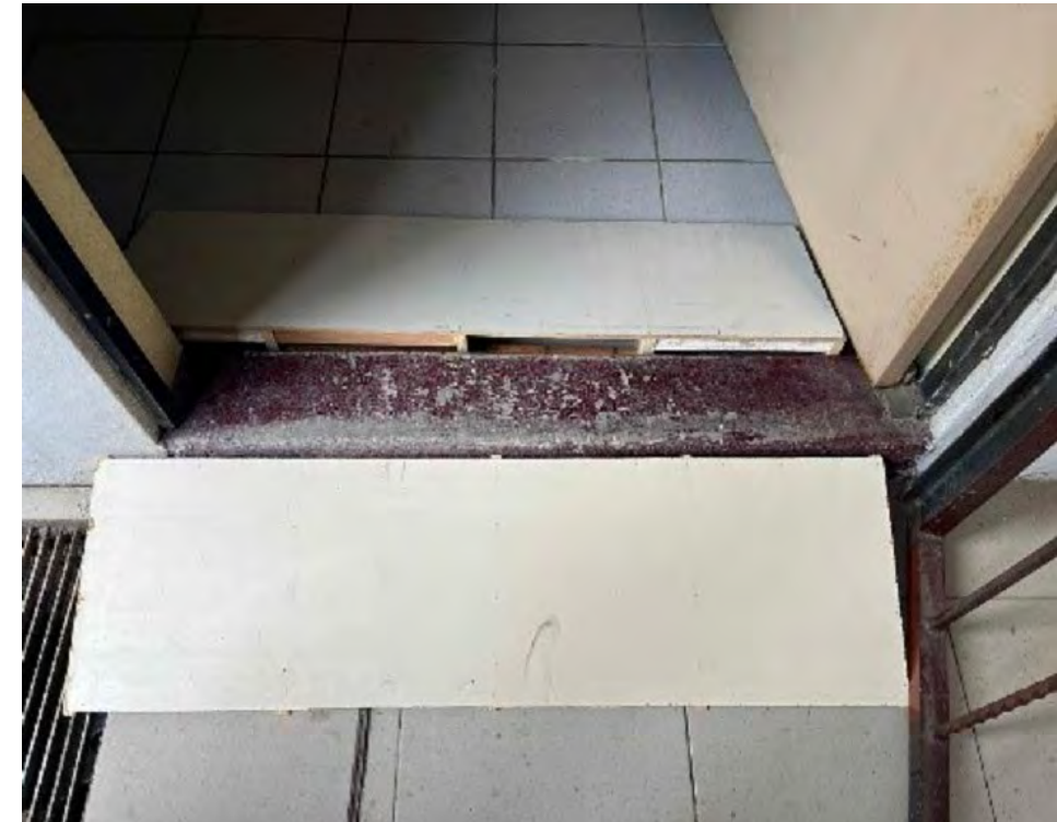
"Rampa de acceso al Laboratorio de Química"
