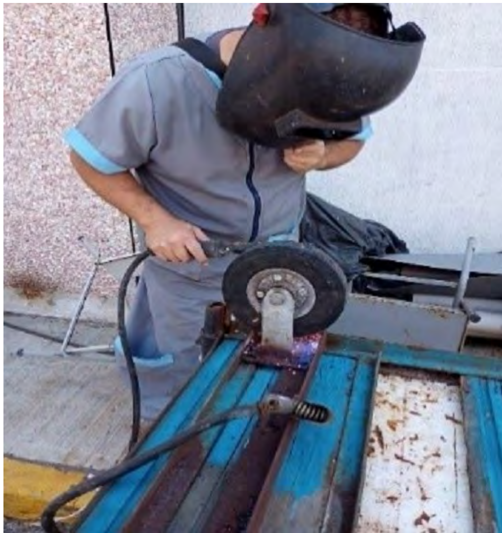
Reparación de góndola
