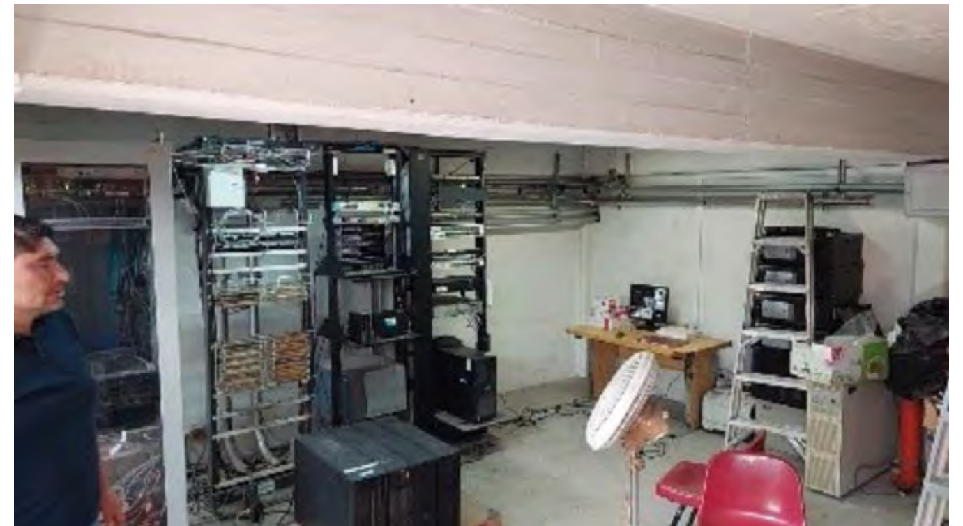
Proyecto de cambio de fibra óptica
