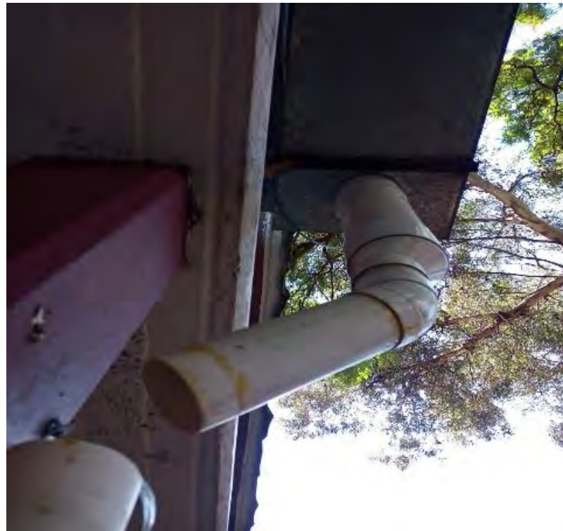
Canalones del área de Servicio Médico
