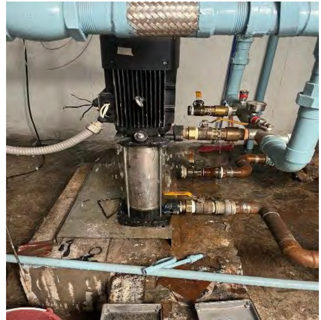
Mantenimiento a bombas
