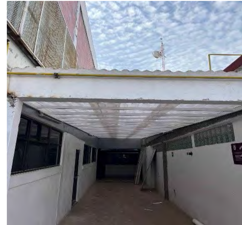
Mantenimiento a techumbre
