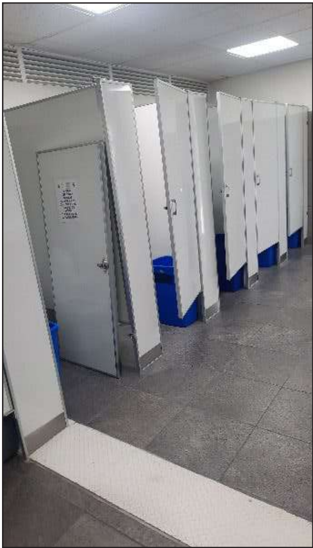
Reparación de puerta de mampara que se desprendió en sanitarios del edificio C
