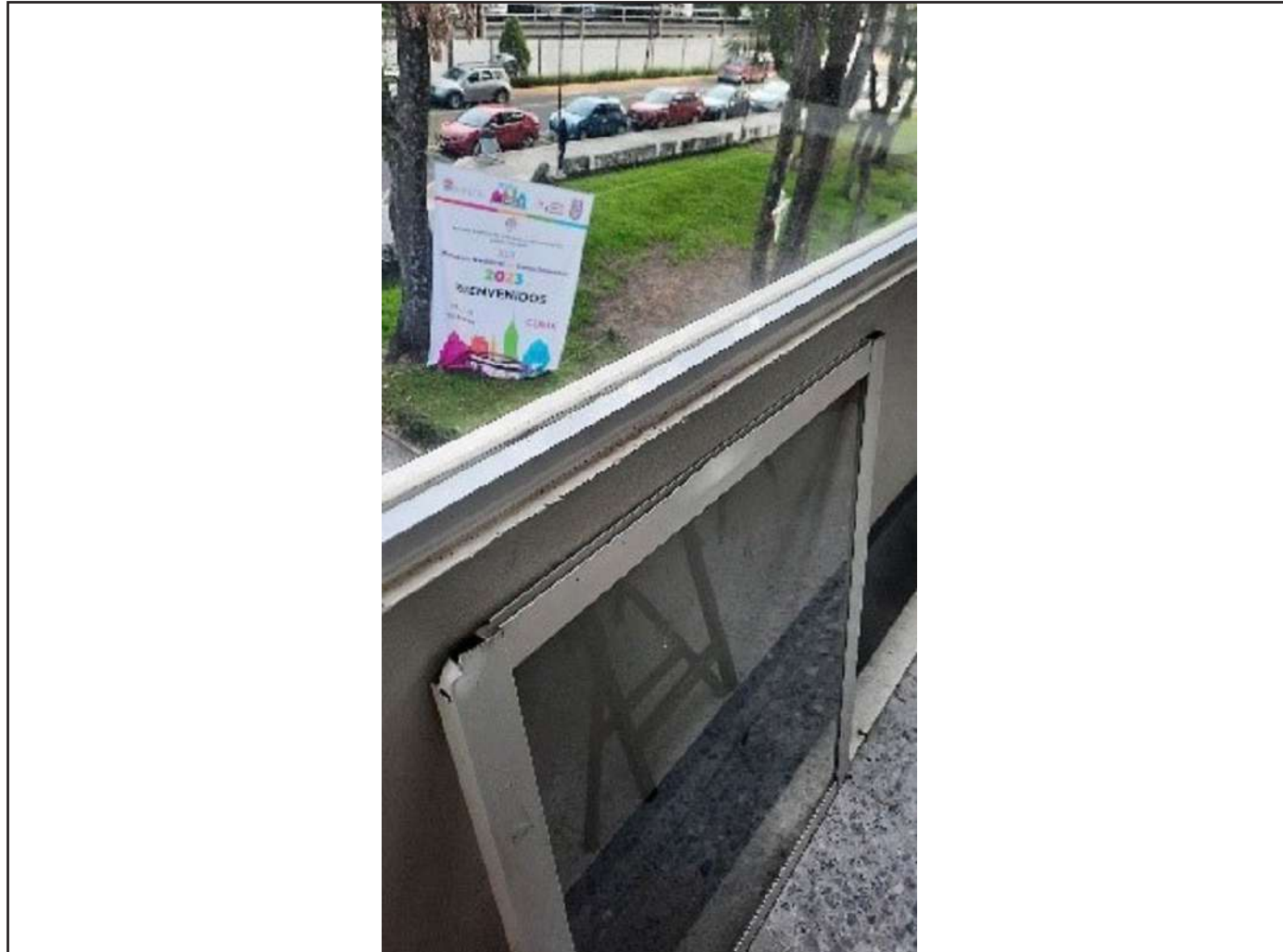
Reparación de ventana dañada en aula del edificio C
