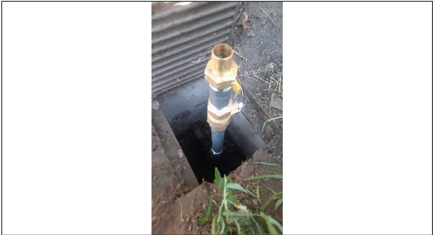
Válvula reparada en bodega de jardinería
