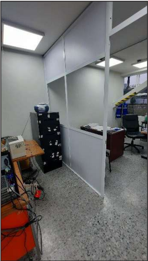
Instalación de cancelería en la UPIS
