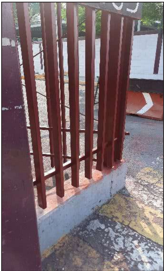
Aplicación de pintura nueva en reja de acceso en Avenida Periférico
