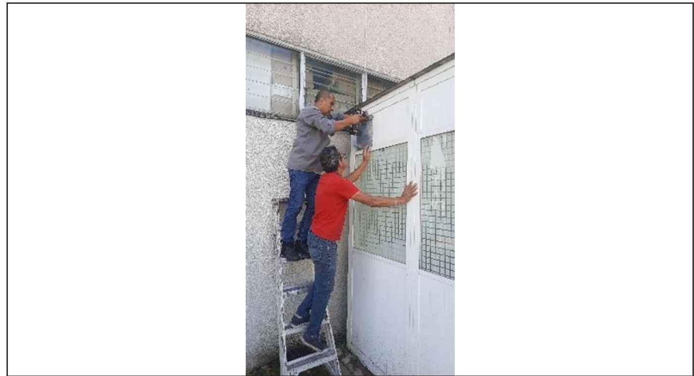
Instalación de malla para proteger el extractor de aire en caseta
