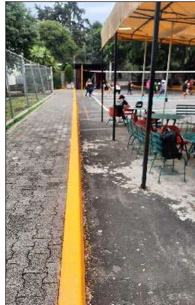
Aplicación de pintura en guarniciones del área de contenedor
