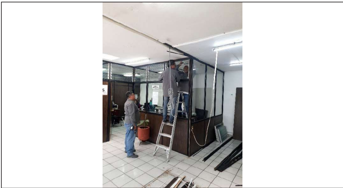
Retiro de cancelería existente en nueva área de Prácticas Escolares
