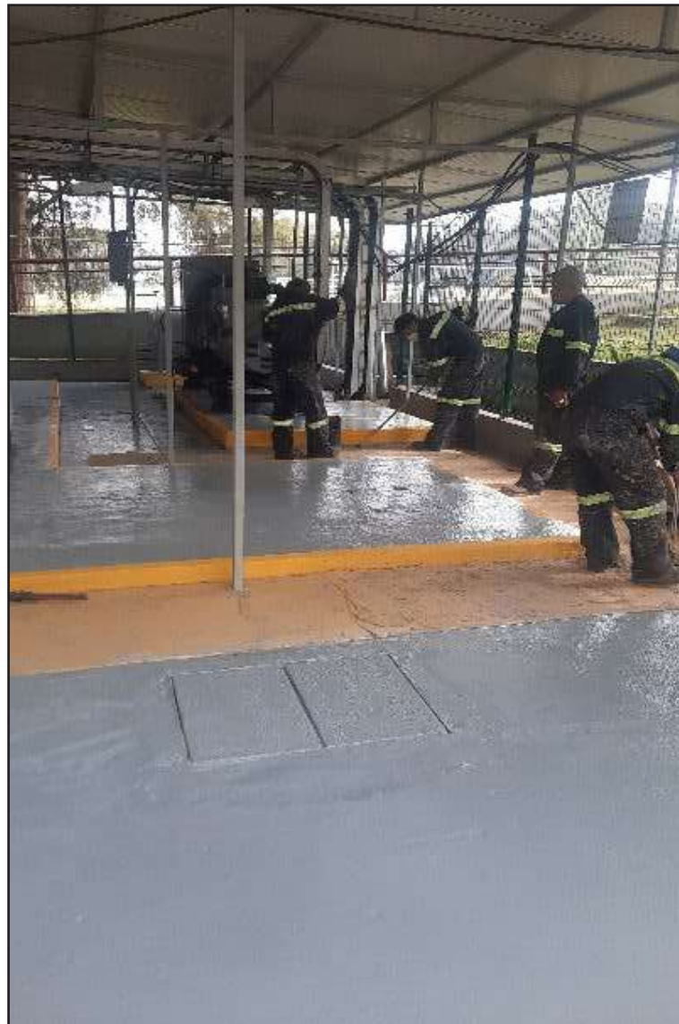
Aplicación de pintura en área de subestación y plantas de emergencia
