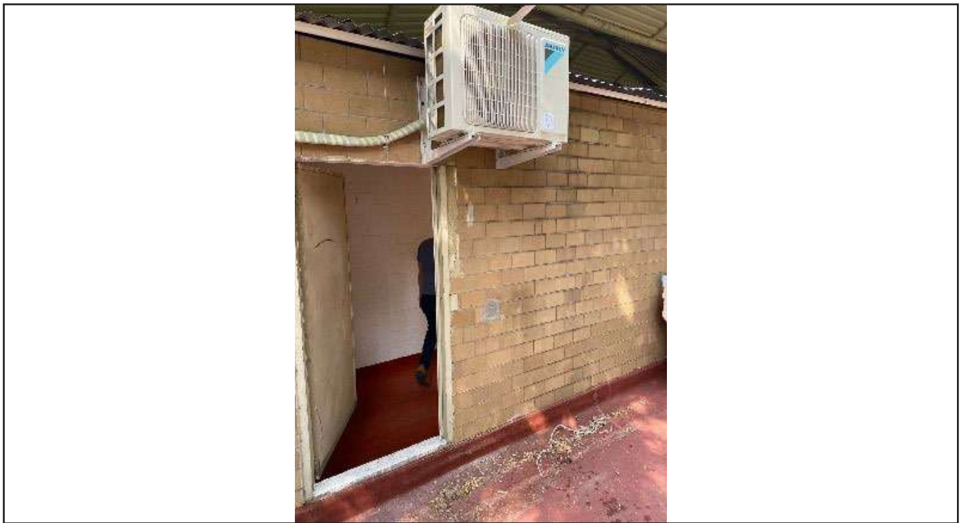
Instalación de condensador del aire acondicionado
