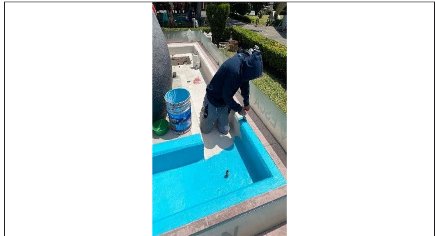
Aplicación de pintura especial para alberca en fuente de la explanada
