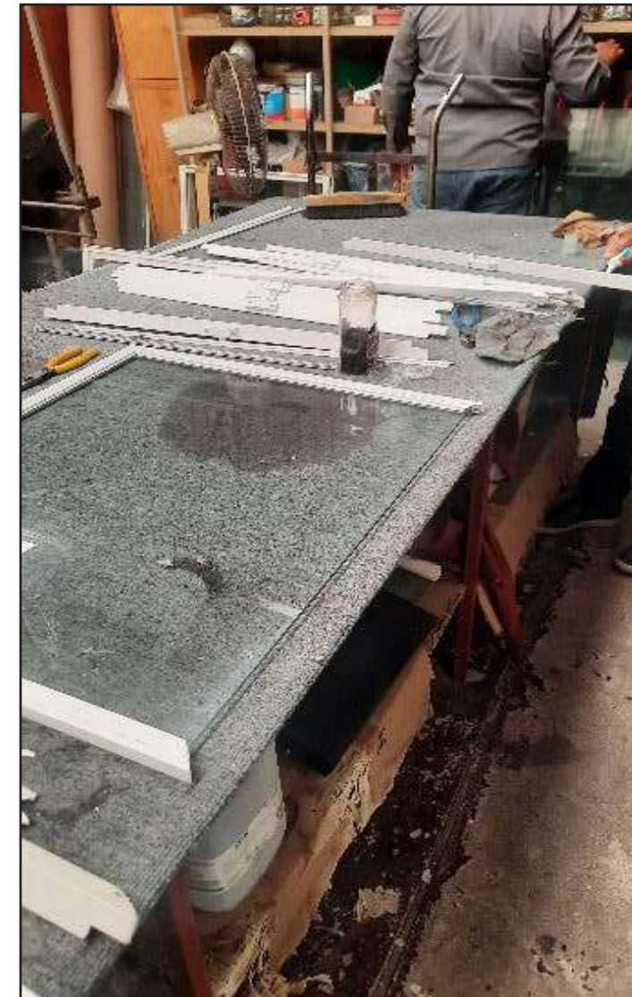
Reparación de ventana de aulas
