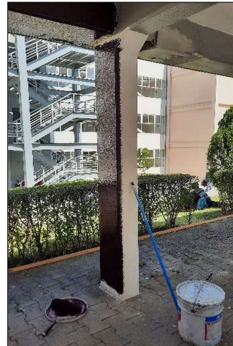
Aplicación de pintura en andadores de la Unidad Académica
