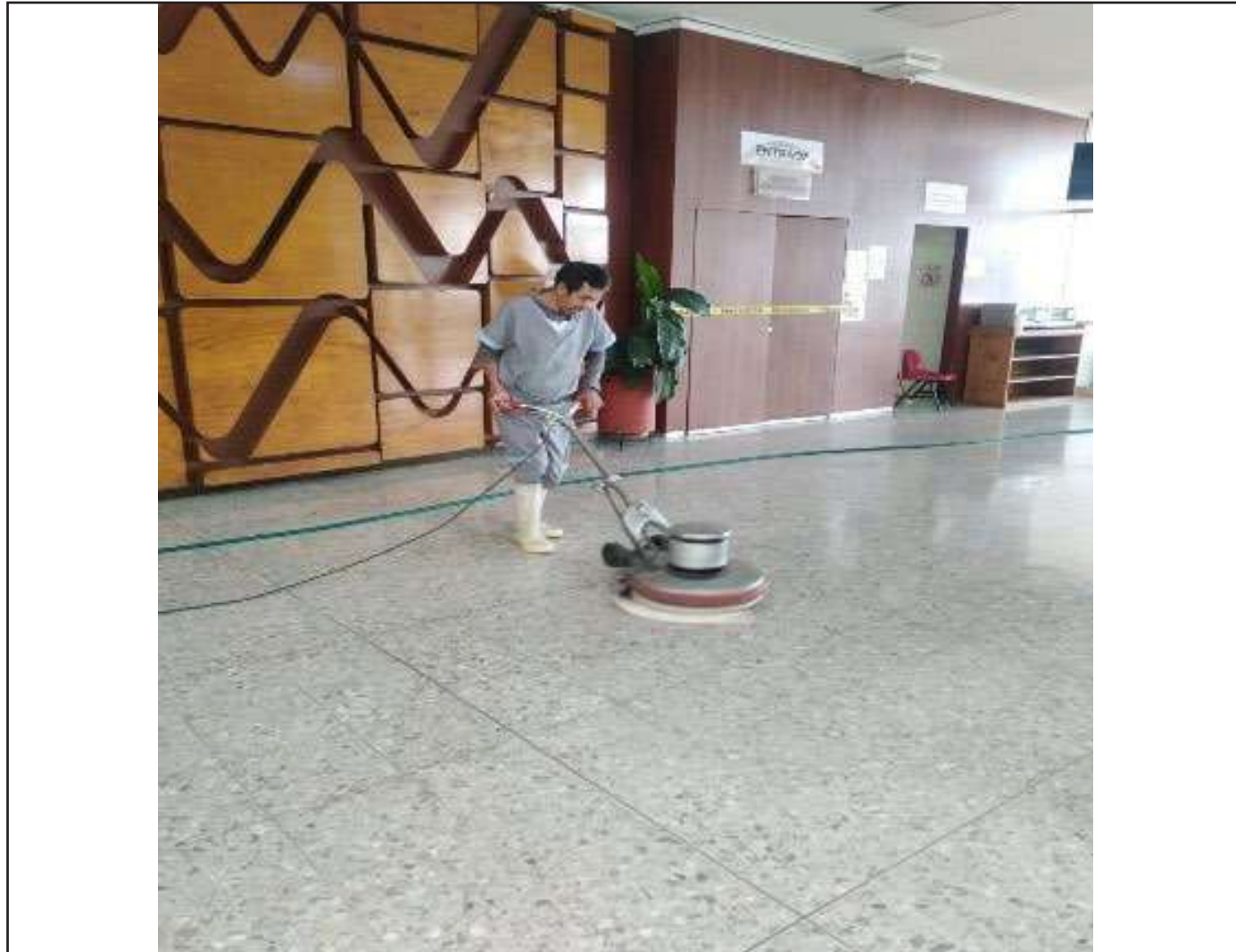
Pulido de piso en lobby del edificio de Gobierno
