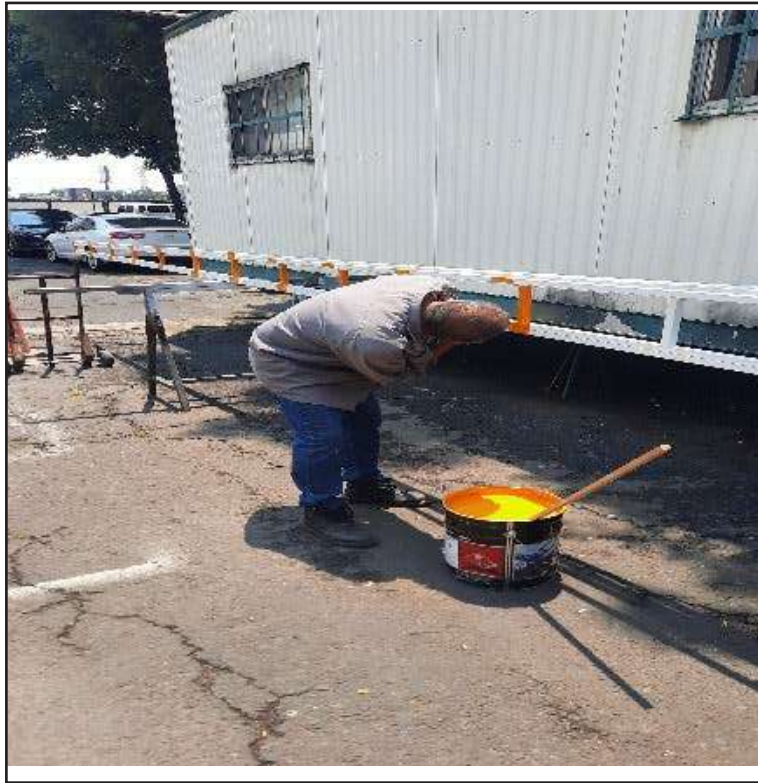
Aplicación de pintura en estructura para pluma de acceso vehicular por la calle de Salubridad
