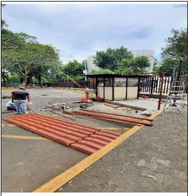
Armado de la estructura para caseta de vigilancia en acceso de la calle de Salubridad
