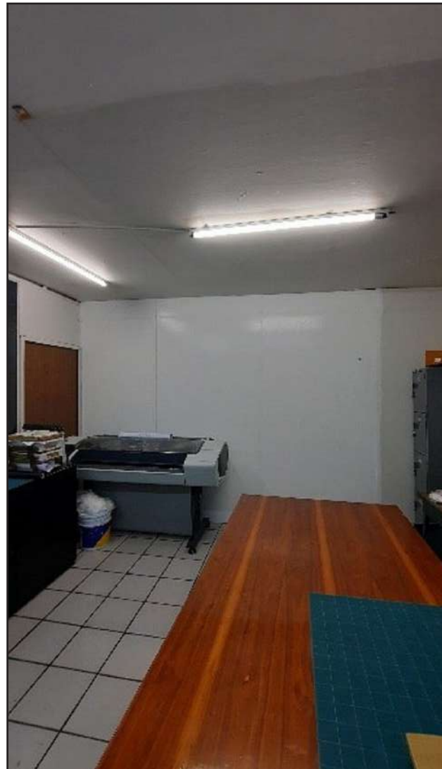
Aplicación de pintura en muros y techo de oficina de Publicaciones
