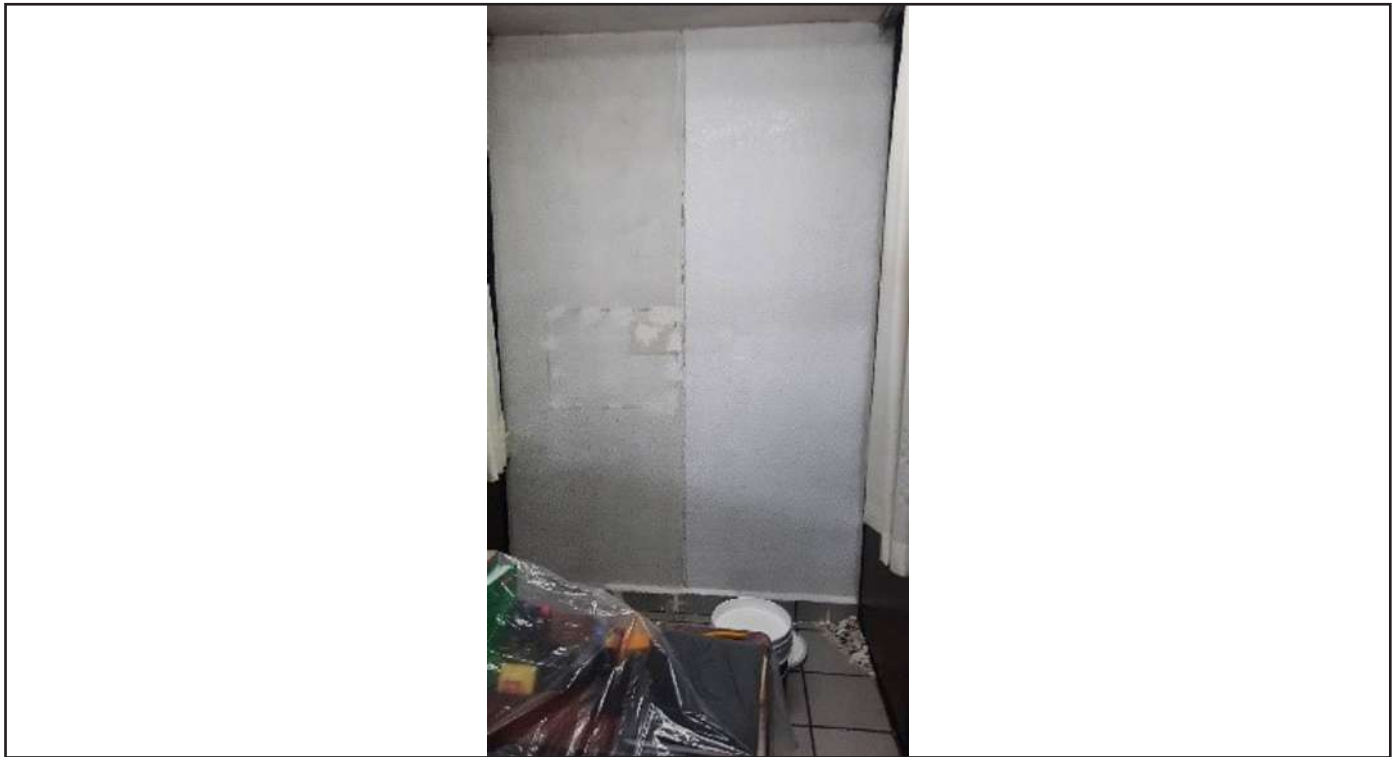
Aplicación de pintura en muros de la Oficina de Innovación Educativa
