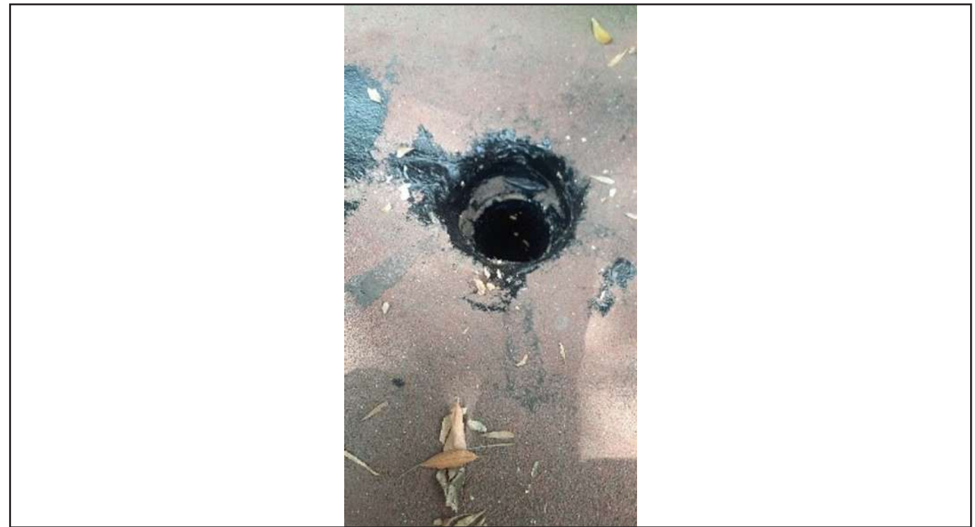
Aplicación de impermeabilizante Vaportite 550 en bajada pluvial en el edificio A
