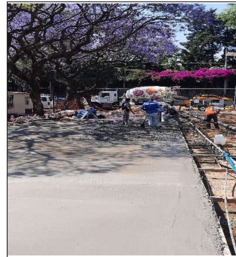
Armado y colado de planchas de concreto para traslado de aulas prefabricadas
