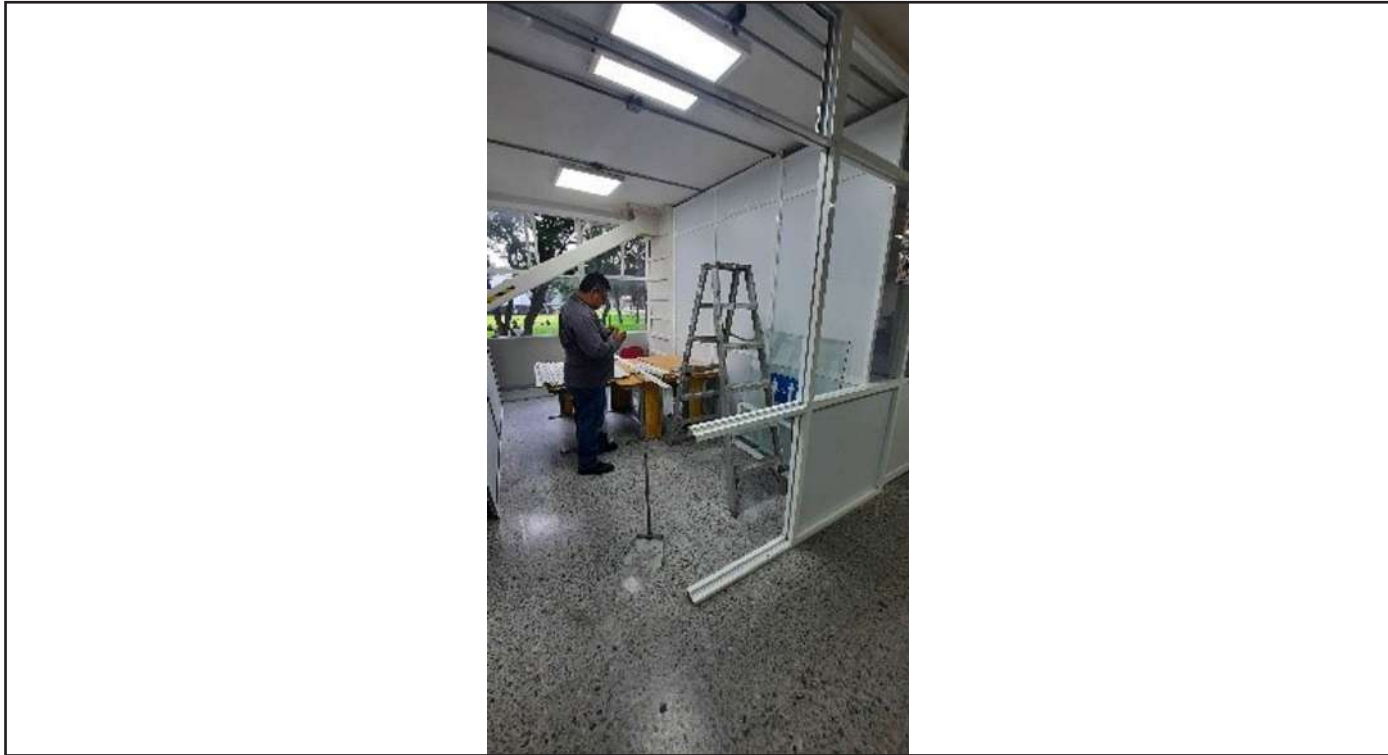
Trabajos de retiro e instalación de cancelería para división del área
