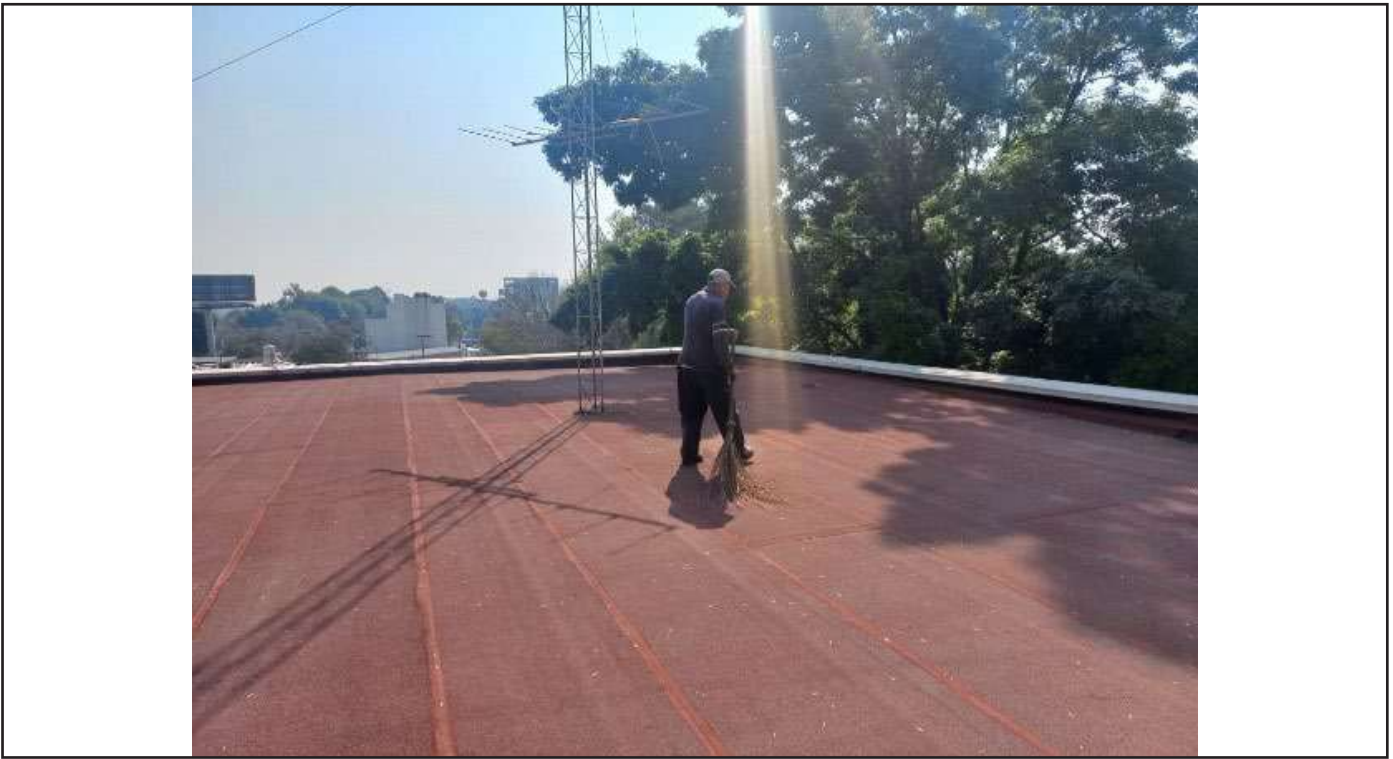
Barrido de azotea en edificio C
