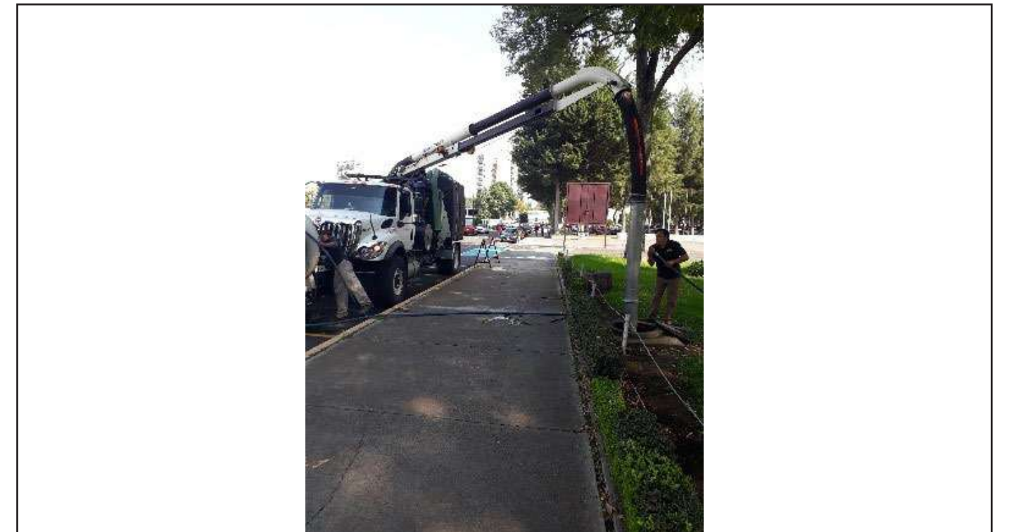
Desazolve con camión Vector en pozo de drenaje
