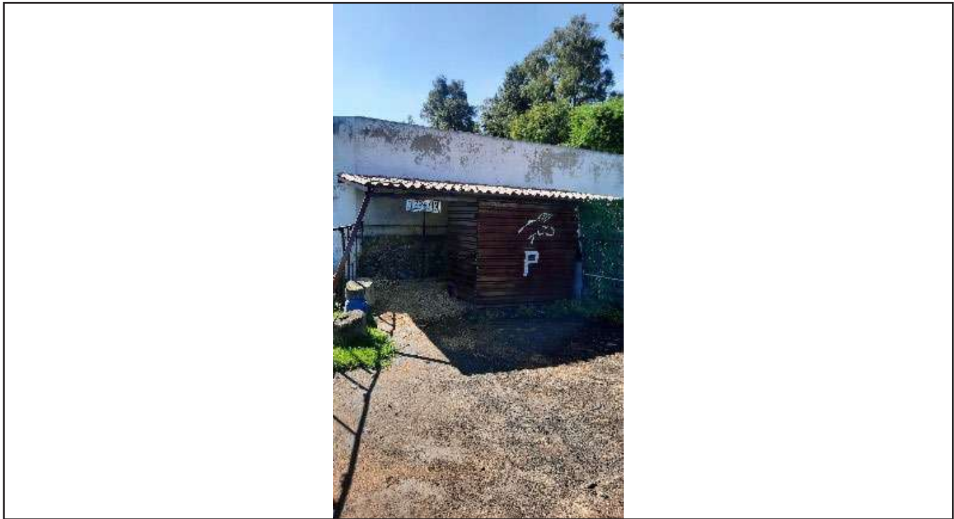
Aplicación de pintura en establo de “Tepepin”
