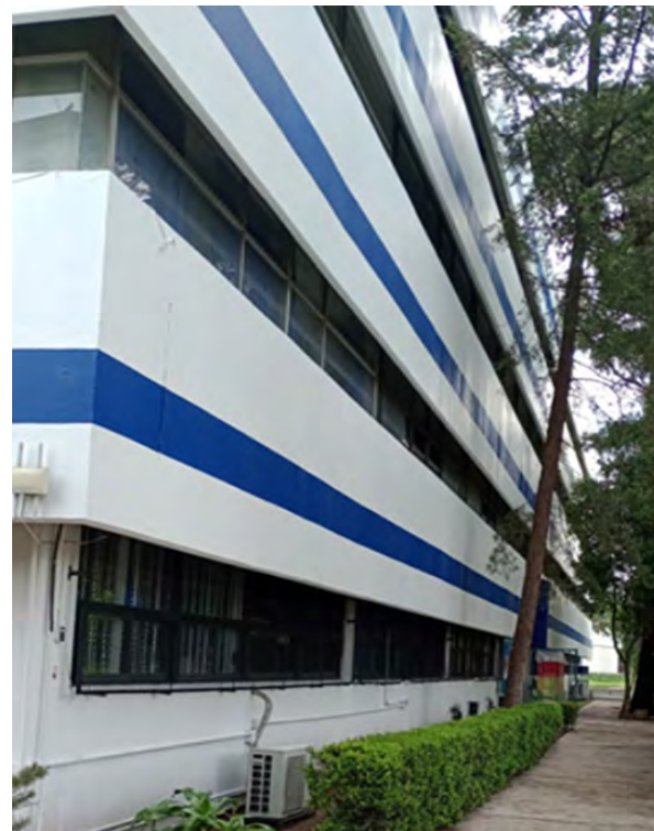
Mantenimiento de repellado y pintado al edificio de aulas
