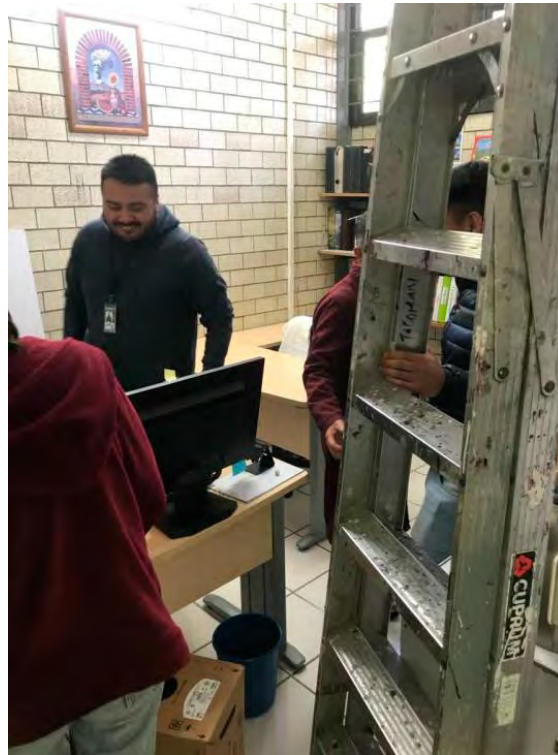
Instalación de un equipo de cómputo y cableado de voz y datos
