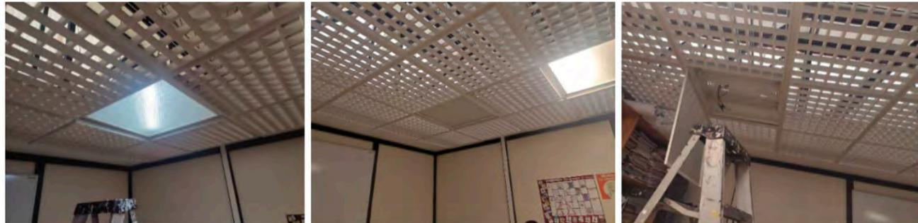
Cambio de luminarias del tipo balastro en gabinete por luminarias tipo led, en cubículos de profesores
