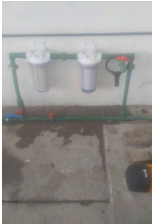
Colocación de filtros al hidroneumático de la UPIIT
