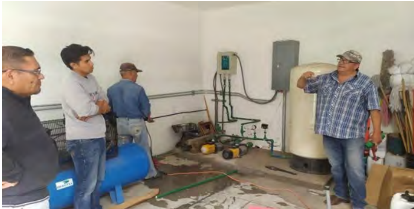
Mantenimiento al hidroneumático de la UPIIT
