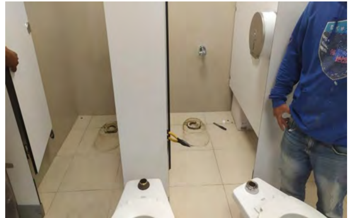
Reparación de fuga de agua en sanitarios de damas
