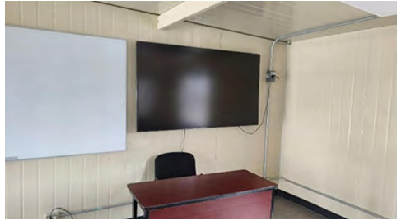
Pantallas repetidoras instaladas en las aulas provisionales
