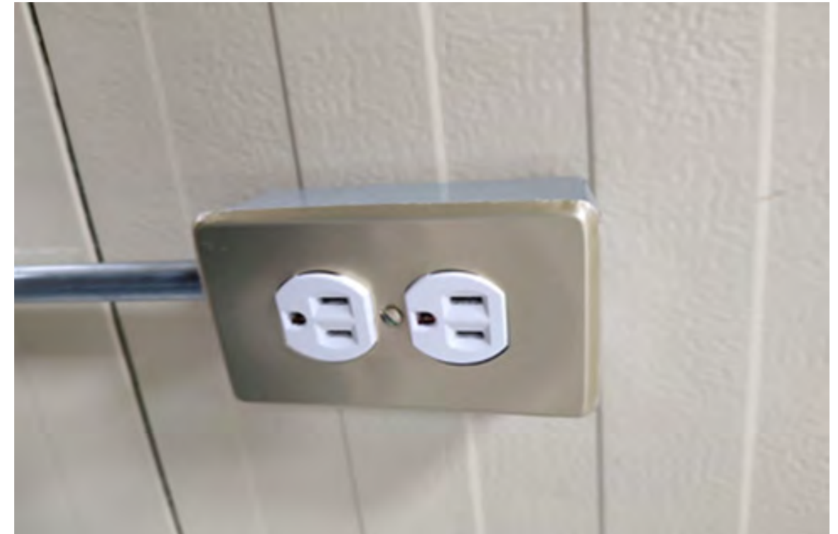
Cambio de tapas de los multicontactos en aulas provisionales
