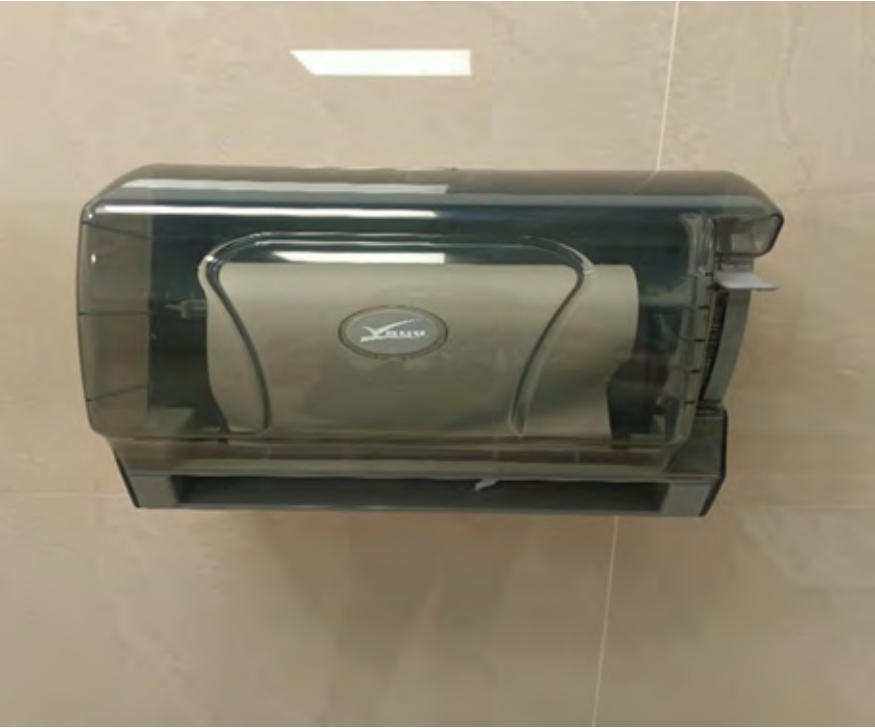
Colocación de dispensadores de papel en los sanitarios
