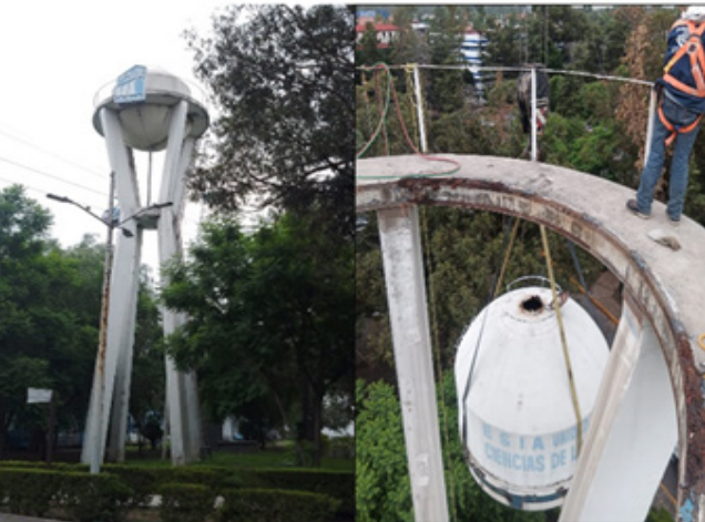
Mantenimiento de desmantelamiento de tanque elevado.
