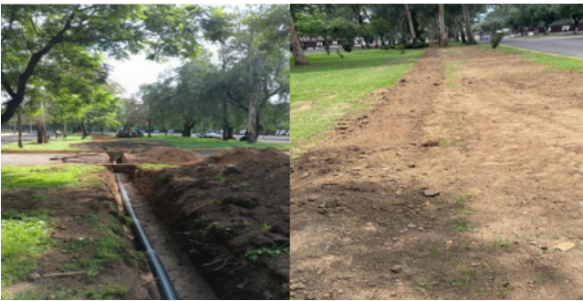
Mantenimiento a la red de agua potable de la UPALM del Instituto Politécnico Nacional.
