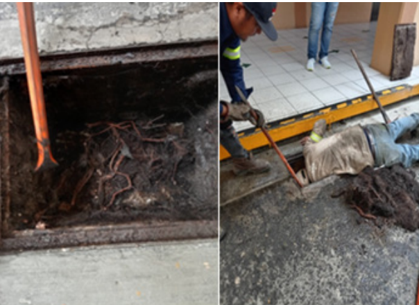
Servicio de desazolve a red drenaje en diversas dependencias.
