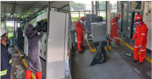
Mantenimiento a la subestación de media tensión de ESCA Tepepan.
