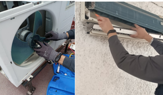
Mantenimiento a preventivo y correctivo a equipos de aire acondicionado del IPN.
