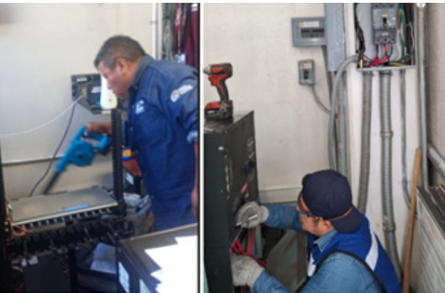
Mantenimiento preventivo y correctivo a ups del IPN.
