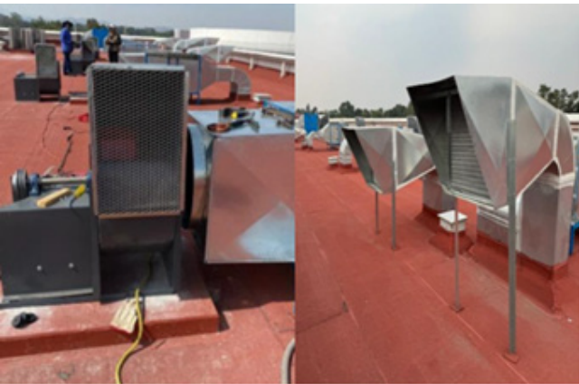
Mantenimiento a los extractores de aire en la ENCB.
