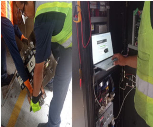
Mantenimiento de la unidad de transferencia en subestación del CECyT 3.
