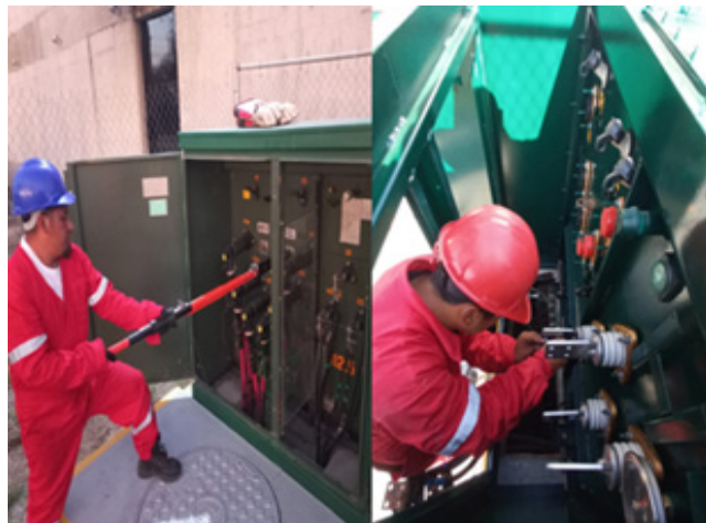
Mantenimiento a la subestación de media tensión de UPIIG
