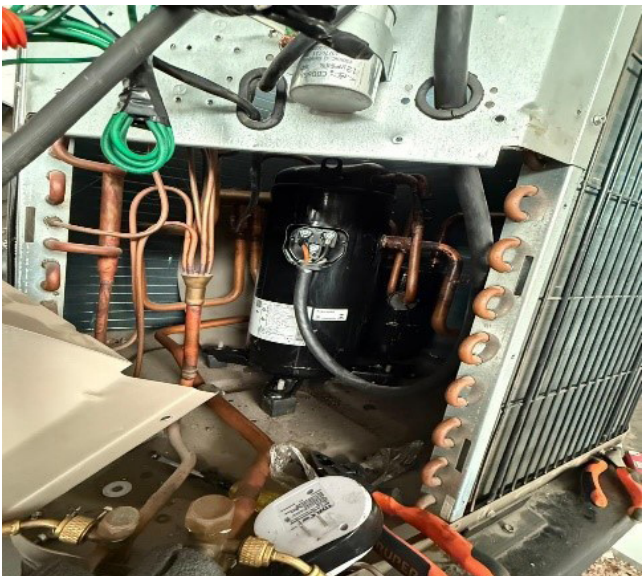
Mantenimiento a compresor de aire acondicionado.
