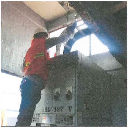
Mantenimiento a planta de subestación.
