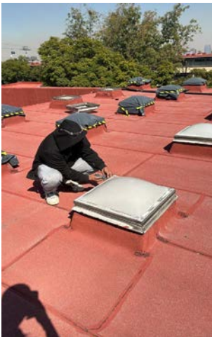
Reemplazo de domos colocados en azotea de edificio de gimnasio, 2024.
