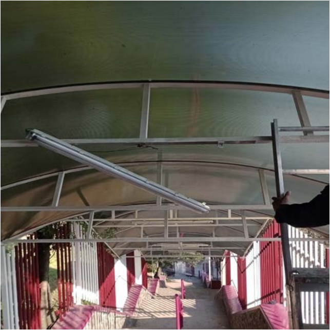
Cambio de lámparas balastras por led, 2024.
