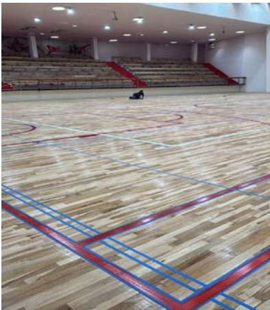
Colocación de duela a edificio de gimnasio, 2024.
