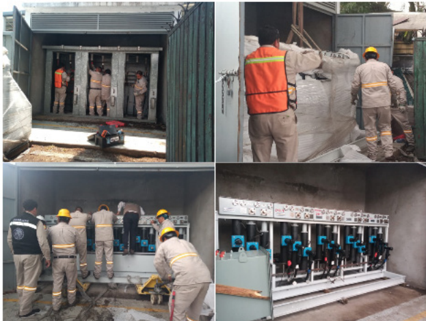
Cambio de equipo seccionador en subestación eléctrica.
