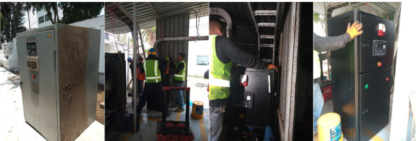
Mantenimiento preventivo a la planta de emergencia.
