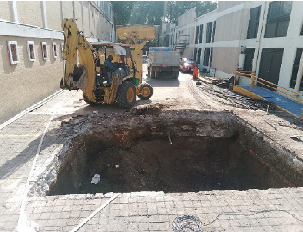
Construcción de cisterna para el optimo abastecimiento del agua para el Centro de Atención y Servicios de Odontología.
