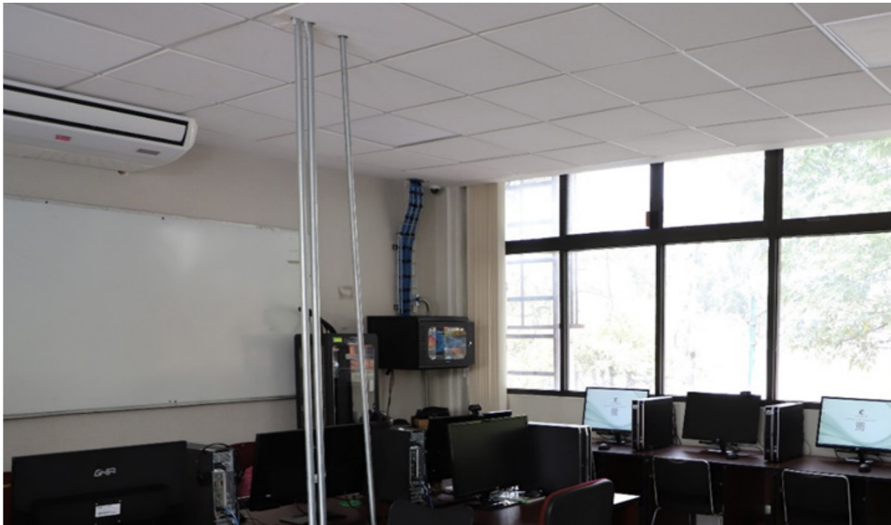
Enlaces de fibra óptica que conectan el MDF al site de posgrado en el aula CREA.
