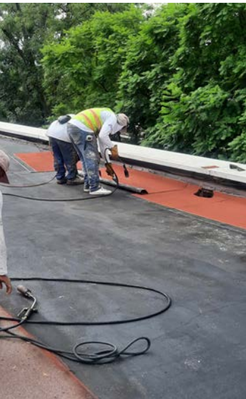
Instalación de impermeabilizante prefabricado de 5 mm. de espesor con soplete para termofusionar.
