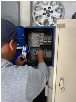
Reparación de tablero y cambio de interruptor termomagnético en el cuarto de máquinas de la alberca.
