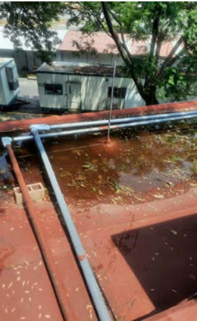
Bajada pluvial tapada en edificio de Gobierno que fue desazolvada.
