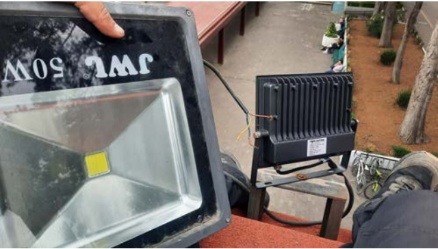
Reemplazo de reflector dañado.
