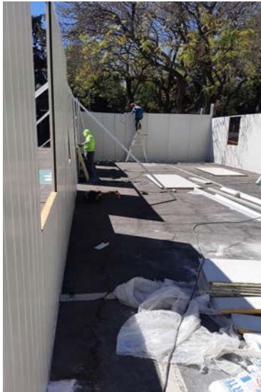
Armado de caseta prefabricada doble en el área de contenedor para uso de aula de clases.
