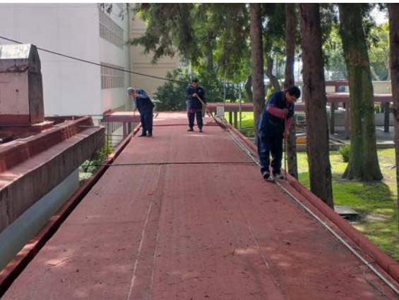
Barrido de andadores y sus canalones para evitar se tapen las bajadas pluviales.
