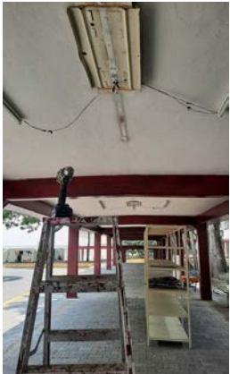
Retiro de luminarias dañadas y obsoletas en andador.
