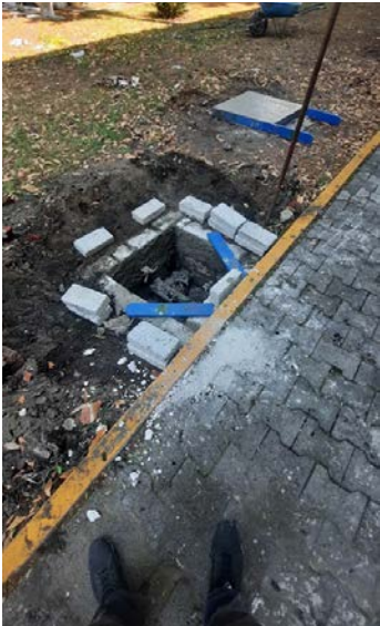
Rehabilitación de registros para voz y datos.
