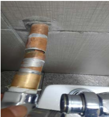
Desazolve de tuberías y fluxómetros tapados en los baños.
