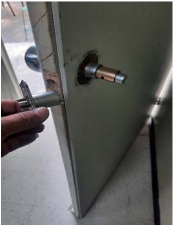
Mantenimiento y cambio de chapas que se han dañado por el uso.
