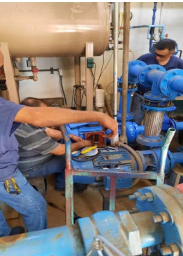
Retiro de bomba para su mantenimiento.
