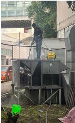
Lavado de los aires acondicionados de paquete del auditorio para tenerlos en buenas condiciones.
