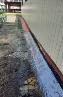
Sellado de las bases de las aulas con impermeabilizante asfáltico, para evitar que se introduzca el agua.
