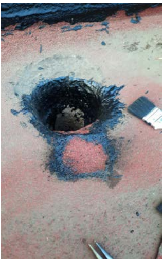
Sellado de bajada pluvial en edificio “A” con impermeabilizante vaporitite 500.
