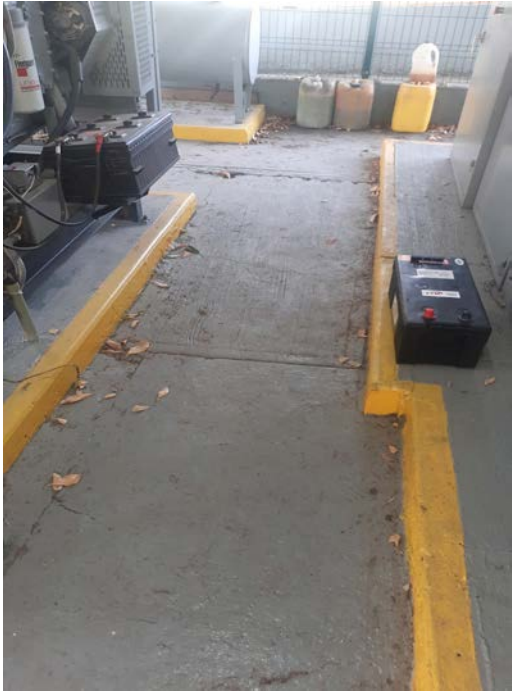
Reemplazo de batería en planta de emergencia.
