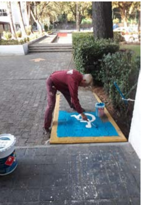
Pintado de rampas de discapacitados con sus señaléticas correspondientes
