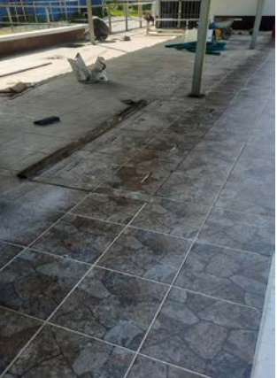
Reemplazo de loseta antiderrapante en zona de la alberca.
