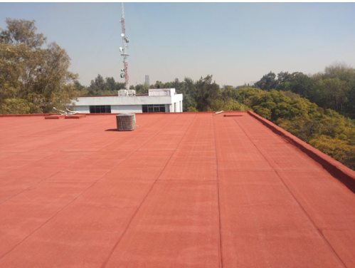
Impermeabilización en edificio de aulas.
