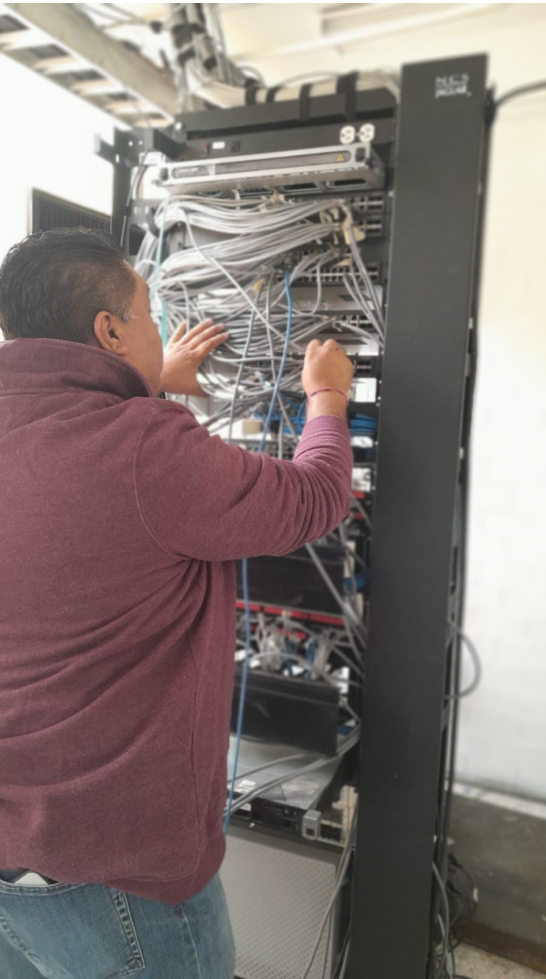
Mantenimiento preventivo, SITE principal de telecomunicaciones.
