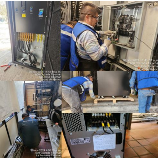
Mantenimiento preventivo y correctivo anual de los UPS.
