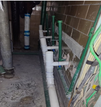
"Mantenimiento a red hidrosanitaria de ESIME Zacatenco".
