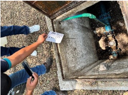
Atención de fugas de agua.
