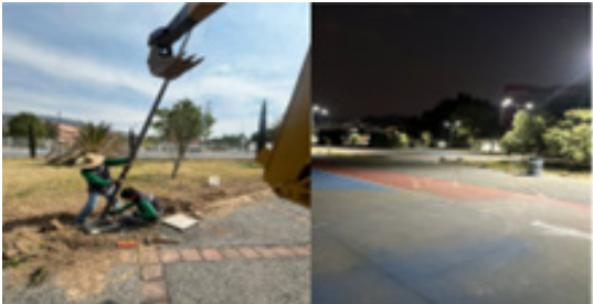
"Mantenimiento a la iluminación de UPIBI".
