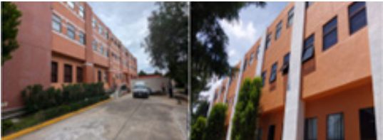
"Mantenimiento a la fachada y cancelería CIBA".
