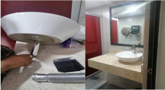
"Mantenimiento a los baños ESM".
