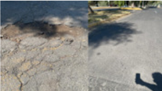
"Mantenimiento de bacheo".
