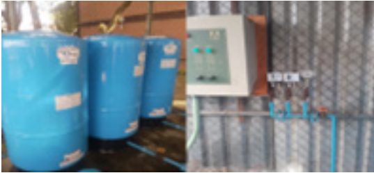
“Mantenimiento a sistema hidroneumático CECYT 2”.
