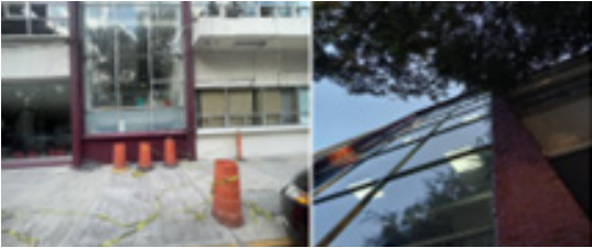
“Mantenimiento de la Escuela Superior de Medicina”.
