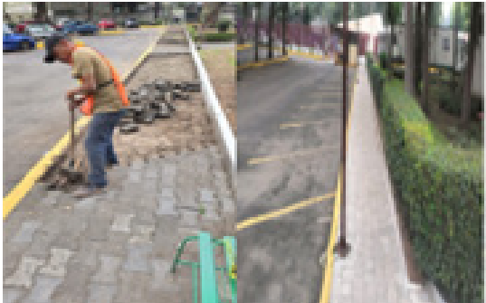
"Mantenimiento de andador de ESCA Tepepan".
