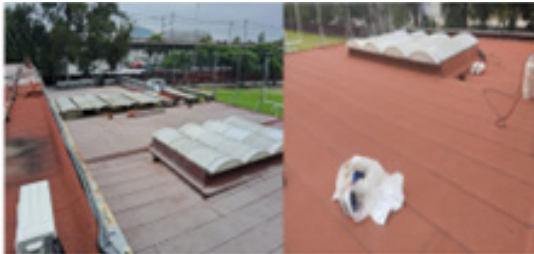
“Mantenimiento de impermeabilización del CECYT 7”.
