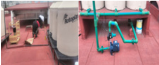
"Mantenimiento a red hidrosanitaria de la ENBA".
