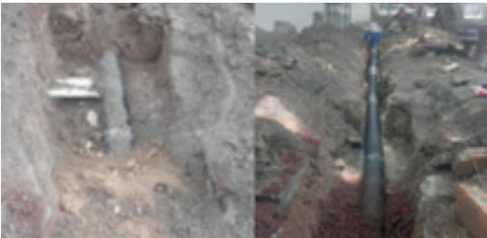
"Mantenimiento a tubería del ESCA".
