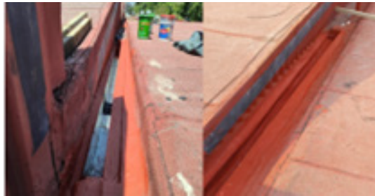
“Mantenimiento de canalones de ESIME Zacatenco”.
