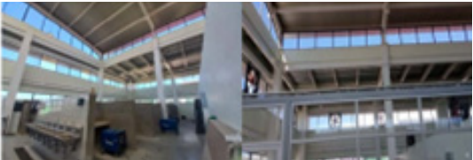
“Mantenimiento de extractores de aires en CECYT 16”.
