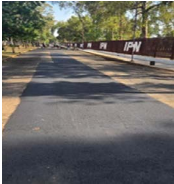
“Mantenimiento y bacheo a la Av. Manuel de Anda y Barredo”.
