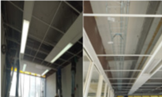
"Mantenimiento a instalaciones de voz y datos de ESFM".
