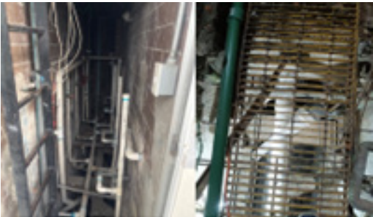
"Mantenimiento y conservación a las instalaciones sanitarias ESIME Zacatenco"
