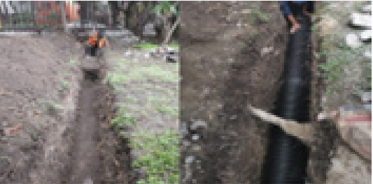
"Mantenimiento a red de drenaje campo carrillón".
