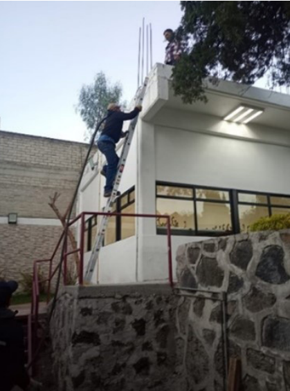
Revisión de tuberías.
