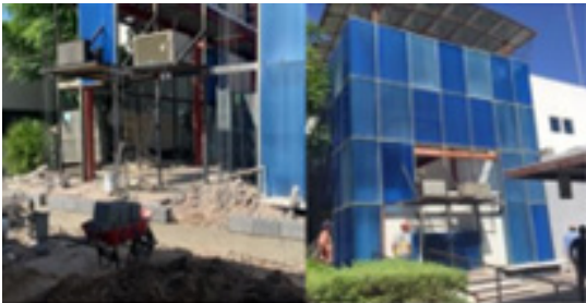
"Mantenimiento a el área de refrigeración CBG Campus Reynosa".
