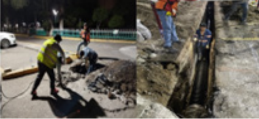
"Mantenimiento a la red de drenaje CECYT 2".
