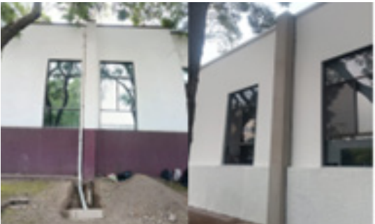
"Mantenimiento de bajadas pluviales del Decanato.
