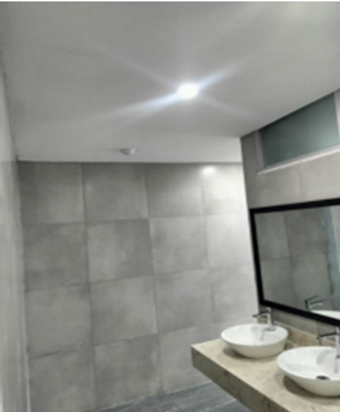
"Mantenimiento a los baños del CET 1 Walter Cross".
