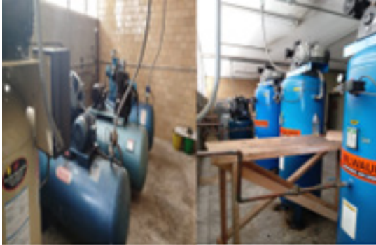
"Mantenimiento a compresores de CICS Unidad Milpa Alta".
