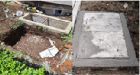
"Mantenimiento a red de drenaje ESCOM y ESIQIE".
