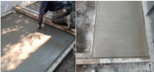
“Mantenimiento a los talleres ESIME Azcapotzalco”.
