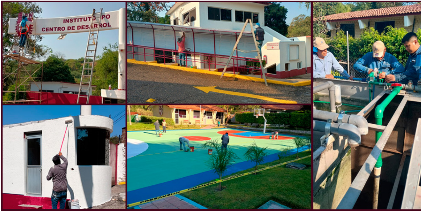
Mantenimiento de diversas áreas del CEPROBI.
