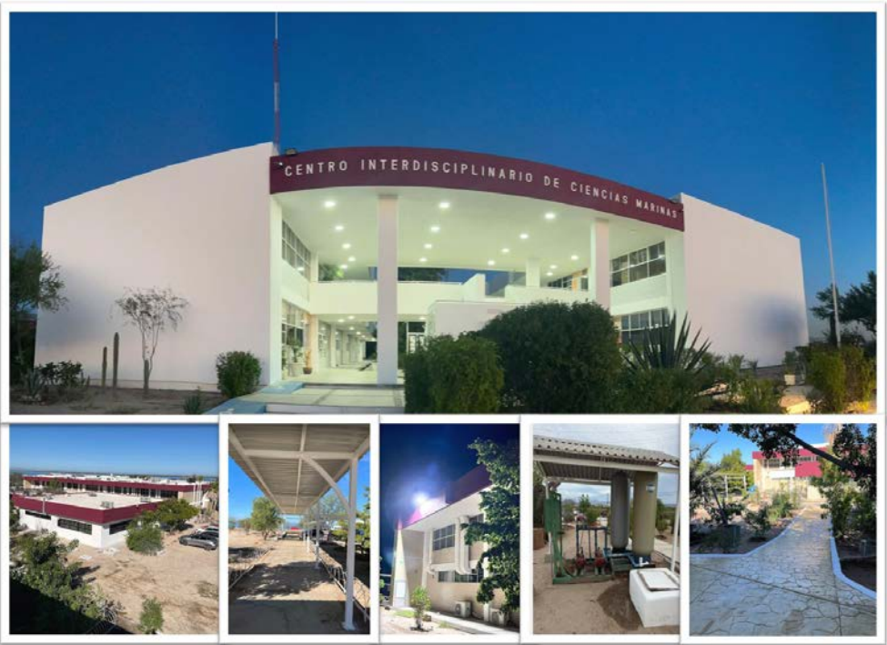
Se destinó una importante inversión en obras de mantenimiento mayor a los edificios del CICIMAR.
