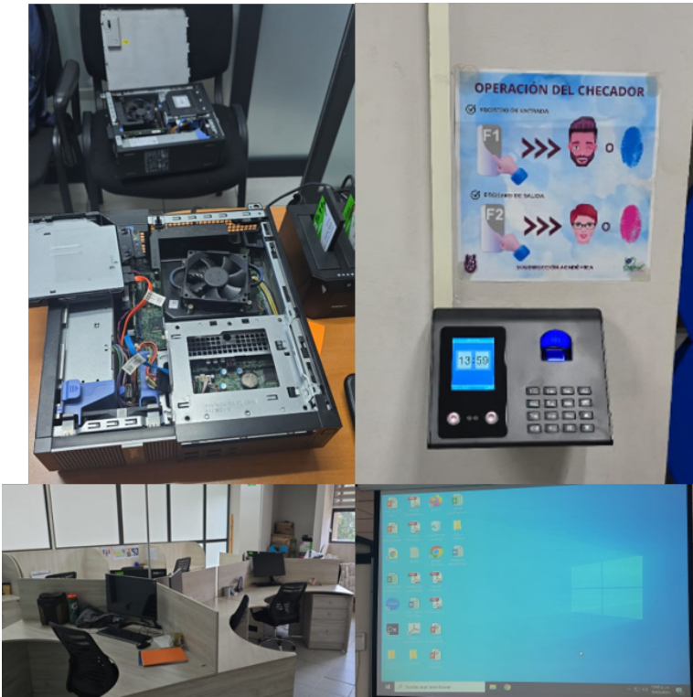
Mantenimiento a equipo de TI del CMP+L.
