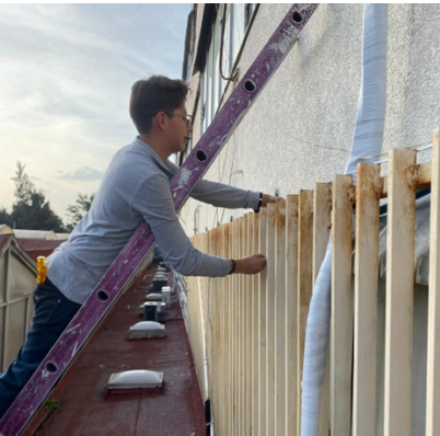
Integrante de la Unidad de Informática del CECyT No. 1 realizando la sustitución del cableado de red externo.
