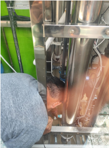
Reparación del sistema de bombeo de agua de CECyT No. 1.
