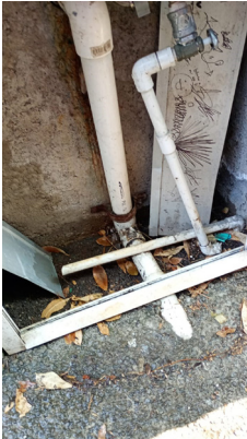
Reparación de fuga en el sistema de agua potable del edificio de la UTE del CECyT No. 1.
