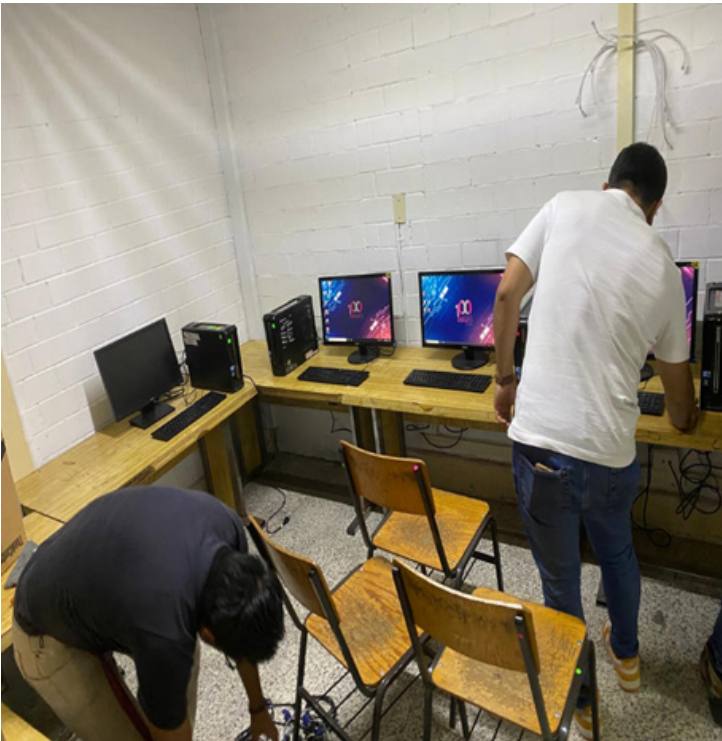
Equipo de la Unidad de Informática del CECyT No. 1 realizando la instalación tecnológica en el espacio destinado al taller de Mecatrónica.
