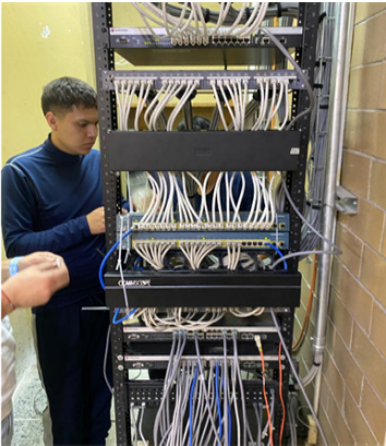
Equipo de la Unidad de Informática del CECyT No. 1 realizando la administración y peinado del cableado estructurado en los racks de comunicaciones del edificio de aulas.
