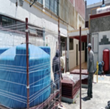
Colocación de malla ciclónica a cisterna.
