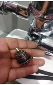
Reparación de puertas y chapas
