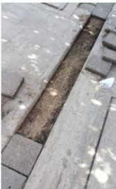
Reemplazo de adoquines
