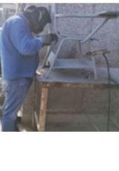
Reparación de pupitres
